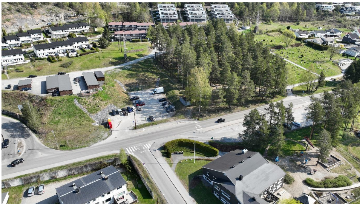
Figur 39. Oversiktsbilde (drone) over Stensetlokaliteten, som trolig er bygd ned.
