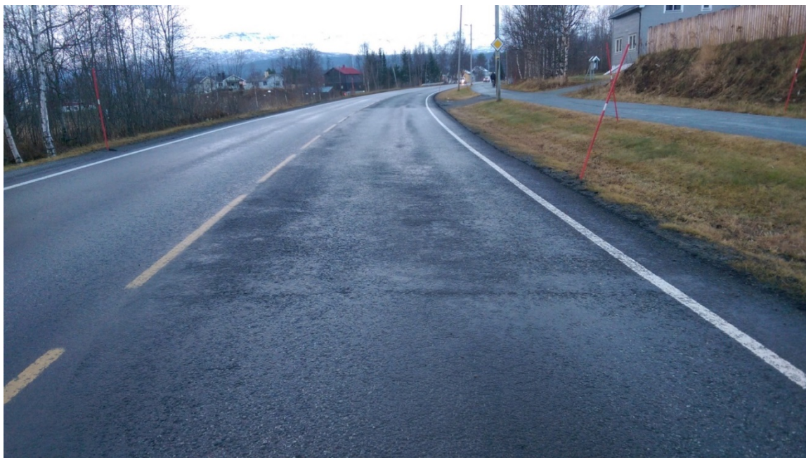
Figur 12 Kald asfalt fra båt utlagt på veg
