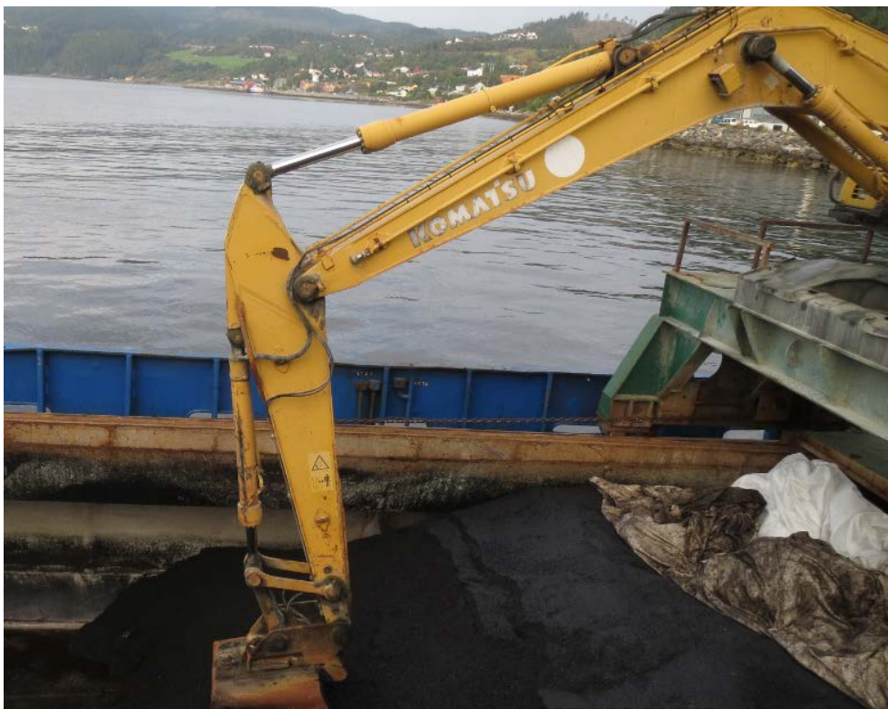
Figur 7 Lossing av båt med gravemaskin
