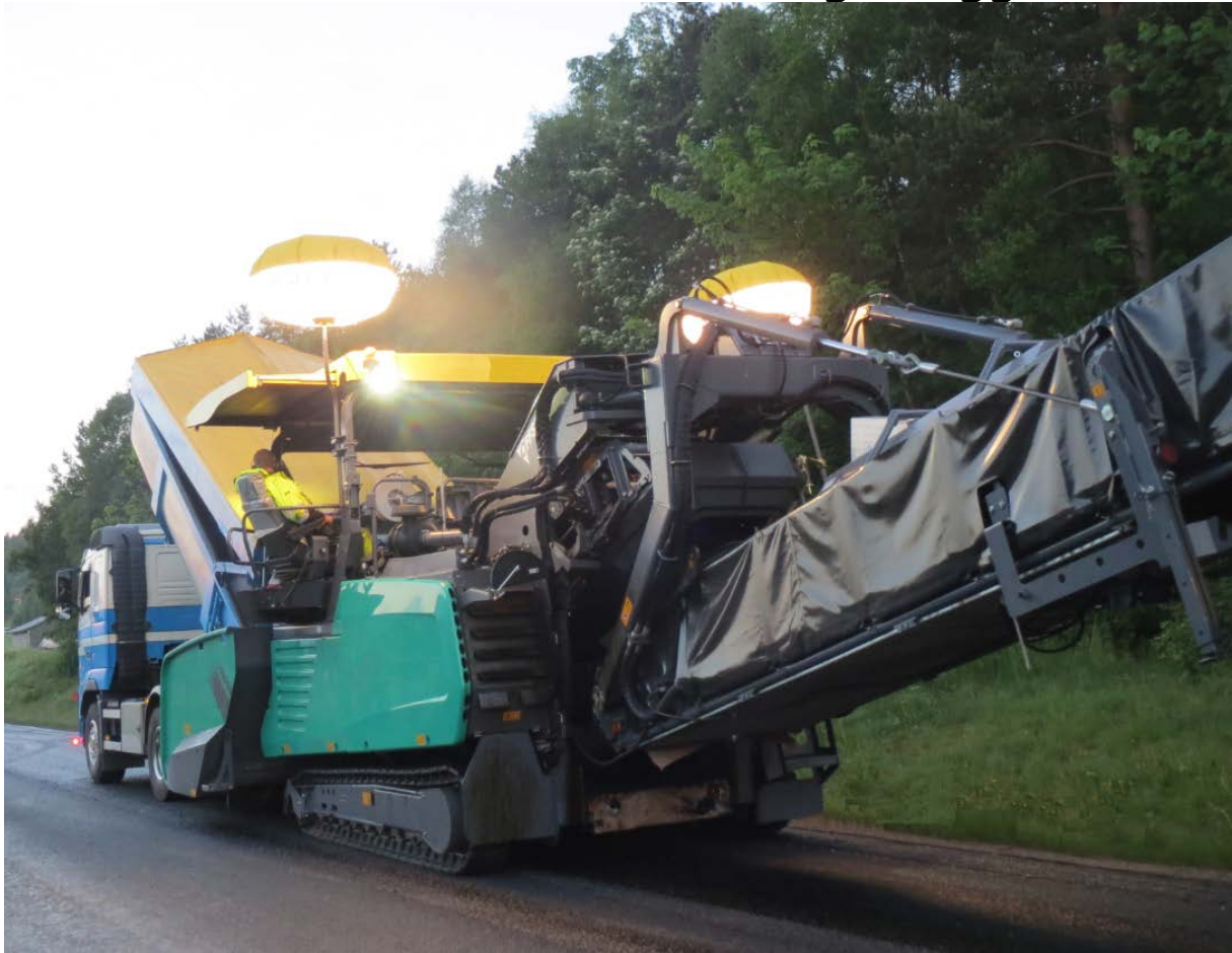
Figur 13 Formater mellom lastebil og utlegger
