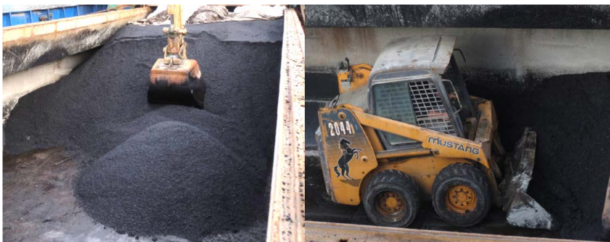
Figur 11 Oppsamling av kantmasse med hjullaster
