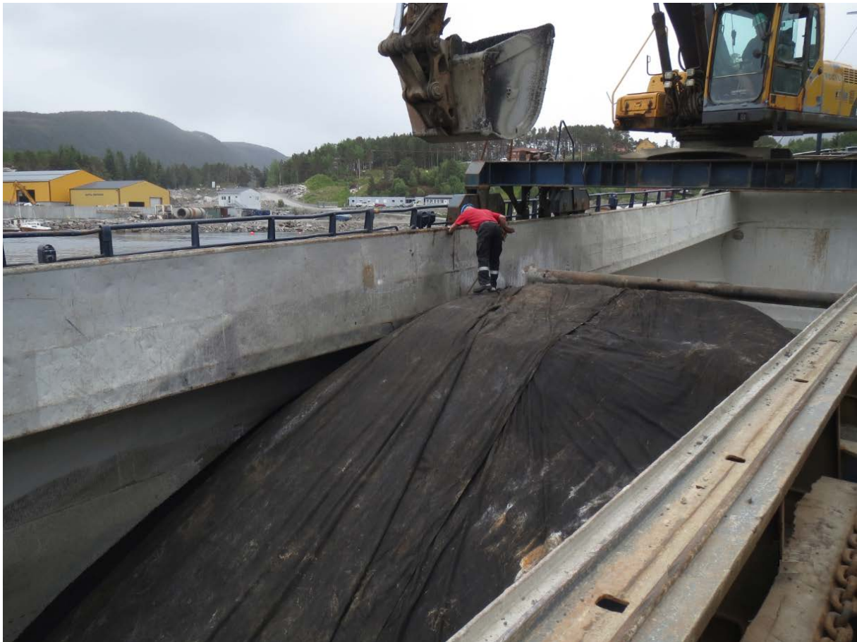
Figur 5 Tildekking med fiberduk
