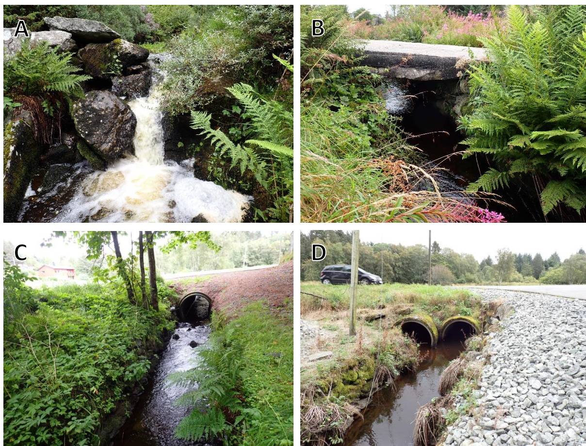
Figur 55. Vandringshindre og bekkelukkinger: A) Kunstig temporært vandringshinder etter gammel mølle. B) Kort bekkelukking nederst i elven. C) og D) Rør under Breiabergvegen og Vestre Veaveg. Rørene ligger fint for vandring av både laksefisk og ål.
