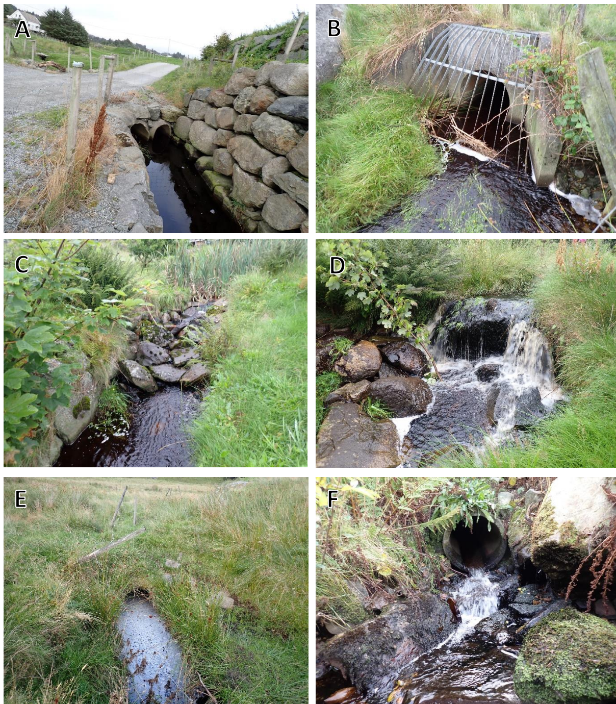
Figur 7. Vandringshindre og bekkelukkinger i Sandvebekken. A). Forbygning med rør under veien til parkeringsplassen nederst ved bekkemunningen (segment 2). Rørene kan godt passeres av anadrom fisk og ål. B) Forbygning med rør og rist under Vestre Karmøyveg i det nordre løpet. C) Temporært vandringshinder øverst i nordre del av bekken (segment 16). D) Absolutt vandringshinder i det nordre løpet. E) Nedre del av røret i østre del av bekken mellom segment 24 og 25. F) Rør under vei mellom segment 26 og 27, med vanskelig inngang og noe bratt helning, danner et absolutt oppvandringshinder.
