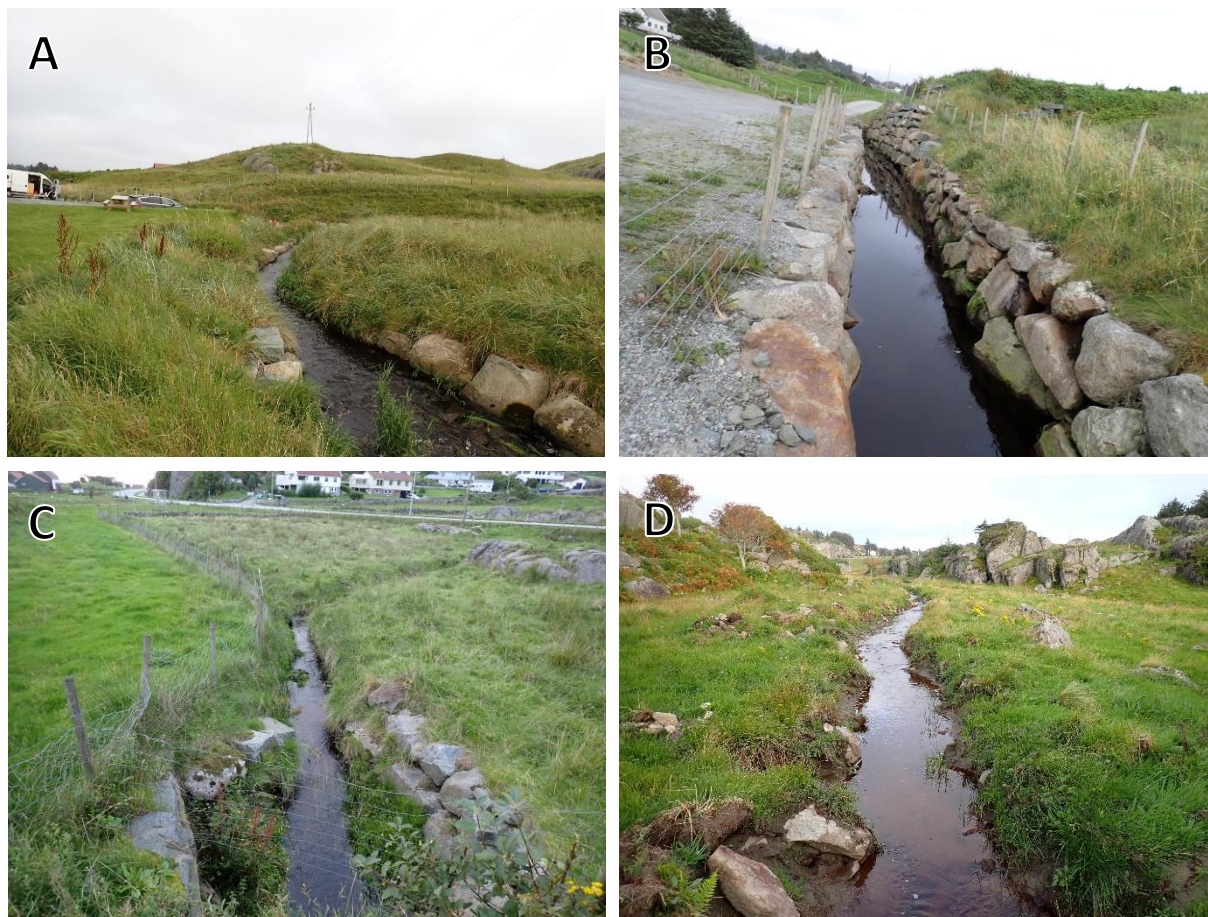
Figur 8. Morfologiske inngrep i Sandvebekken. A) Utrettet og kanalisert strekning med delvis steinlagt elvebredde nederst i elven. B) Kanalisert strekning med steinmur langs parkeringsplassen I dette området går bekken tørr når vannføringen er spesielt liten. C) Kanalisert og forbygd strekning uten kantvegetasjon i segment 14. D) Strekning uten kantvegetasjon i segment 20.
