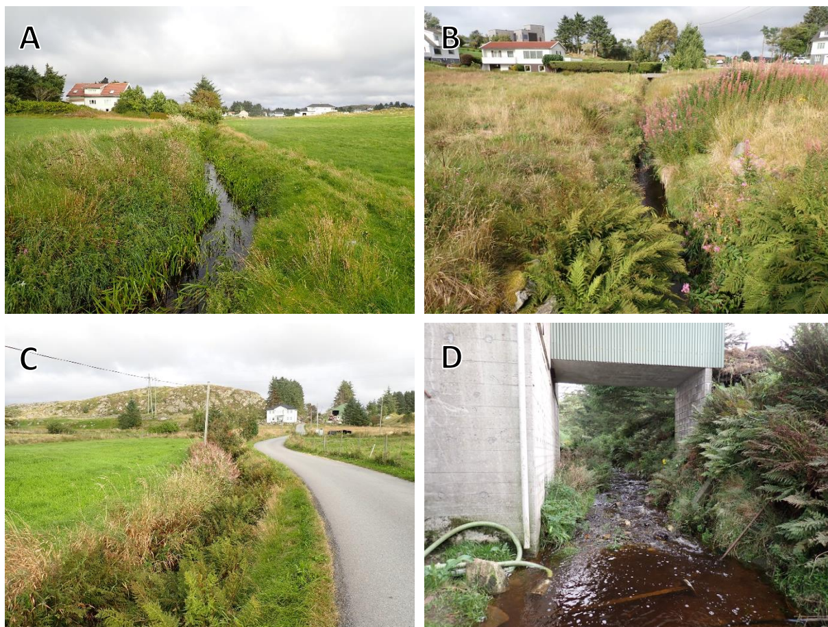
Figur 18. Morfologiske inngrep i Liknesbekken. A) Kanalisert og forbygd strekning uten kantvegetasjon nederst i segment 2. B) Utrettet strekning med manglende kantvegetasjon og forbygning langs bankene øverst i segment 2. C) Kanalisert bekkeløp langs bilveien i segment 11/12. D) Driftsbygning for jordbruk bygget rett ved siden av og over bekken nederst i segment 15.
