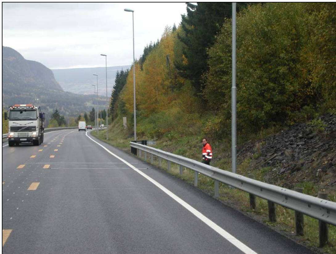
Figur 1.2 Utforming av midtfelt der forbikjøring tillates. Dobbel kjørefeltlinje uten nedfresing av rumlefelt i asfaltdekket.
