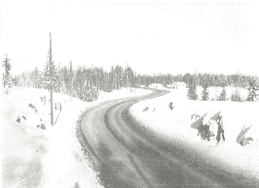
Figur 17. E6 fra Stein til Vestbysvingen. Strekningen er uoversiktlig pga. fjellknauser.
