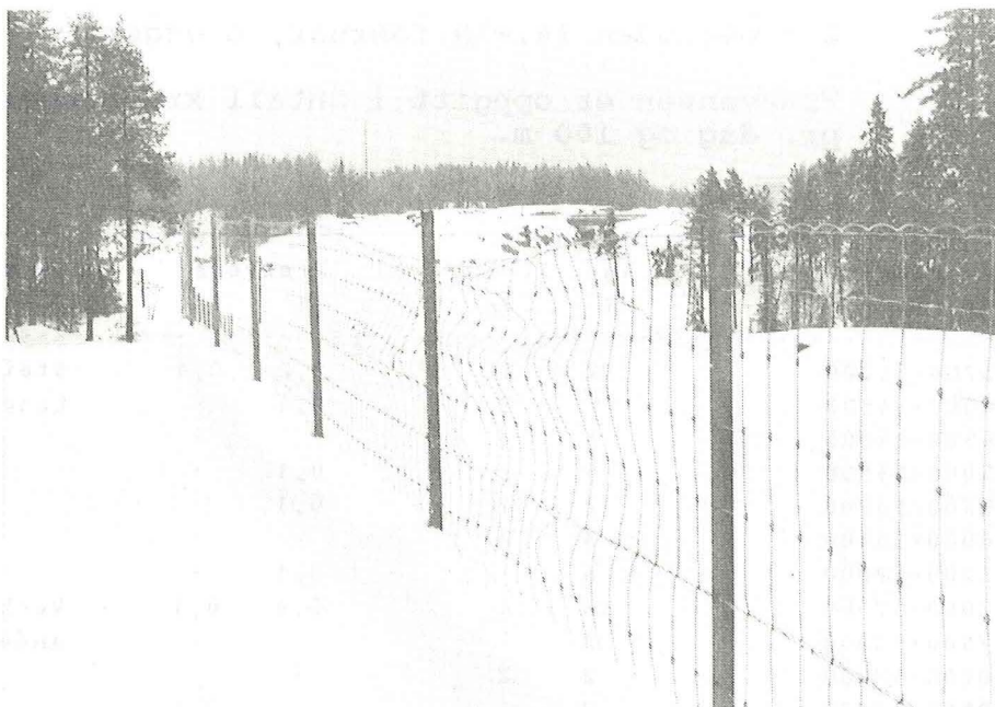
Figur 7. Elggjærdet langs ny trase for E6 ved Staviåsen. Elgen har her hoppet over gjærdet fordi det er for lavt.
