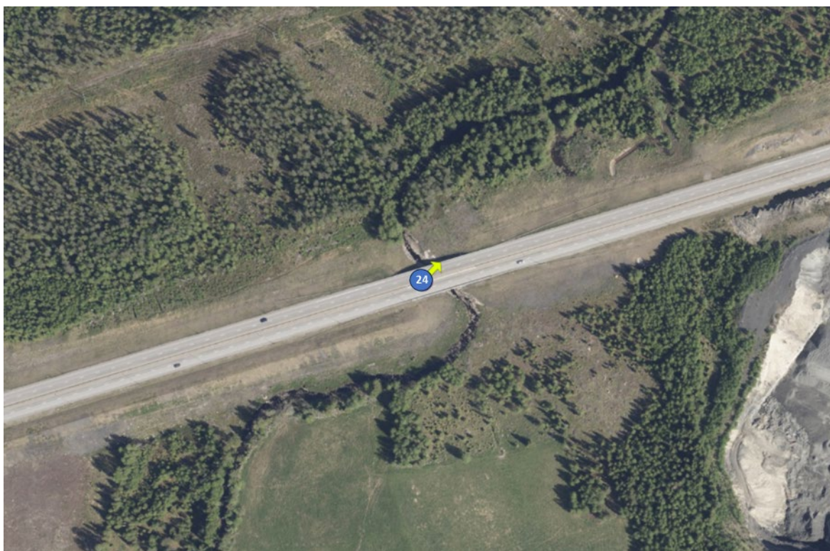
Figur 6. Faunapassasjen under brua som krysser Terningåa (Terninga ved Midtskogen). Sirkel viser plasseringen av viltkameraet, mens gul pil indikerer himmelretning til viltkameraet. Bakgrunnsfoto: Norge i bilder.
