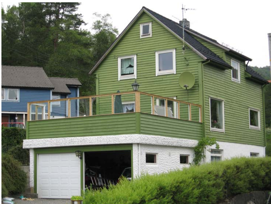
Figur B.3: Bergen, Sædalsvege 150. Skjerm på terrasse. Bolighuset har gjennomgått omfattende fasadeendringer og påbygninger som fører til et relativt uharmonisk uttrykk. Støyskjermen av glass som er montert på terrassen er med på å forsterke dette uttrykket. Støyskjermens formater virker tilfeldig valgt og tar ikke hensyn til verken horisontale eller vertikale elementer i den eksisterende bygningsmassen. Se også Figur B.4 Sædalsveien 132.
