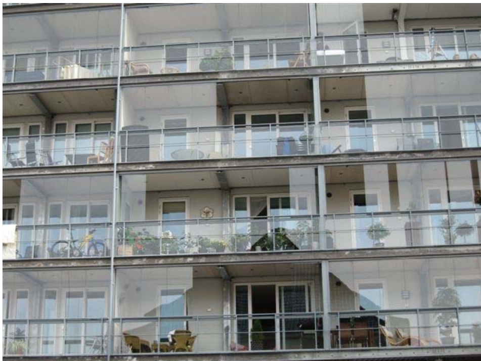
Figur D.2: Bergen, Nordnes Brygge. Endret fra næringsbygg til boliger. Innglassete balkonger med metallprofiler på betongdekker båret av metallknekt. Boligene har balansert ventilasjon.
