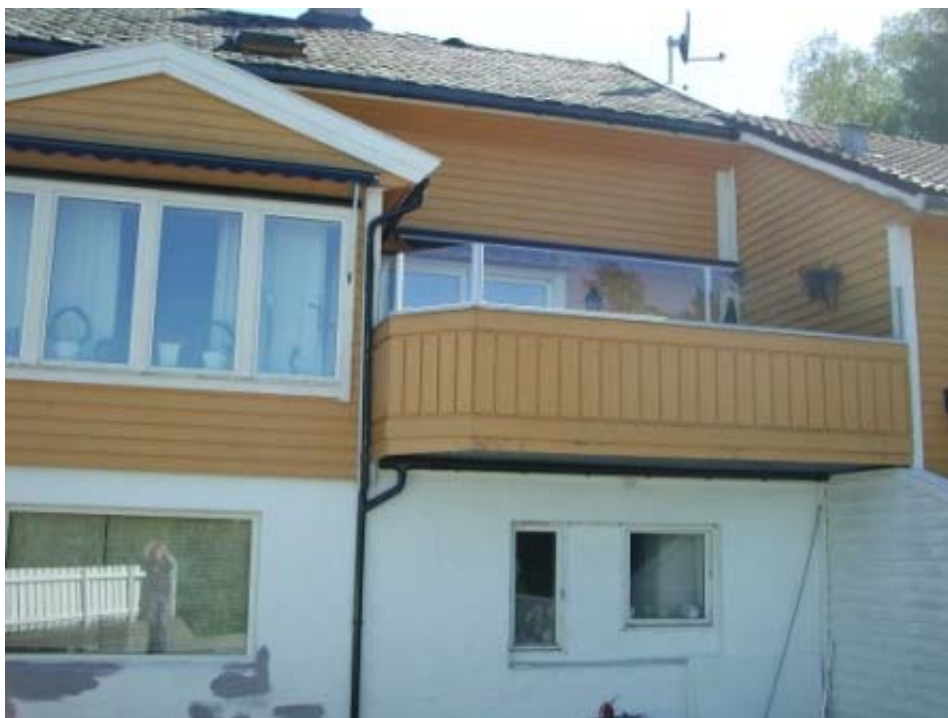
Figur B.5: Bergen, Troidhaugveien 70A. Skjerm på balkong. En lett skjerm med tynne profiler som fører til at skjermen knapt er synlig. Underordner seg byggets arkitektur.
