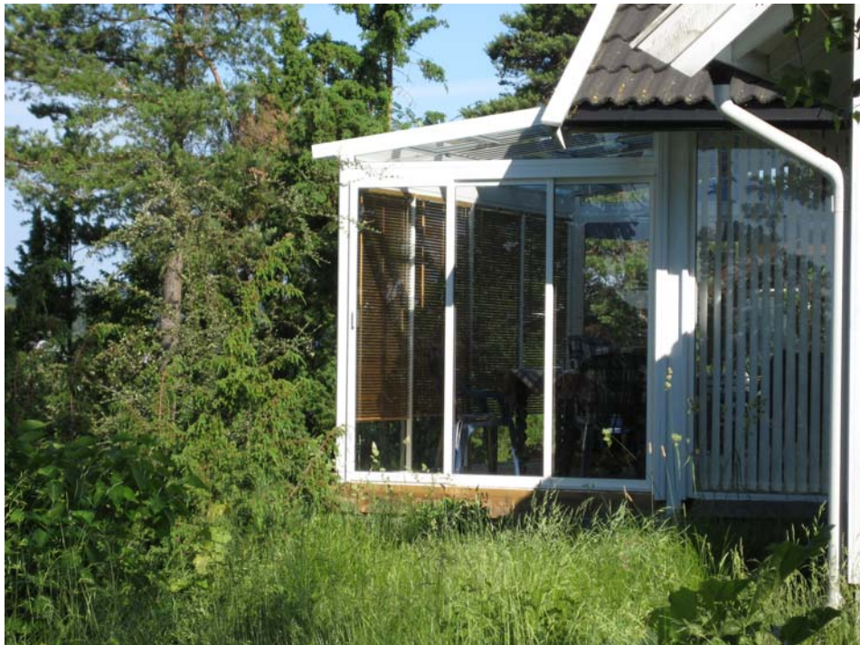
Figur D.3: E18, Presterødåsen. Vinterhage ved småhus. Akryl i tak og front. Skyvefelt i glass. Totalkostnad kr 160.000+mva.
