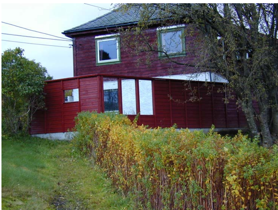
Figur A.8: Bergen, Steinsvikveien. Skjermen er brutt opp i tette og transparente felt med kraftige, vertikale sprosser. Skjermen fremstår som en helhet hvor det er tydelig at en har prøvd å tilpasse den skjermede uteplassen til den eksisterende bebyggelsen.
