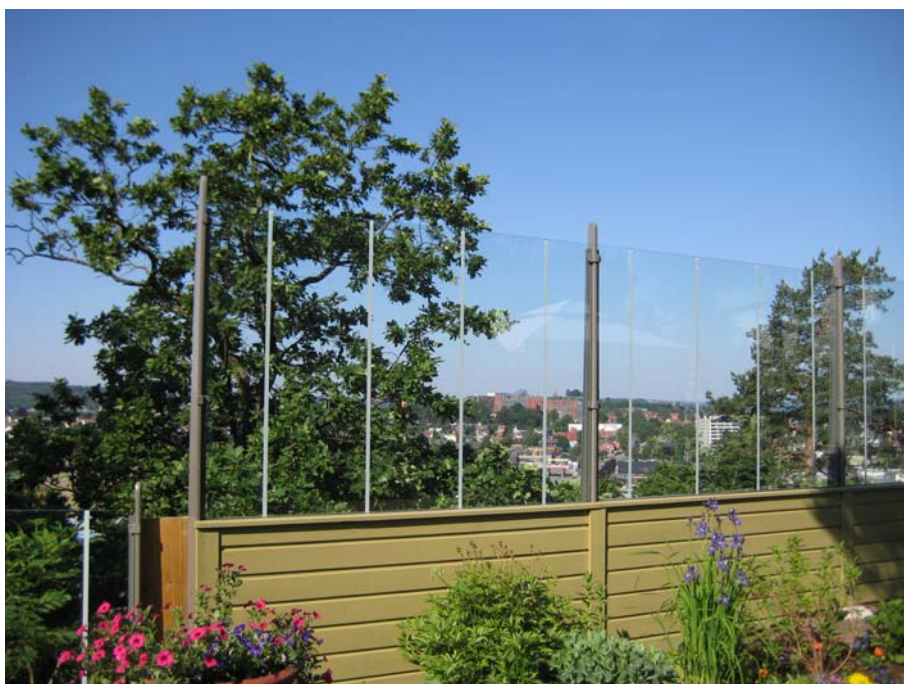
Figur A.2: E18, Tønsberg, Presterødåsen. Skjerm med 2 cm vertikale striper i 50 cm avstand. Skjermen fremstår som lett og transparent med ståldetaljer. Glasset her en elegant innfesting og til tross for de vertikale stripene fremstår skjermen med et luftig preg. Selv om den bryter med eksisterende bygningselementer underordner den seg stedets karakter.
