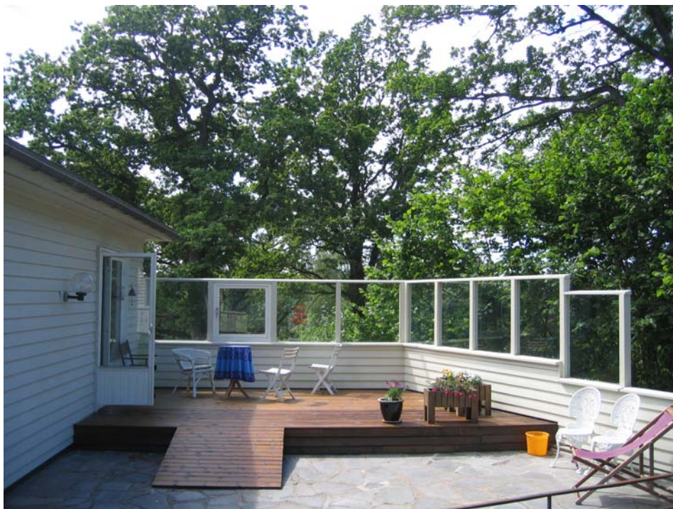
Figur B.1: E18, Tønsberg, Kjellelia. En har her søkt å tilpasse støyskjermen til bolighuset i materialvalg, detaljering og fargebruk, og fra den viste vinkel kan det se ut som en har oppnådd et hederlig resultat. Glasset er oppdelt i gode formater med en beskjeden omramning i tre. Å bryte med et åpningsfelt er positivt men avslutningen med et sprang som følger rekkverket er uheldig.
