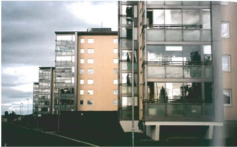
Figur D.1: Lillestrøm. Eksisterende boligblokker med vinterhage som beskyttelse mot støy fra Gardermobanen. I tillegg til innglassing ble balkongene utvidet. Det ble støpt nye balkongdekker som fikk nytt bæresystem. De gamle balkonger var utkraget mens nye balkonger har søyler. Store fundamenteringskostnader. Balansert ventilasjon, både av boliger og vinterhager. Mulighet for forsert ventilasjon, men ingen kjøling. Fra side 294 i Håndbok 248.
