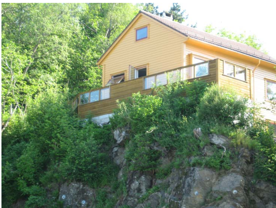
Figur B.8: Bergen, Wernersholmvei 49. Ny, tung terrasse med skjerm. Uheldig plassering og utforming av ny uteplass. Fremstår som et klart brudd i forhold til eksisterende bebyggelse. Uteplassen burde vært plassert på bakken uten kraftige betongkonstruksjoner.
