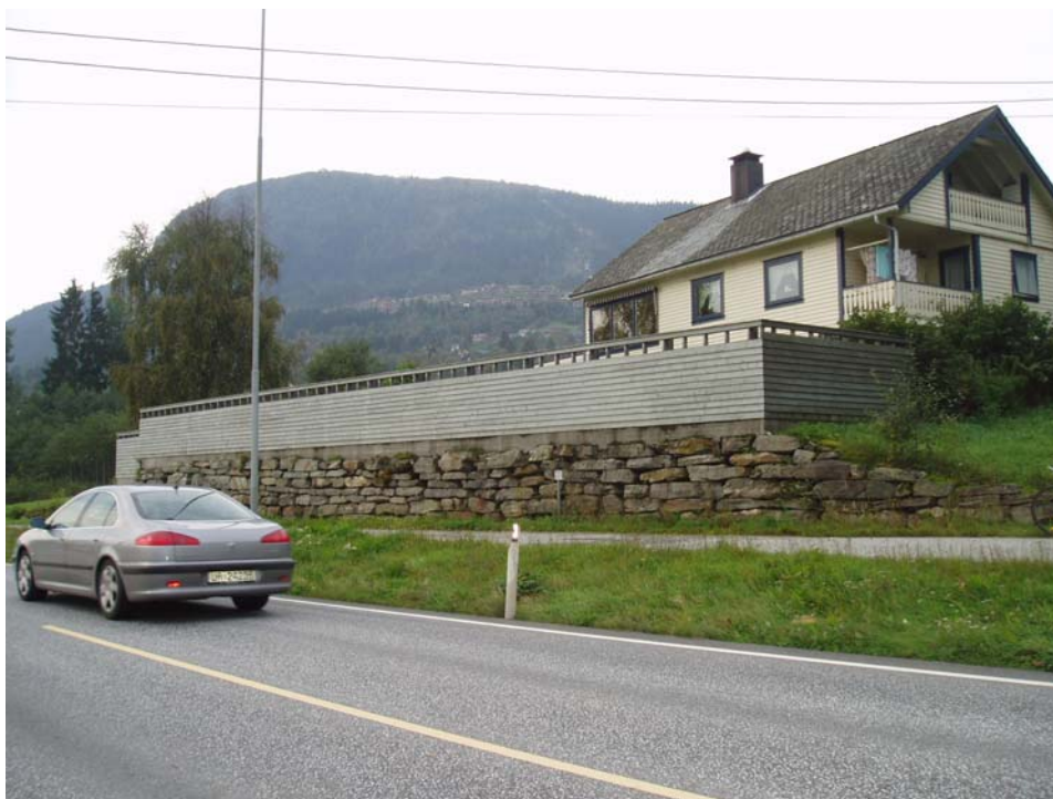
Figur A.5: E16, Voss, Gjerskvål. Lett områdeskjerm på tørrmur ved anlegg av gang- og sykkelveg. Skjermen fremstår som lang og monoton og tar ikke hensyn til eksisterende bebyggelse.
