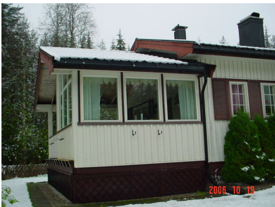
Figur B.6: Hedmark, Storelvdal. Åpen terrasse delvis bygget inn. Fremstår som et eget tilbygg og ikke som en støyskjerm. Vindusformater bryter med eksisterende bygning på en uheldig måte. Støy redusert fra 62 til 55 dB. Kostnad Kr. 110.000 (2005).
