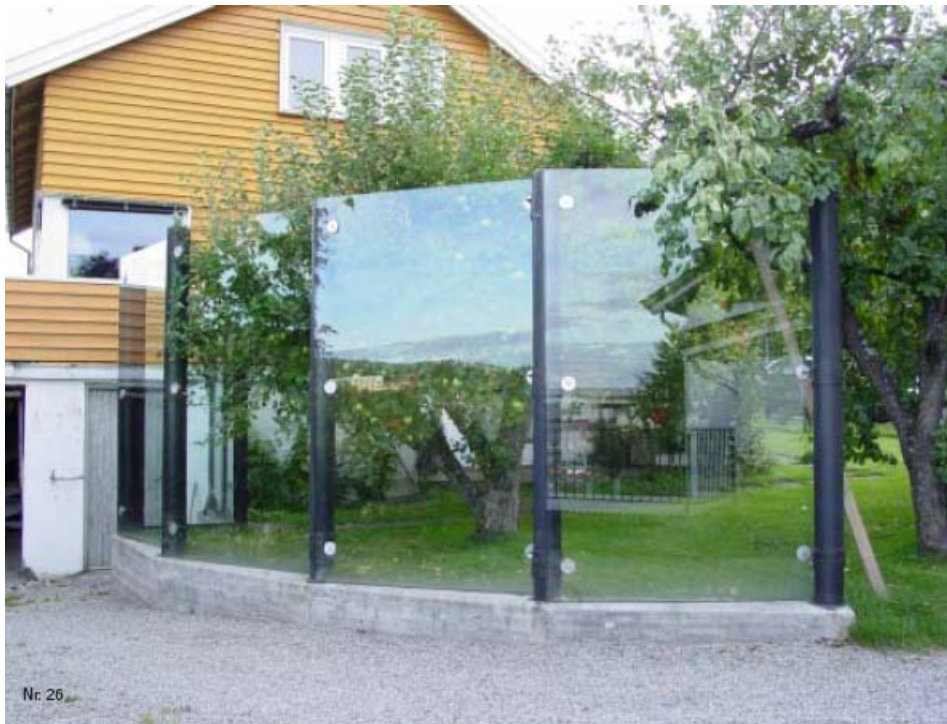
Figur A.9: Bergslia 26. Fra Statens vegvesen sitt utkast til idékatalog om støyttiltak, nov.2006 (Arkitekt: Jensen&Skodvin, byggeår 2000).
