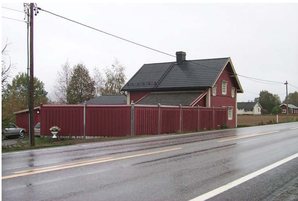
Figur A.4: Rv. 2, Hedmark. Stort uteareal er skjermet. Dimensjonert og utført som tradisjonell områdeskjerm langs veg. Materialebruk, fargesetting og detaljering er tilpasset eksisterende bebyggelse. Støyen er blitt redusert fra 74 til 64 dB i referansepunkt. Kostnad: Ca kr 200.000 (2000).
