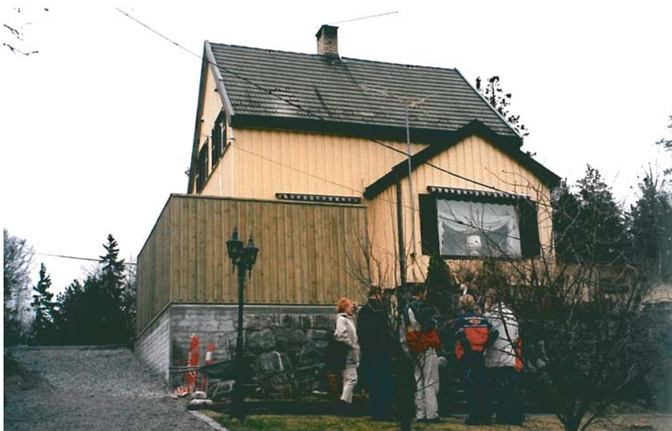
Figur B.7: Eksempel fra side 284 i håndbok 248. Skjernet terrasse. Dimensjonert som områdeskjerm langs veg, og virker visuelt tung. Har ikke transparente felt og hindrer utsikt og lys. Skjernet terrasse får sideinnfall av støy gjennom stor åpning på høyre side, jfr. fig 2, side 6.
