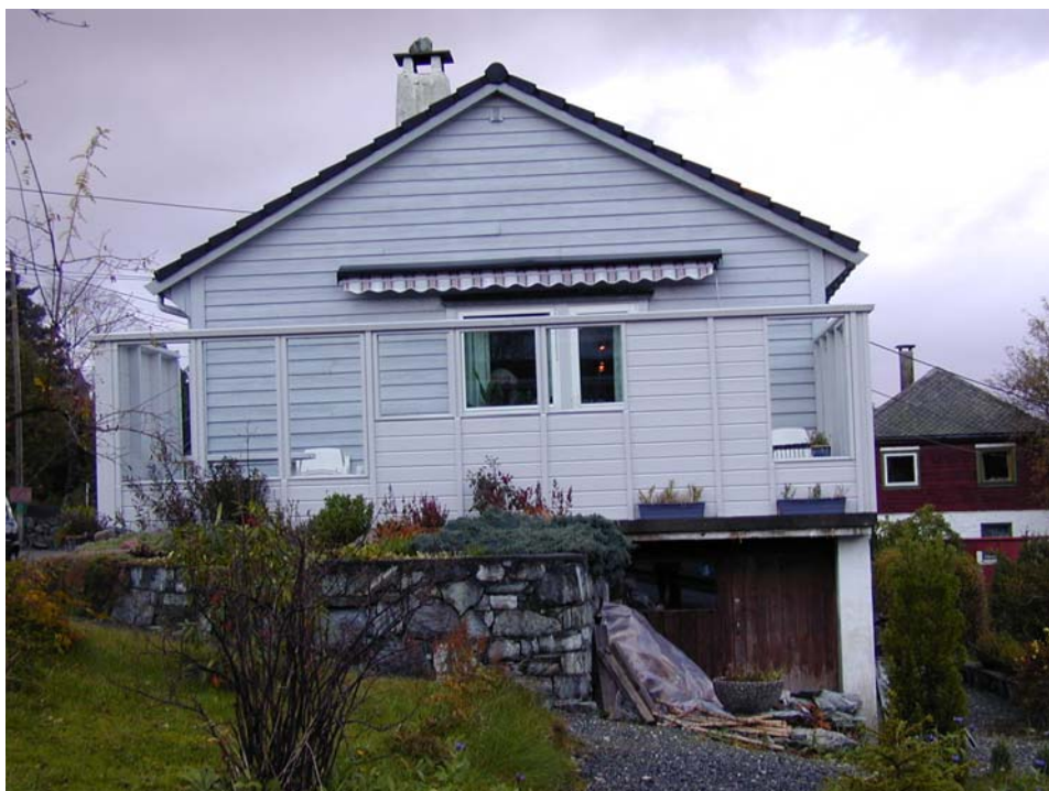
Figur A.7: Bergen, Steinsvikveien. Skjermen er brutt opp i tette og transparente felt med kraftige, vertikale sprosser. Skjermen fremstår som en helhet hvor det er tydelig at en har prøvd å tilpasse den skjermede uteplassen til den eksisterende bebyggelsen, men det er liten variasjon i uttrykket.
