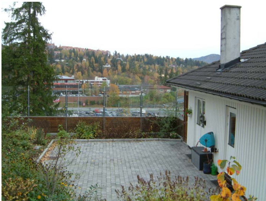
Figur A.1: E18, Asker, Torstaåsen. En smekker skjerm med store glassfelt festet til stålprofiler som underordner seg stedets karakter. Et eksempel med svært store skjermer i høyder over 2 meter. Størrelsen er delvis gitt av spesielle krav i reguleringsplanen for vegen. Støy redusert fra ca L_{ekv,døgn}=70 til ca 60 dB. Totalkostnad kr 7.156+mva pr m^2 (2005).
