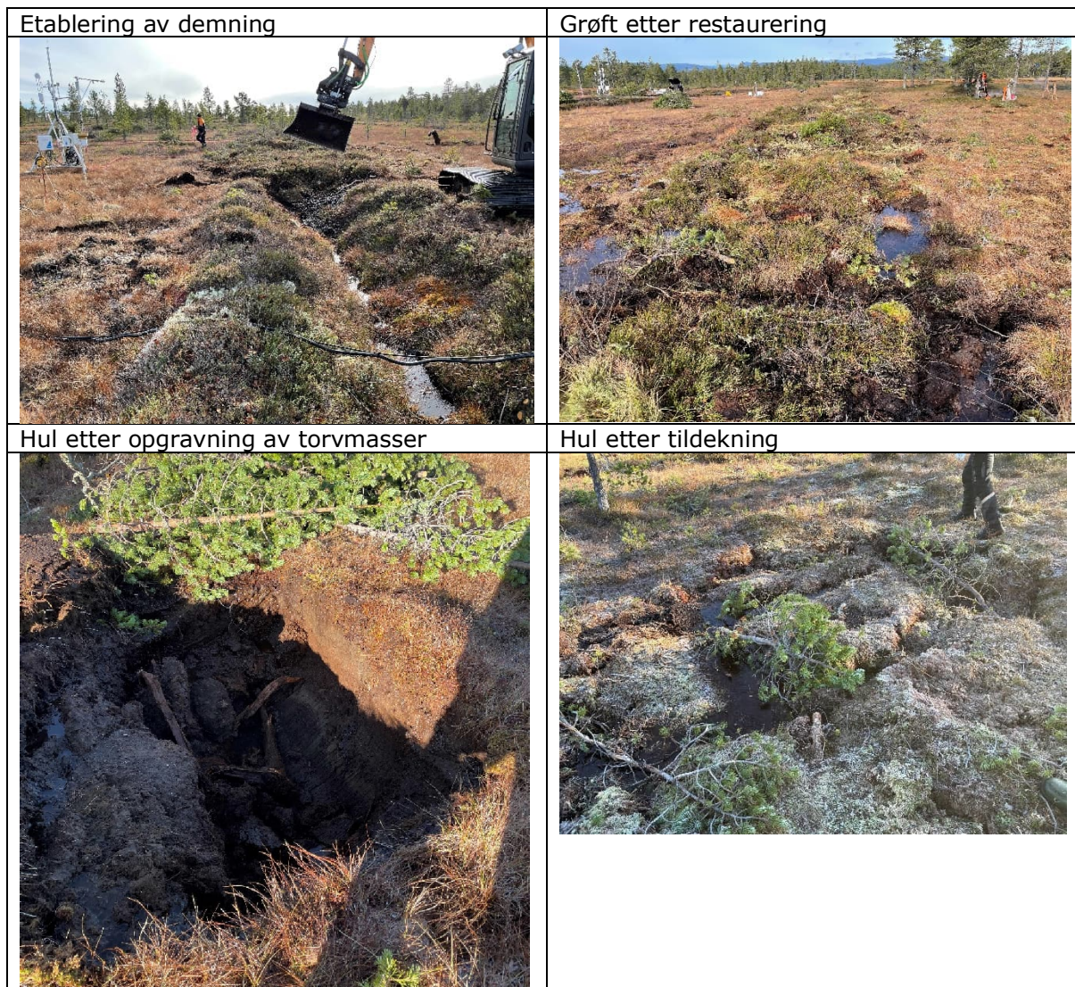
Figur 4.2. Utvalgte bilder fra restaurering.
