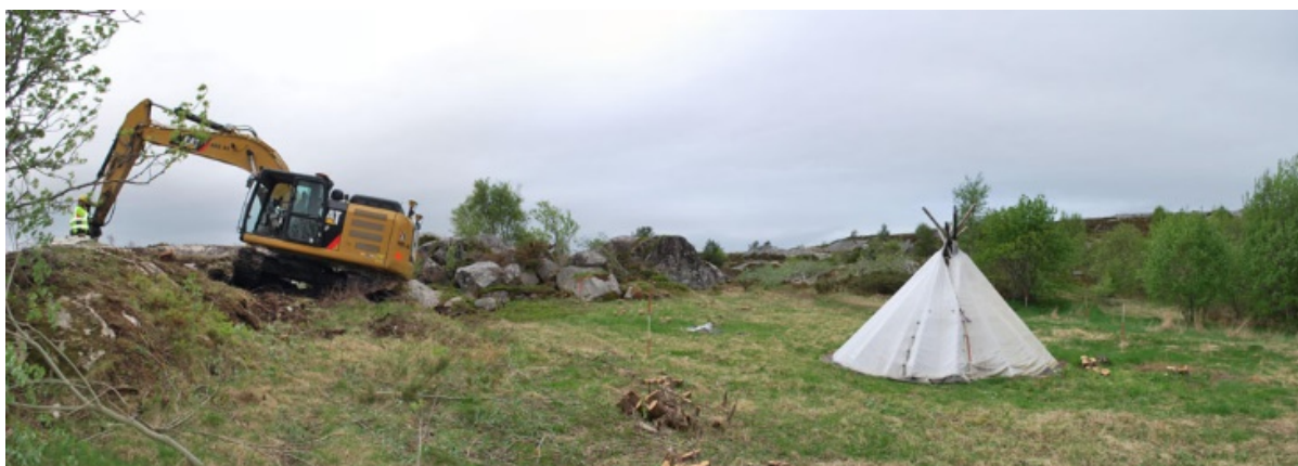
Figur 7: Panoramabilde av lokaliteten før avtorving. I bildet ses Atlantis barnehages lavvo som ble fjernet før den maskinelle avtorvingen begynte. Tatt mot V. Da_62720_068. Foto: Skule O.S. Spjelkavik, NTNU Vitenskapsmuseet.
