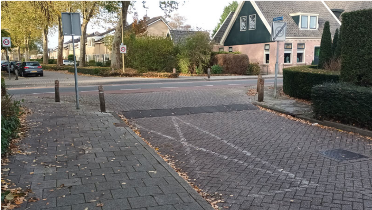
Figur 4.7: Et gjennomgående fortau med pullerter for å unngå kjøring på fortau.
