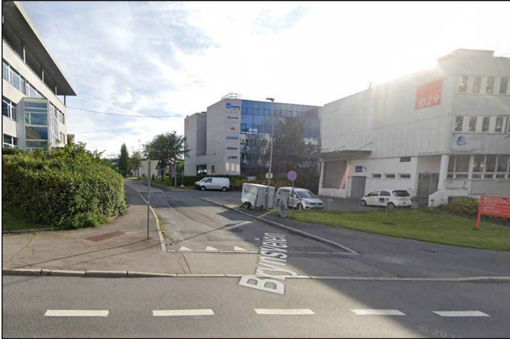
Figur 4.4: Gjennomgående fortau i Brynsveien med gjennomgående kantsteinslinjer.
