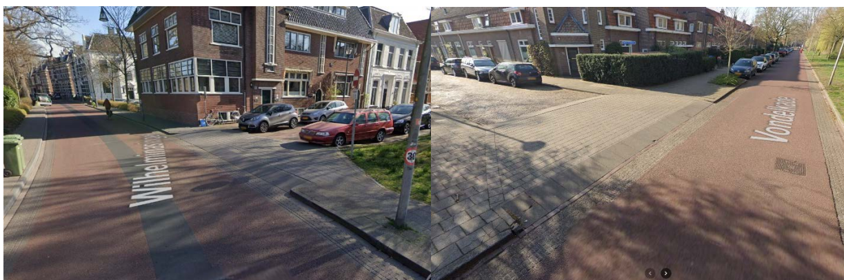
Figur 4.2: Gjennomgående fortau (Google Streetview).
