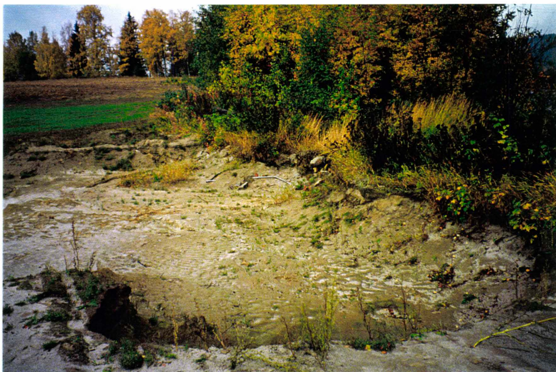
Fig. 6.4: Overtoppet flomverk. Erosjonen har startet i overgangen mellom vegetasjonssonen og pløyd mark. Selve elvekanten står imidlertid fint. Grue.
