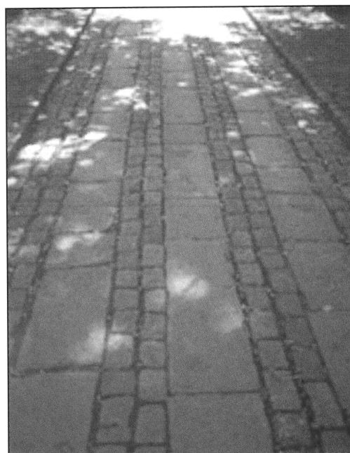
Fortausheller i granitt, Adkomst Børsen
