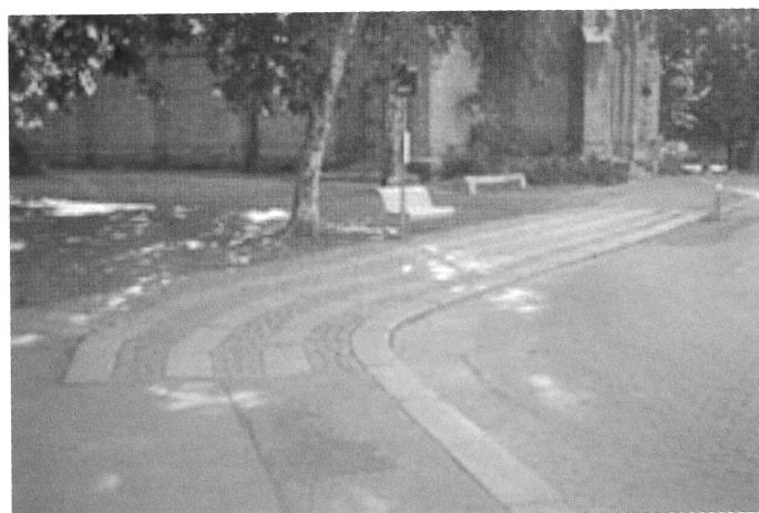
Fortausheller i granitt, Hausmannsgate
