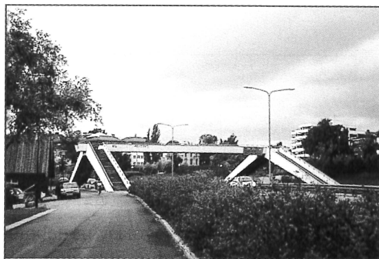
Figur 48: Bru ved Skarpsno
