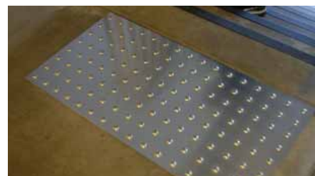
Farefelt foran trapp innendørs.
