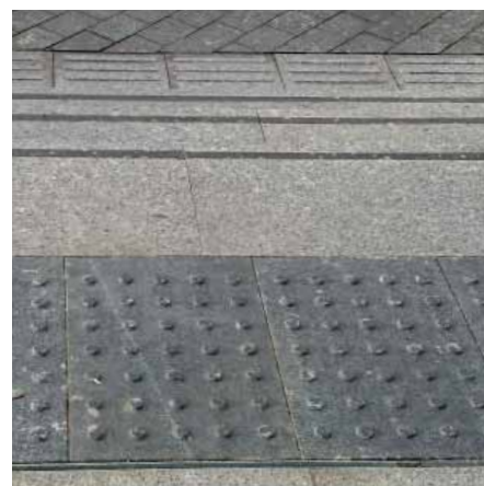
Farefelt foran trapp utendørs.
