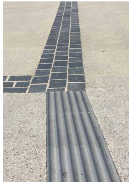
En naturlig ledelinje (tre rader gatestein øverst) er ført over i en kunstig ledelinje utendørs. Hvorfor har man skiftet system og ikke brukt naturlig ledelinje hele veien?
