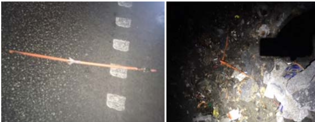
Figur 2.3 Funn av rør i Hovdetunnelen.
