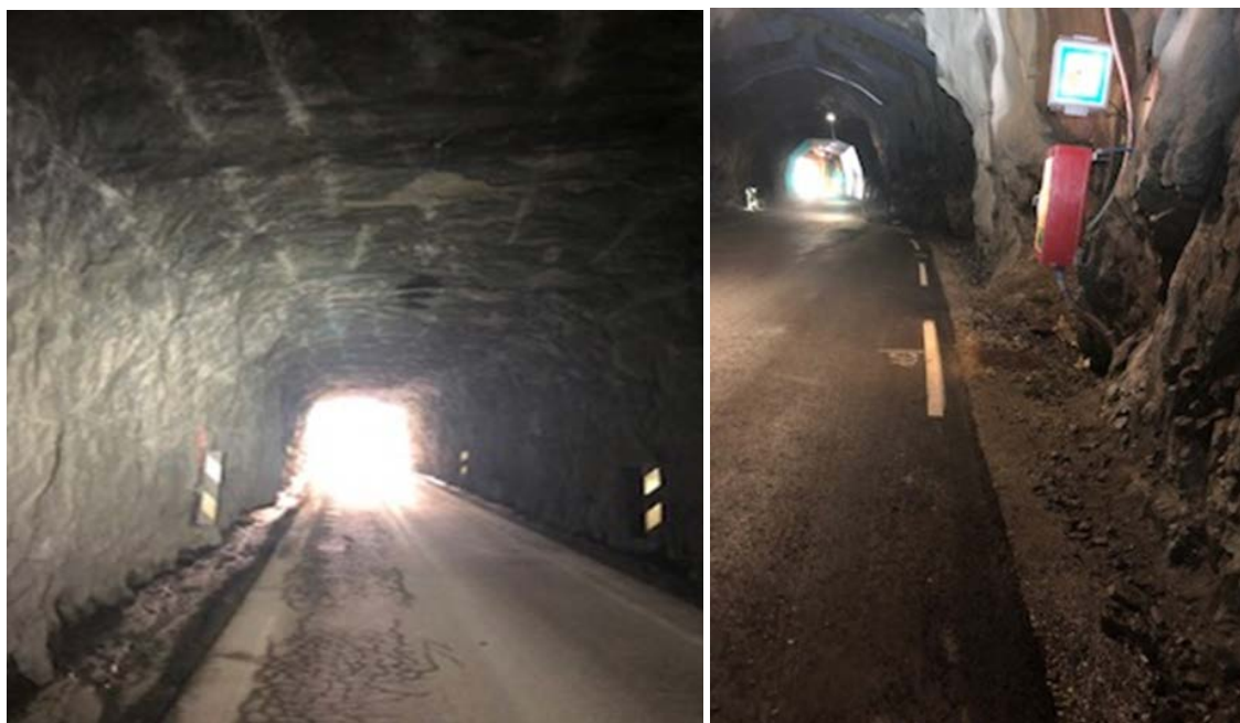
Figur 2.7 Eikelandstunnelen (venstre) og Bakkatunnelen (høyre).
