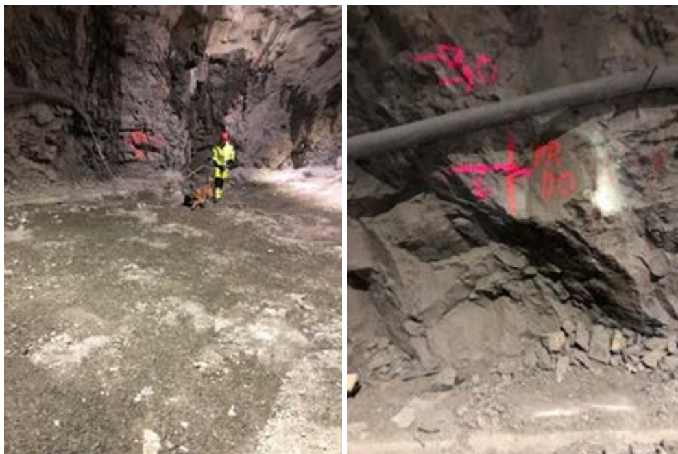
Figur 2.26 Kjørbotunnelen i Sandvika.
