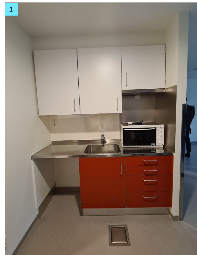
Bilde av samme kjøkken i en ubebodd (1) og bebodd leilighet (2). Det er ikke avsatt plass til vanlig komfyr på kjøkkenet, og plasseringen av hybelkomfyren på benkeplate er både uegnet til matlaging og en direkte brannfarlig løsning: Stikkontakt til hybelkomfyren er rett bak hybelkomfyren. En hybelkomfyr skaper mye ytre varme, og kan potensielt smelte stikkkontakten. Det å bruke en stekepanne over normal benkehøyde er også uegnet ergonomisk. Bilde 2 viser hvordan en beboer anvender samme kjøkken, og med en mikro på benkeplaten er det ikke benkeplass igjen til matlaging. Synlig sluk kan virke stigmatiserende.
