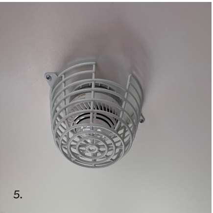
Detektor - montert i himling, med beskyttelsegitter Ikke anbefalt
