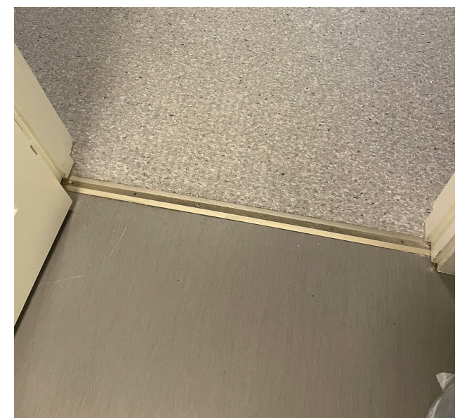
Eksempelbilde på terskelfritt gulv mellom to rom med slagdør.
