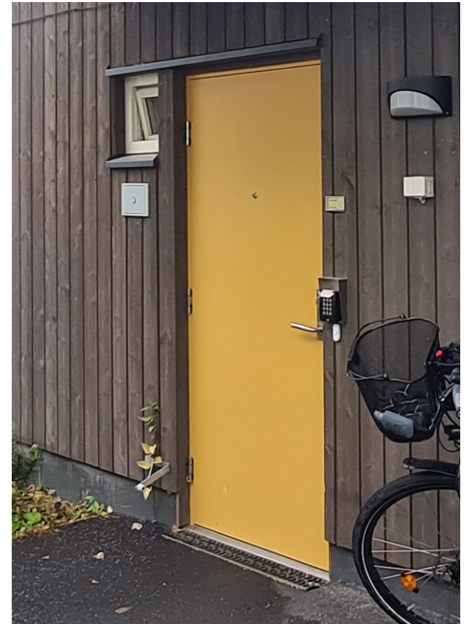
Eksempel på et lite vindu ved inngangsdør som fungerer som en lufteluke. Plassering og størrelse hindrer at noen kan ta seg inn vinduet og trygger sikkerhet for beboer.
