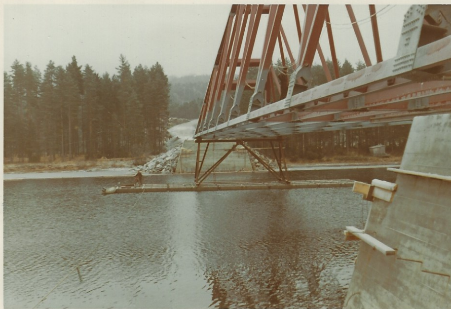
Hornesund Bru. (Fra byggeperioden.)
