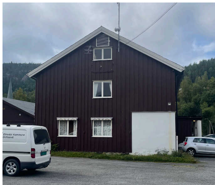
Bilde 10. Det gamle kommunehuset - østfasade
