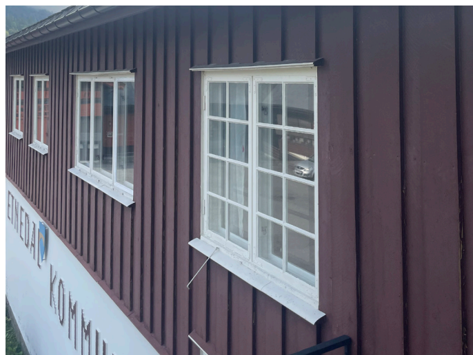
Bilde 12. Det gamle kommunehuset - vinduer og kledning
