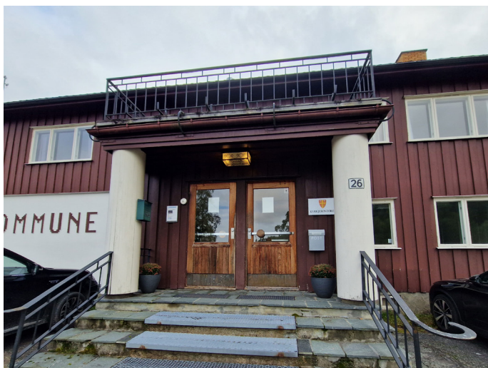
Bilde 11. Det gamle kommunehuset - inngangsparti
