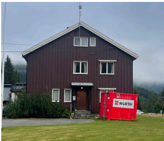
Bilde 9. Det gamle kommunehuset - vestfasade
