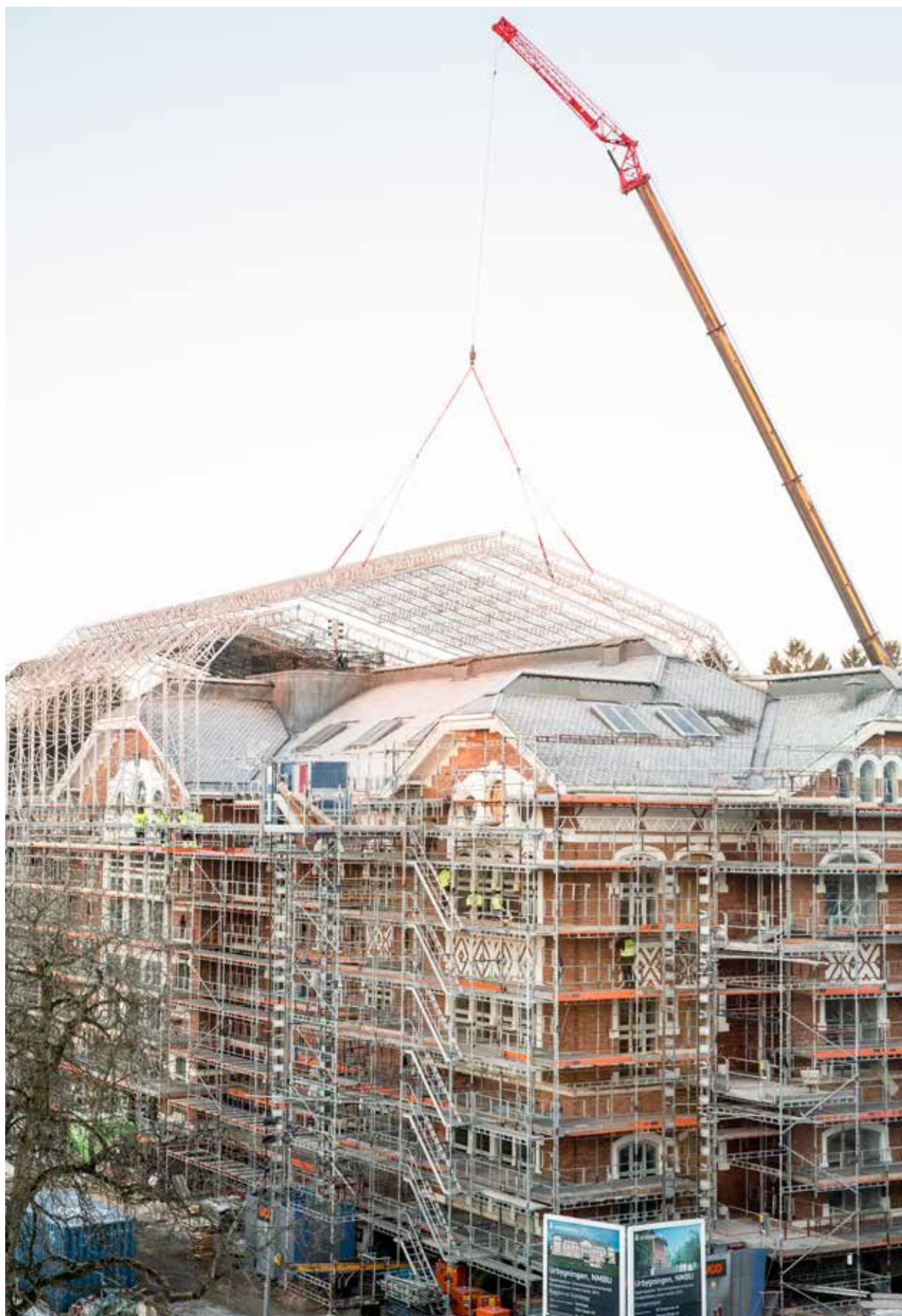
Montering av Norges største «Tak over tak». Rehabilitering av Urbygningen februar 2015. Foto: Gisle Bjørneby
