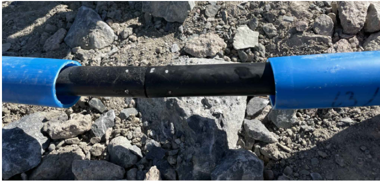
Figur 20: Spjelkeskjøting av medierør.
