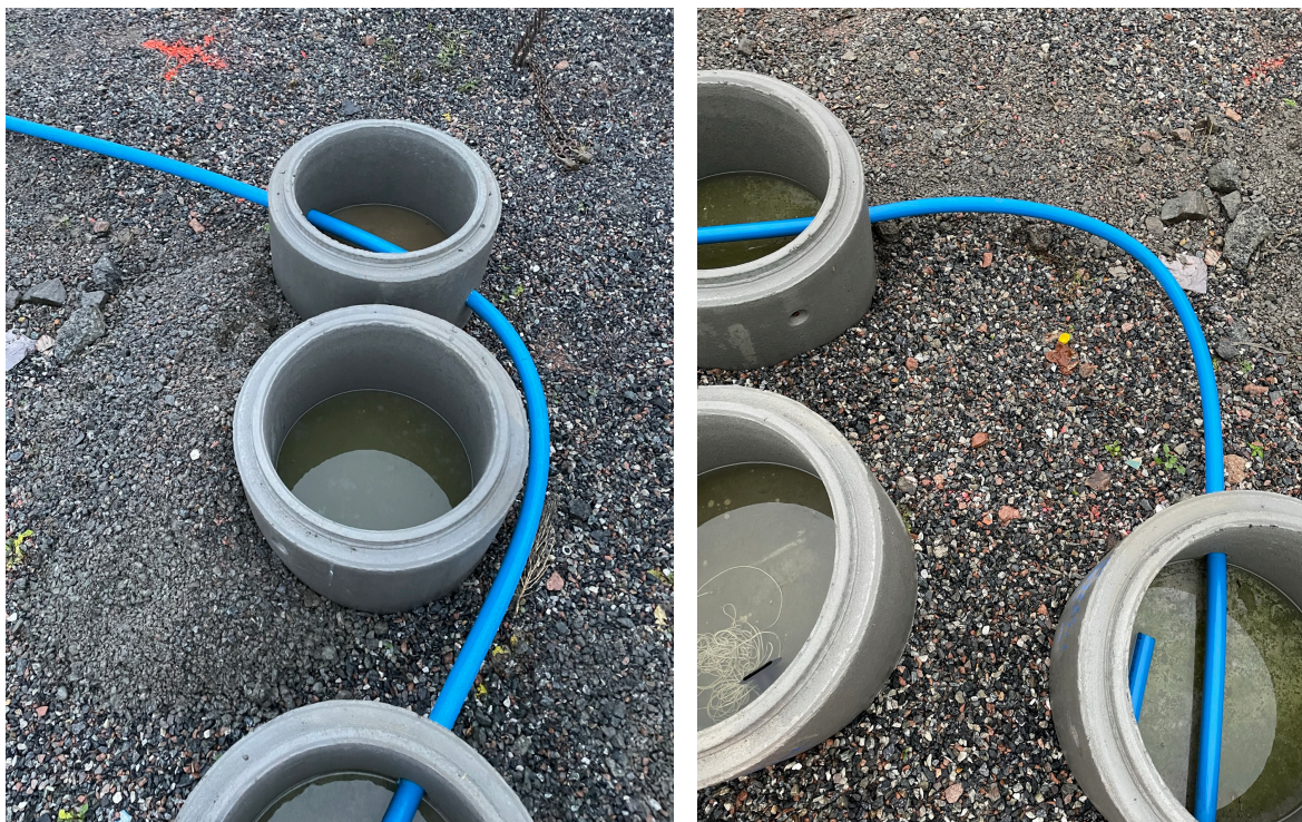
Figur 3: Bildene viser testing av henholdsvis riktig og for liten/krapp bøyeradius i 90 graders vinkel for kombinasjonen 40/63 mm rør. I bildet til venstre er bøyeradiusen ca. 2,4 m, til høyre er den redusert til ca. 1,0 m. (Foto: Drammen kommune)
