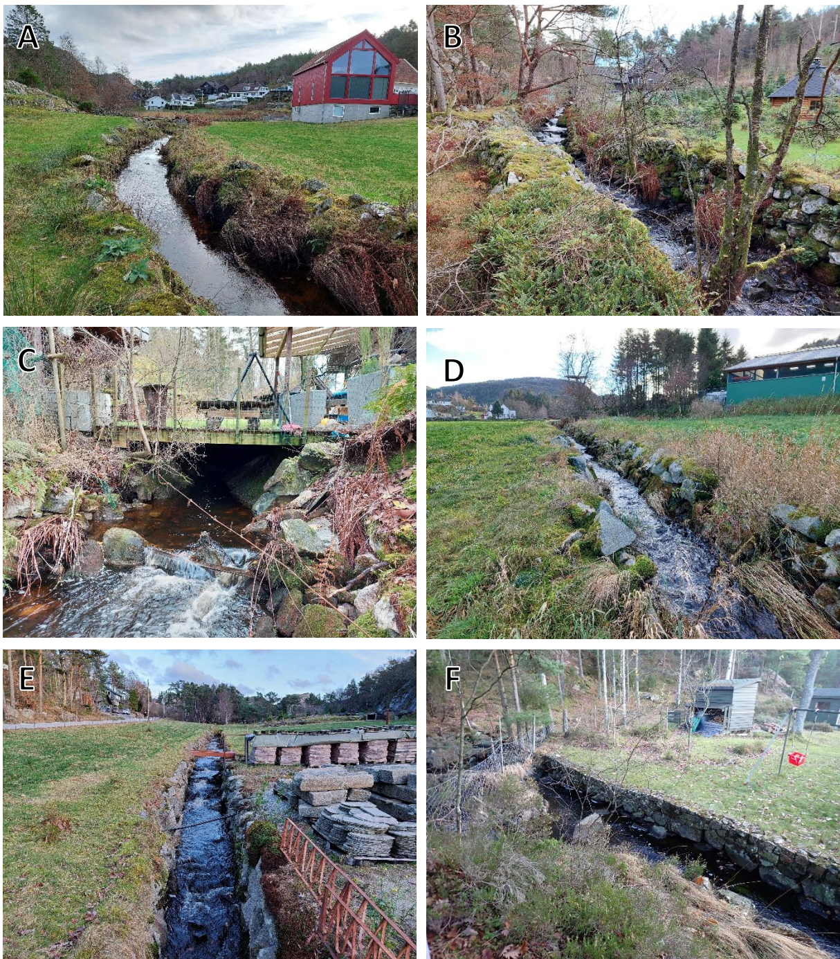
Figur 54. Morfologiske inngrep i Lauvåsvågbekken: A) Kanalisert elveløp med forbygninger og manglende kantvegetasjon i segment 4. B) Kanalisert elveløp med delvis intakt kantvegetasjon (segment 7) C) Betong langs bankene og terrasse over elven i segment 7. D) Utrettet kanalisert elvestrekning med forbygninger på begge sider og manglende kantvegetasjon i segment 12. E) kanalisert og utrettet strekning uten kantvegetasjon langs Bersagelveien i segment 25. F) Forbygning og manglende kantvegetasjon nederst i innløpsbekken til Søravatnet (segment 35).
