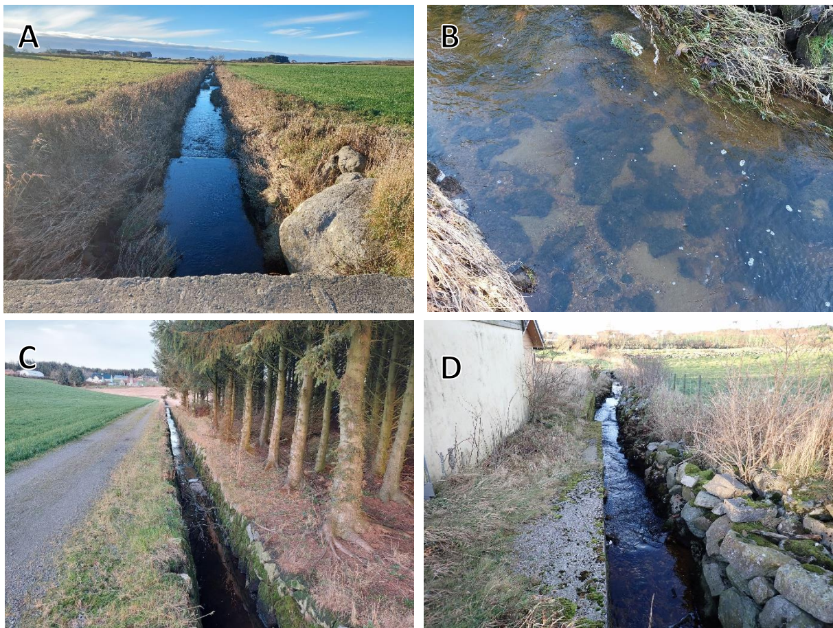
Figur 6. Morfologiske inngrep i Hørråna: A) Kanalisert elveløp og manglende naturlig kantvegetasjon B) Mye finstoff er akkumulert på bunnen C) Utrette og forbygd strekning med manglende kantvegetasjon D) kanalisert og utrettet strekning i sideløpet (segment 53).
