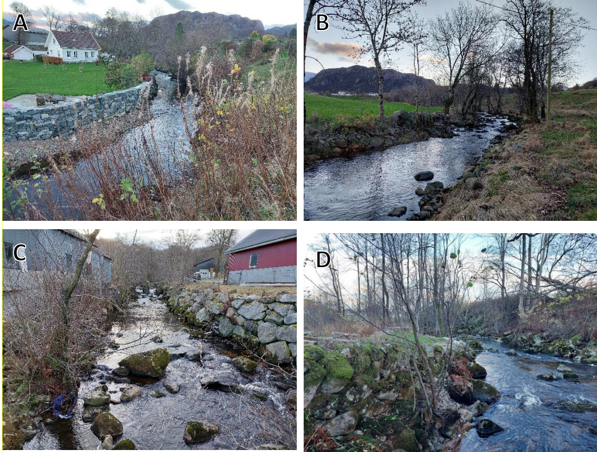
Figur 46. Morfologiske inngrep i Høleåna: A) Flomsikring og manglende kantvegetasjon i segment 1 og 2. B) Gamle tilbaketrunkne forbygninger og glissen og manglende kantvegetasjon i segment 2 og 3. C) Forbygninger og manglende kantvegetasjon i segment 10. D) Forbygning på vestsiden av elven i segment 4, som i liten grad påvirker habitatkvaliteten.
