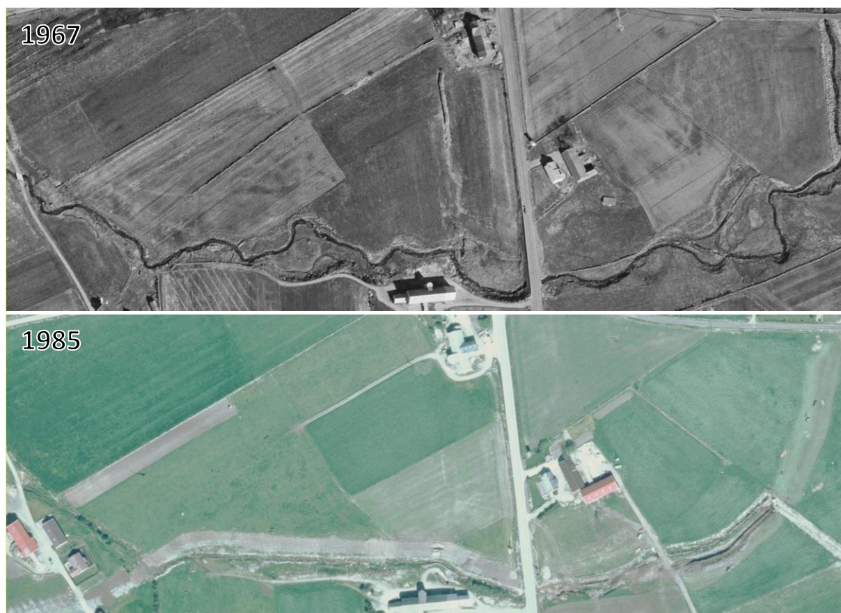
Figur 34. Utretting og kanalisering av elveløp oppstrøms og nedstrøms Nordsjøvegen ved Husvegg (segment 6-13), utrettingen i dette området skjedde i perioden 1967 til 1985 og 139 meter av elven er fjernet ved utretting og 172 meter er fjernet ved rørlegging av en opprinnelig strekning på 928 m.
