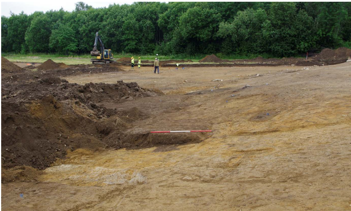
Figur 30. Bit av dyrkningslag 7786 i plan, bak målestokken, før det ble fjernet med gravemaskin. I forkant av laget kan man se hvor dypt registreringssjakt hadde gått akkurat her. Sett mot NV. Da57912_057. Foto: Marte Mokkelbost, NTNU Vitenskapsmuseet.
