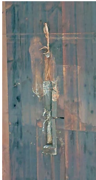
Figur 77 Undersiden av tredekket ved akse 1. Merket etter kreftene mellom styrefinne og tredekket, retning oppover (tilsvarer mot vest). Tredekket har beveget seg mot øst.
