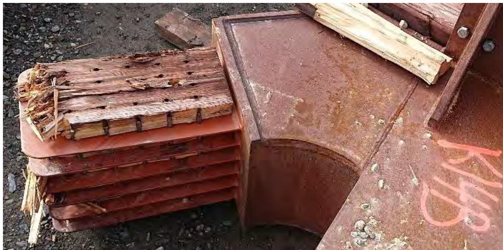
Figur 134 Knutepunkt OG14B, fra drone 8 timer etter kollaps
