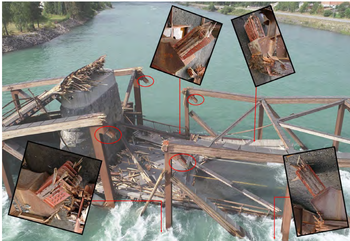
Figur 102 Bilde fra Statens havarikommisjon, informasjonsskriv 2: Blokkutrivning av diagonaler 6 og 7.
