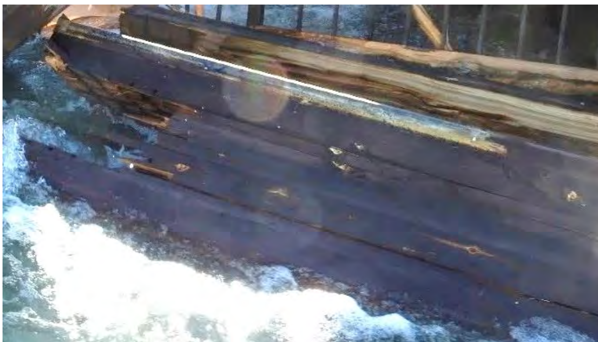
Figur 131 Diagonal 6A, innfesting trolig mot OG14A
