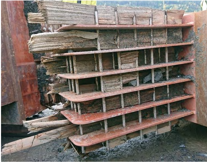
Figur 137 Knutepunkt UG15B, feste av diagonal 6B
