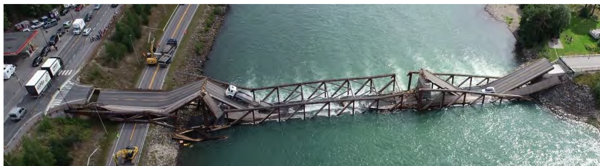
Figur 68 Dronebilde tatt fra oppstrøms side få timer etter brukollapsen.
