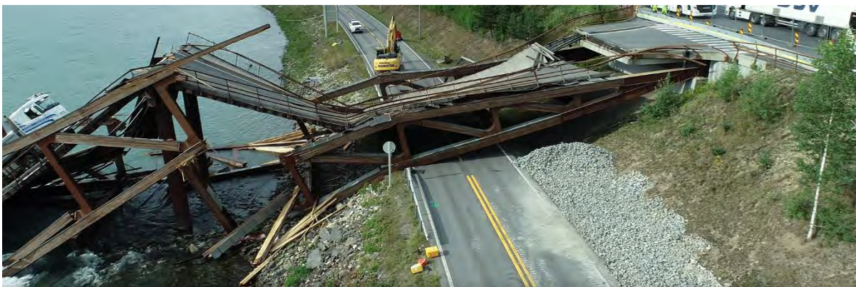
Figur 99 Brudel ved akse 3 og 4, sett fra nedstrøms side.
