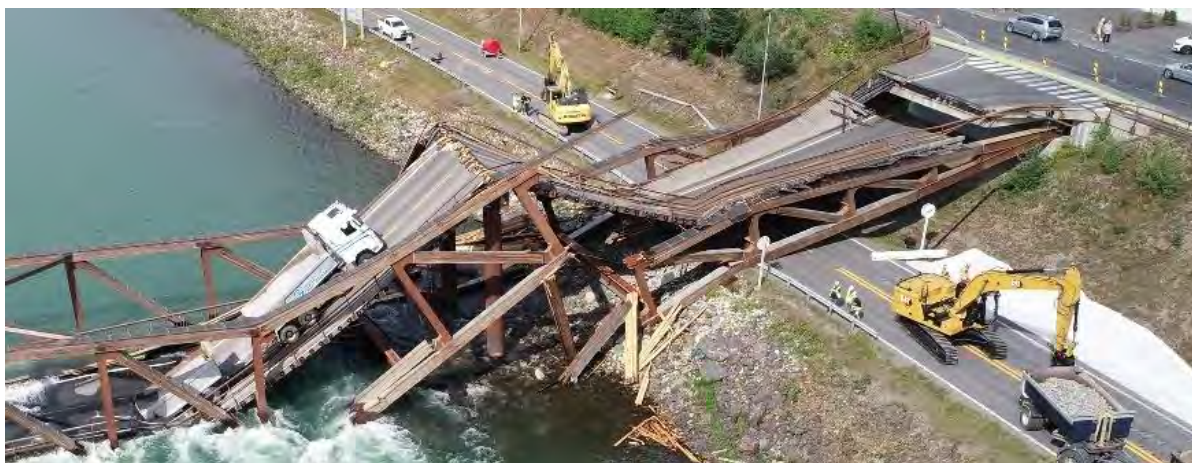
Figur 83 Akse 3 sett fra nedstrøms side
