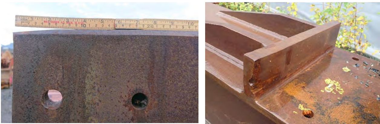
Figur 7 Til venstre: Tverrbærer i akse 3 (knutepunkt K-31 oppstrøms). Deformert sone der ståklakken på stålvertikal har "glidd av" tverrbærer. Utvidelse av boltehull pga. hullkantrokk. Til høyre: Deformert sone på ståklakken.
