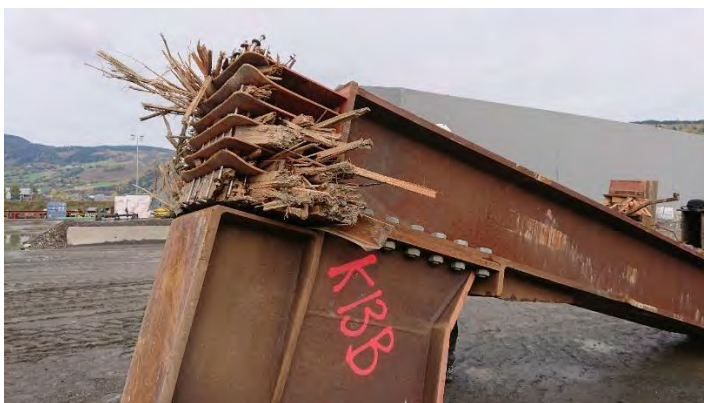
Figur 81 Tverrbærer festet til vertikal i akse 2, oppstrøms side (venstre) og nedstrøms side (høyre). Tverrbærer er kuttet.
