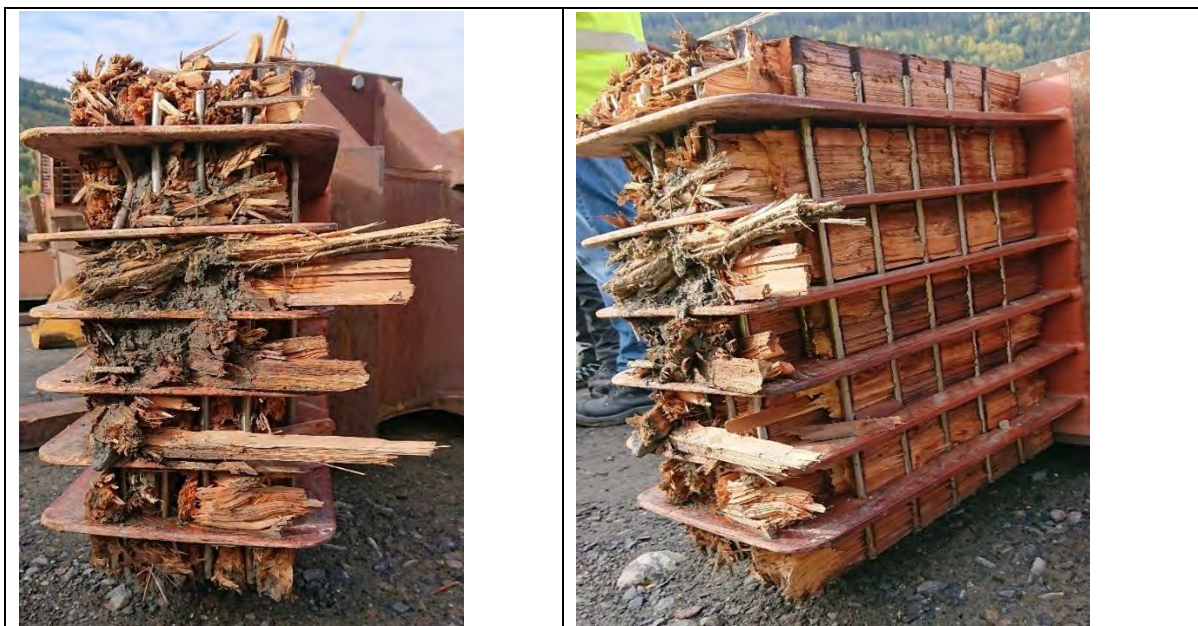
Figur 135 Knutepunkt OG14B, feste av diagonal 6B, etter berging
