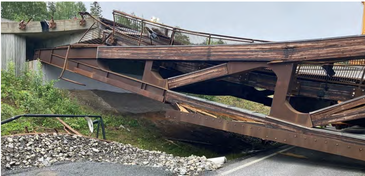
Figur 98 Opplager ved akse 4, oppstrøms side.
