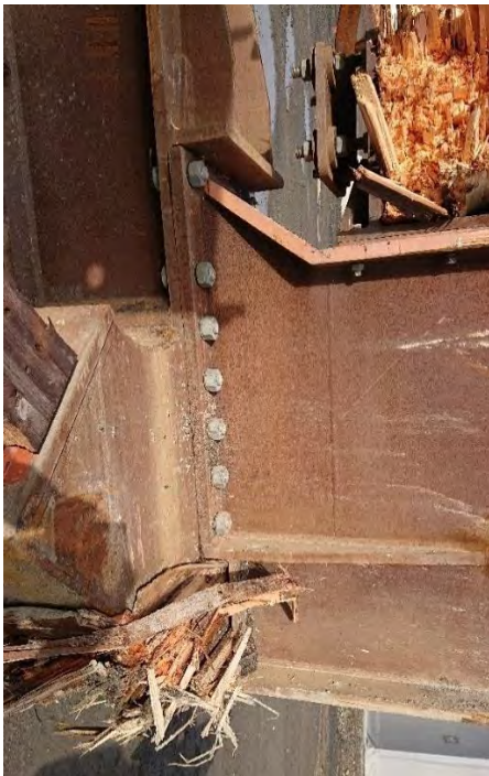
Figur 85 Prinsipp for feste mellom tverrbærere og stålvertikal (bildet er fra akse 2)
