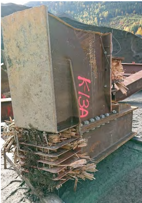
Figur 81 Tverrbærer festet til vertikal i akse 2, oppstrøms side (venstre) og nedstrøms side (høyre). Tverrbærer er kuttet.
