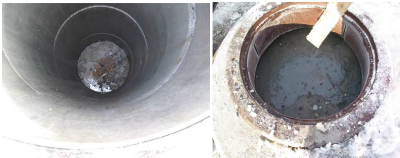
Figur 15.5.3.3—2 — Oppfylling av kumringer på Breivikeidet. Foto: Knut Hagberg, Statens vegvesen
