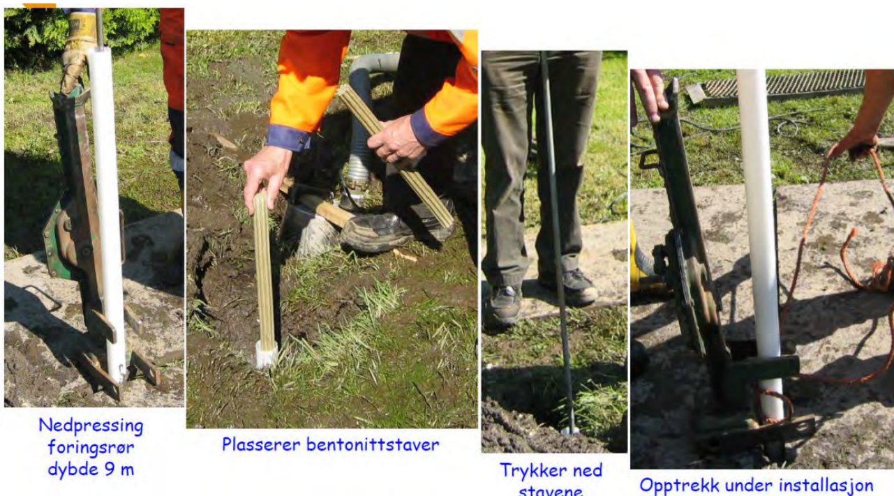
Figur 15.7.1—3 — Tetting av lekkasje ved bruk av bentonittstaver (Foto: Knut Hagberg, Statens vegvesen)
