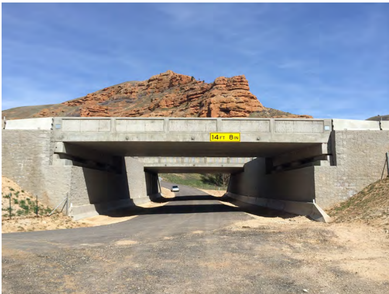
Figur 17.6.6—1 — Jordarmert landkar fra Interstate I15, Echo Bridge, Utah (Foto: J. Vaslestad, Statens vegvesen)
