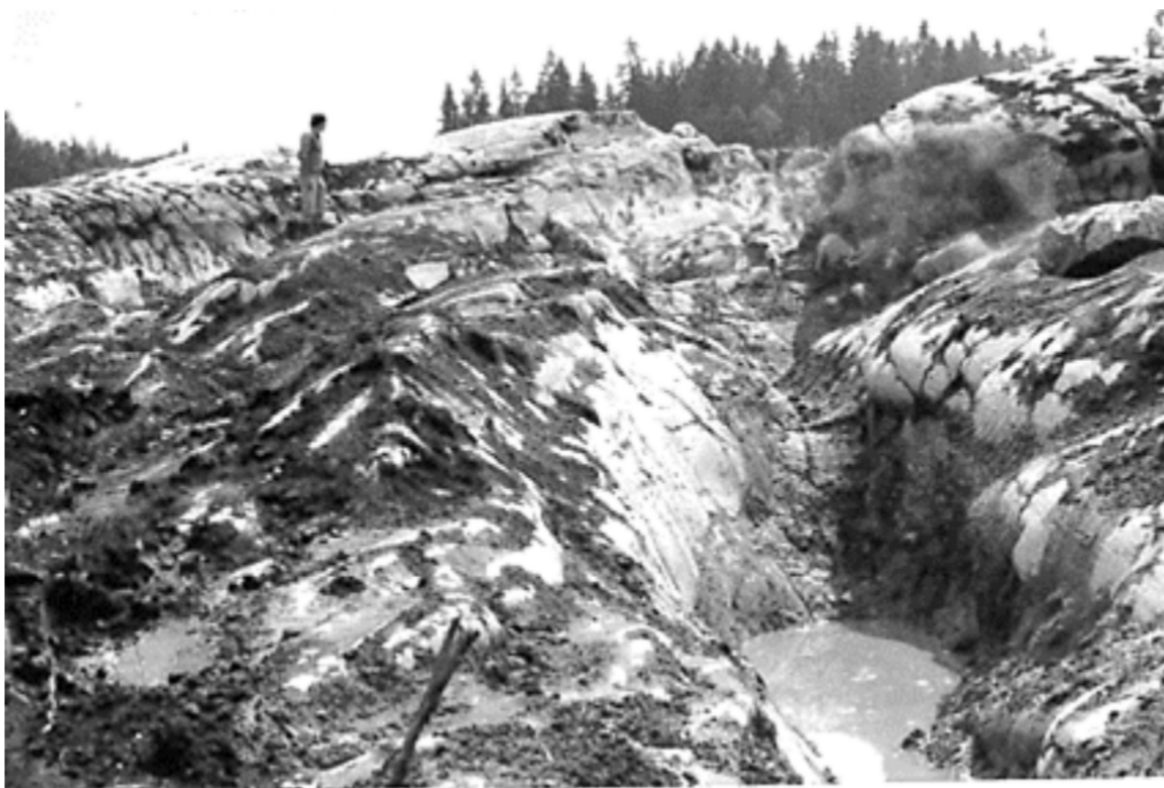
Figur 12.2—1 — Variasjon i bergoverflate Foto: Frode Oset, Statens vegvesen
