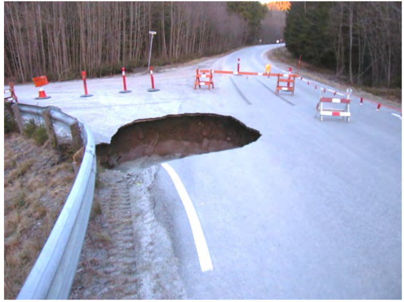
Figur 15.5.3—1 — Bilde til venstre viser en sprekk i terrenget ovenfor en punktering med utvasking på Breivikeidet. Bilde til høyre viser utvasket vegbane etter endret artesisk trykk på Valebø, i Telemark (Foto: Elisabeth Gundersen og Bjørn K. Dolva, Statens vegvesen)
