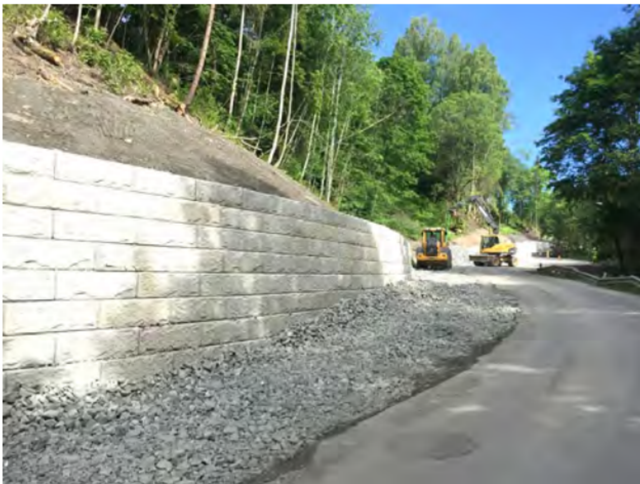
Figur 17.6.9—2 — Ferdig frontkledning med betongblokker ved Bårlidalen, Eidsvoll (Foto: J. Vaslestad, Statens vegvesen)
