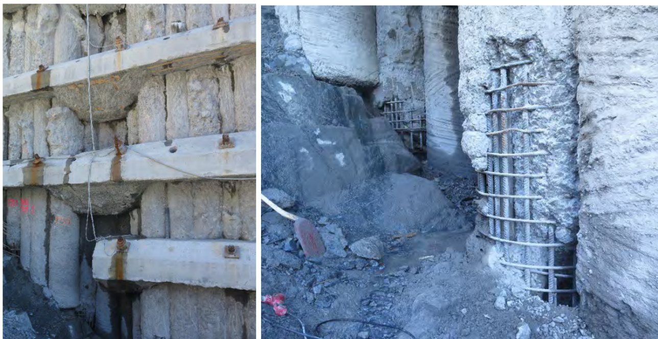
Figur 11.1.5—2 — Eksempler på ulike utfordringer med sekantpeler. (Foto: Arne Kavli, Statens vegvesen)
