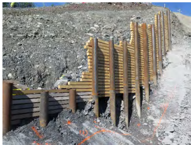
Figur 11.1.4—1 — Bjelkestengsel (Berlinervegg). Venstre foto: Fundamentering AS. Høyre foto: Arne Kavli, Statens vegvesen (E16 Sandvika-Wøyen)
