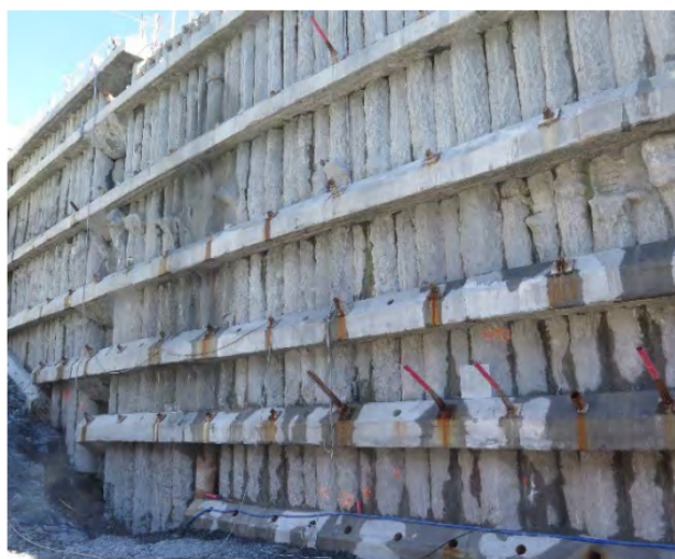
Figur 11.1.5—1 — Typisk utforming av sekantpelevegg med primærpel (myk) og sekundærpel (hard), E16 Sandvika-Wøyen Foto: Arne Kavli, Statens vegvesen
