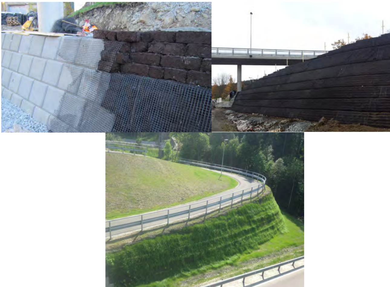
Figur 17.6.11—2 — Bilder fra prosjektet E18 gang \- og sykkelveg ved Nygårdskrysset (Kilde: Statens Vegvesen, 2016)
