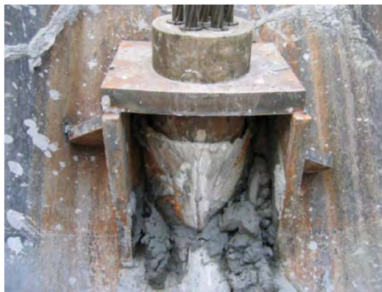
Figur 11.6.2—1 — Fuglekasse satt i spuntbuk for lisseanker, alternativ der det ikke er plass til puter. Foto: Grete Tvedt
