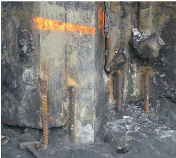
Figur 11.6.5.2—2 — Eksempel på bruk av skråbolter (foringsrør for fotbolter ødelagte) og fotdrager (Foto venstre: Veslemøy Gardå, Statens vegvesen Foto høyre: Frode Oset, Statens vegvesen)
