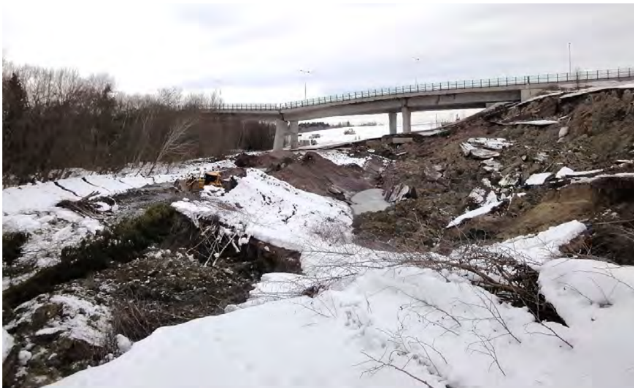
Figur 2.6.5—1 — Bilde av kvikkleireskred E18 Skjeggestad Foto: Frode Oset, Statens vegvesen
