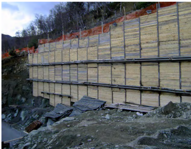
Figur 11.1.4—1 — Bjelkestengsel (Berlinervegg). Venstre foto: Fundamentering AS. Høyre foto: Arne Kavli, Statens vegvesen (E16 Sandvika-Wøyen)
