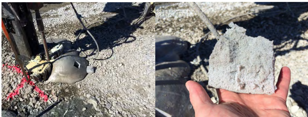
Figur 15.7.2—2 — Injisering med polyuretan
