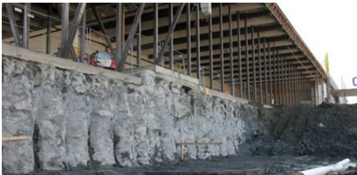
Figur 11.1.6—2 — Eksempel på bruk av jetpeler til etablering av støttevegg og fundament. Foto: Jetgrunn
