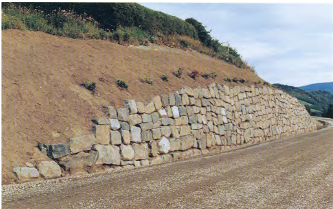
Figur 17.6.9—1 — Ferdig frontkledning med naturstein, Vingrom kirke (Foto: J. Vaslestad, Statens vegvesen)
