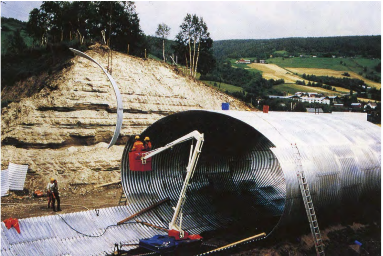
Figur 13.3.4.2—1 — Formonterte plater heises på plass (Foto: Statens vegvesen)
