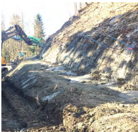
Figur 17.7.3.7—2 — Montering av jordnagler ved Bårlidalen, Eidsvoll (Foto: J. Vaslestad, 2017)
