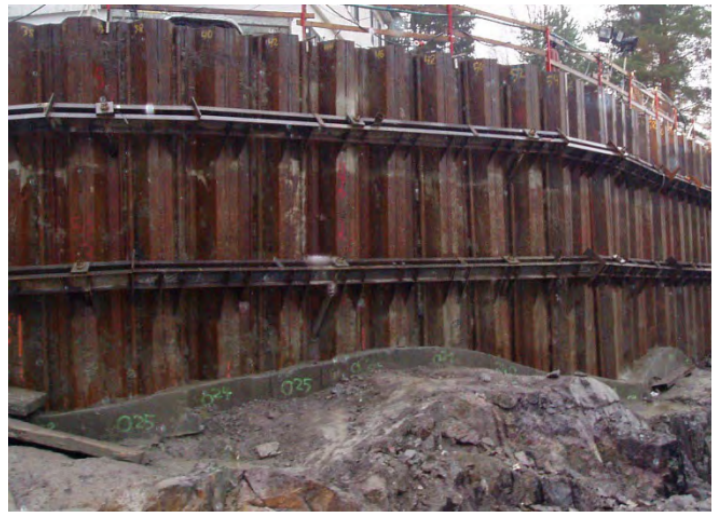
Figur 11.6.5.2—2 — Eksempel på bruk av skråbolter (foringsrør for fotbolter ødelagte) og fotdrager (Foto venstre: Veslemøy Gardå, Statens vegvesen Foto høyre: Frode Oset, Statens vegvesen)
