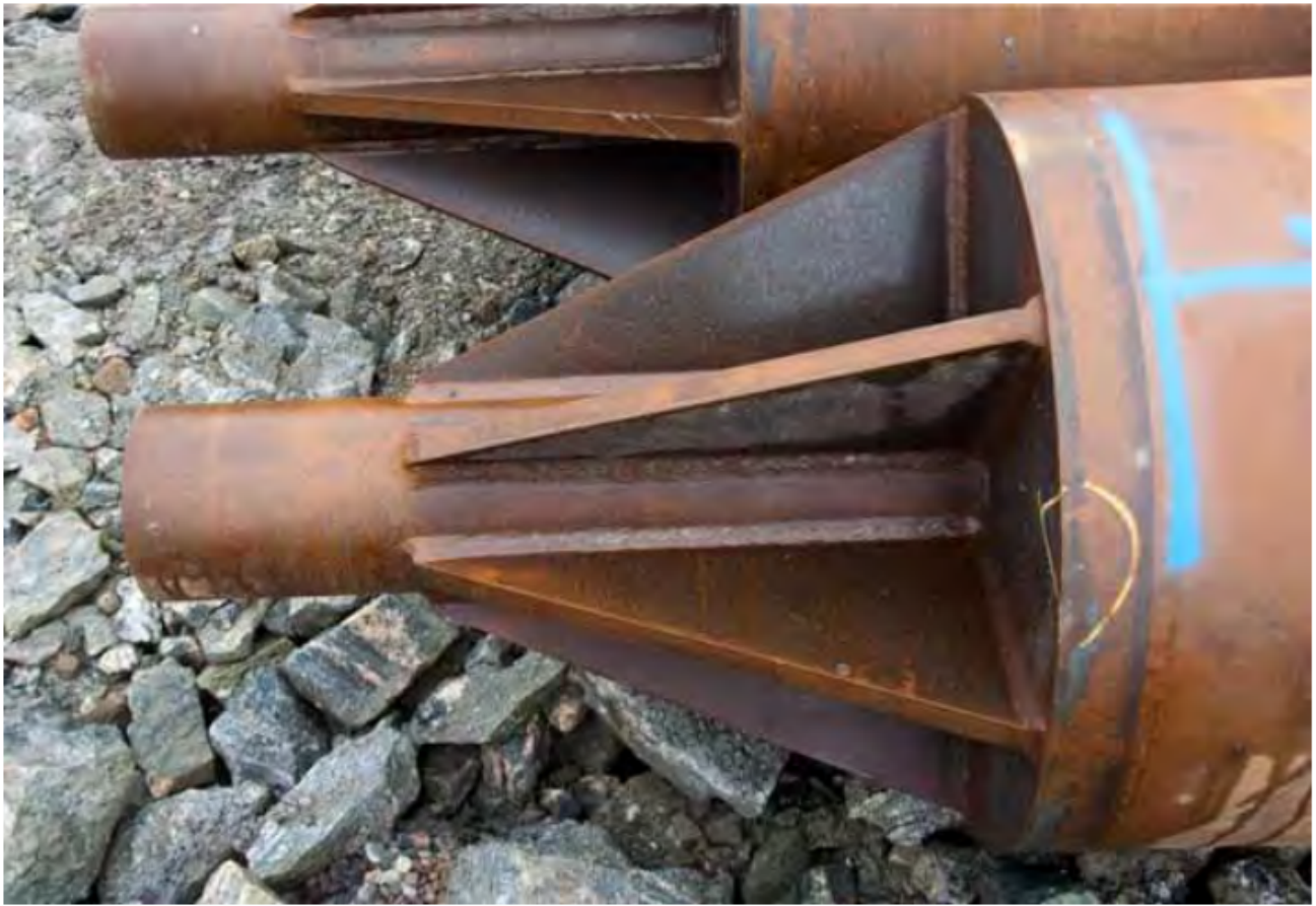
Figur 12.4.1.4—1 — Bilde av pelespiss som viser dubb, avstivingsribber og endeplate (Statens vegvesen VD rapport nr. 34 [237] )
