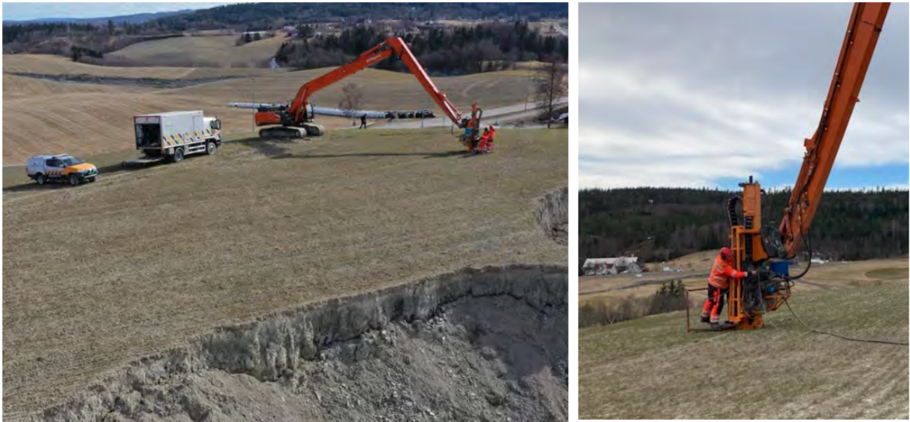
Figur 2.5—1 — SVVs løse bortårn montert på gravemaskinen «Langemann» Foto: NVE
