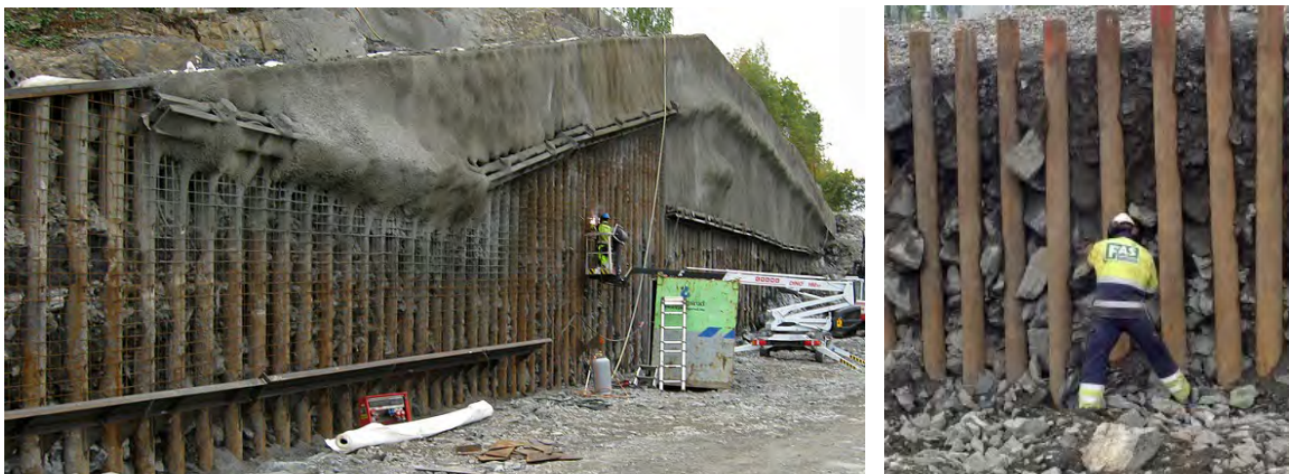
Figur 11.1.3—1 — Rørvegg - adskilte nedborede stålrør. Venstre foto: Avløs stasjon, Geovita AS. Høyre foto: Fundamentering AS
