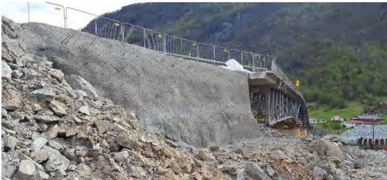
Figur 11.1.8—1 — Skjæring inn i eksisterende trafikkert tilløpsfylling og landkar, Rv. 5 Loftesnes bru. (Foto: Arne Kavli, Statens vegvesen)
