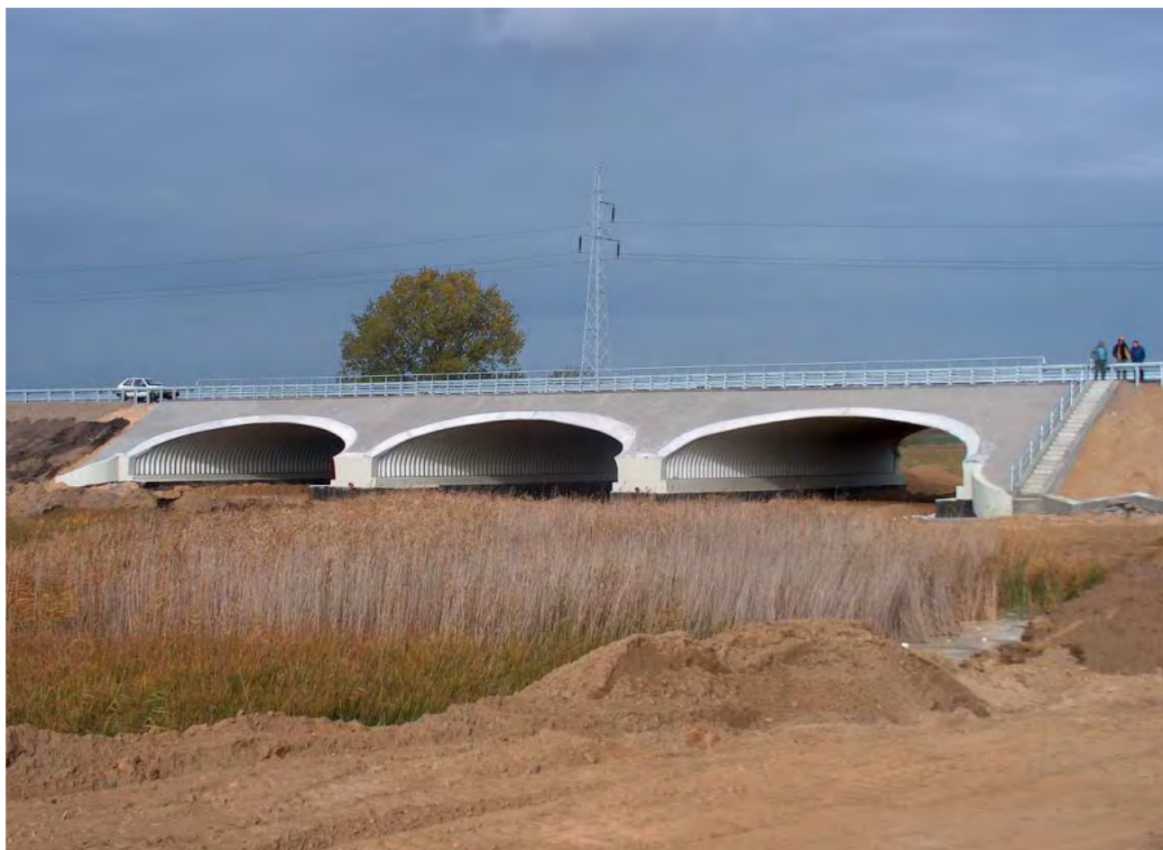
Figur 13.3.1—2 — Konstruksjon med korrugeringsprofil 380 x 140 mm i stål med platetykkelse 7 mm, overdekning 1,2 m, byggeår 2005 (Polen). Foto: Jan Vaslestad, Statens vegvesen
