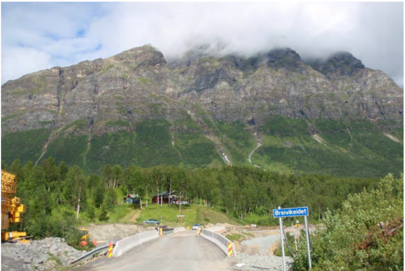
Figur 15.5.3.3—3 — Breivikeidet Foto: Frode Oset, Statens vegvesen
