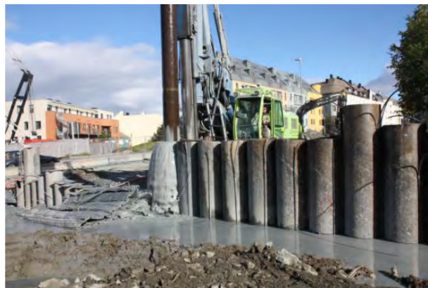
Figur 11.1.2—1 — Rørsput med låser. Figur: SSAB / Foto: Ellinor Hansen, Statens vegvesen
