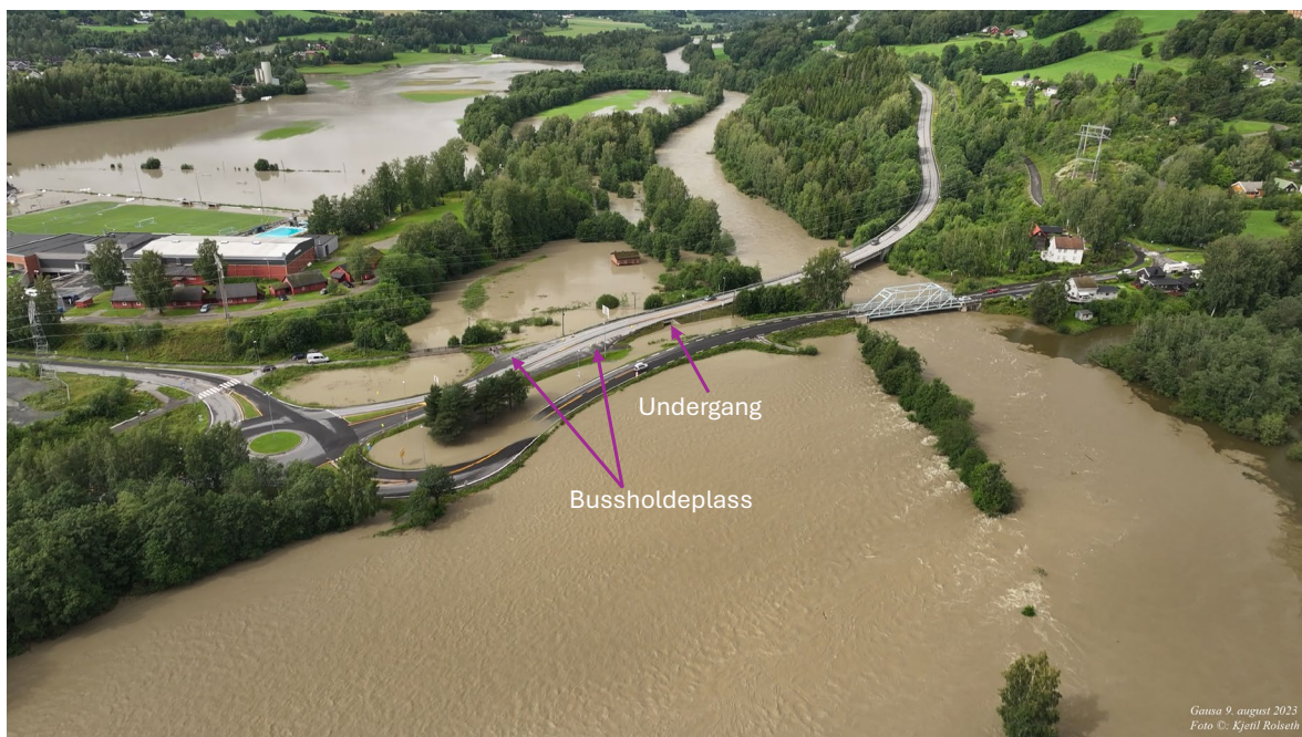
Figur 19. De nedre delene av Gausa under en ekstrem flomsituasjon («Hans») i august 2023. I slike situasjoner er det utfordrende med trafikkavviklingen og sikkerheten til gående og syklende. Bussholdeplass og undergang er markert i bildet.
