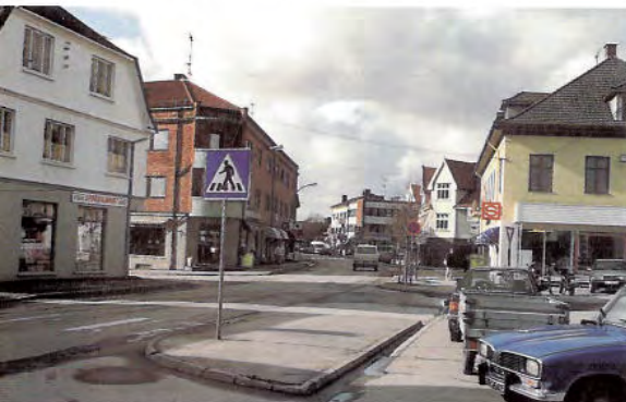
Ombygging til miljøgate gir de ulike brukerne av trafikkkarealet bedre vilkår. Storgata i Rakkestad før og etter ombygging. Foto: Lillebill Marshall (før) og Jim Bengston (etter)
