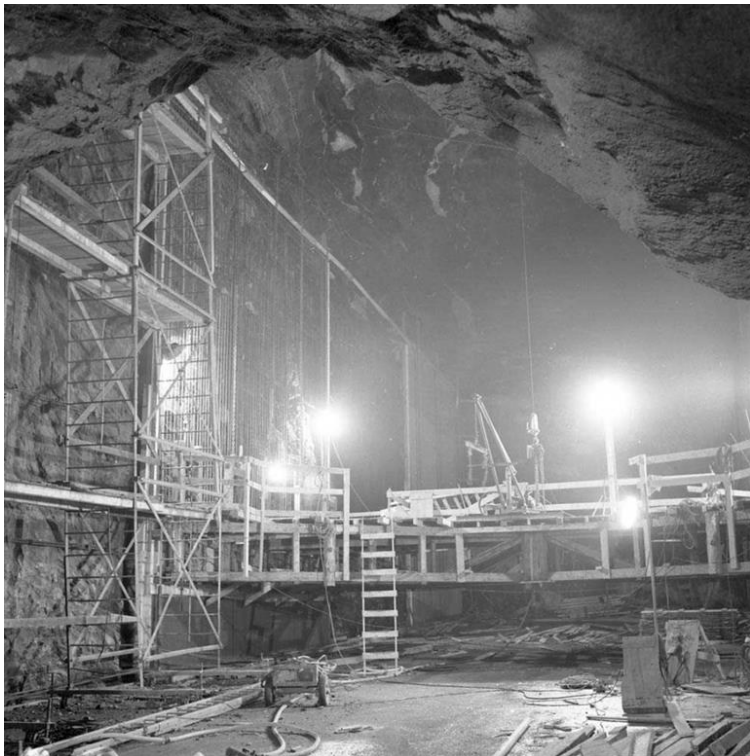
Foto 9: Fra byggingen av Anlegg 96. Ukjent fotograf.
