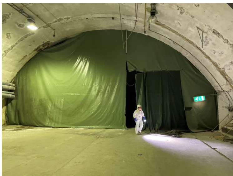
Foto 16: Per Erik Solli. Bilde av inngangen til nordre hall i Anlegg 96. Den skadede duken ble reparert av Forsvarsbygg. Tetting av inngangen gjør at avfuktingsmaskinene fungerer bedre.
