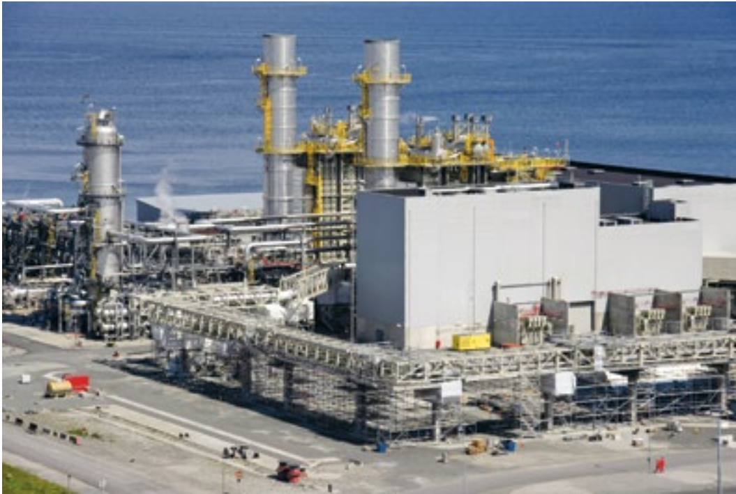
Det bød på utfordringer da teknologisenteret skulle kobles til kraftvarmeverket på Mongstad. Foto: TCM DA
