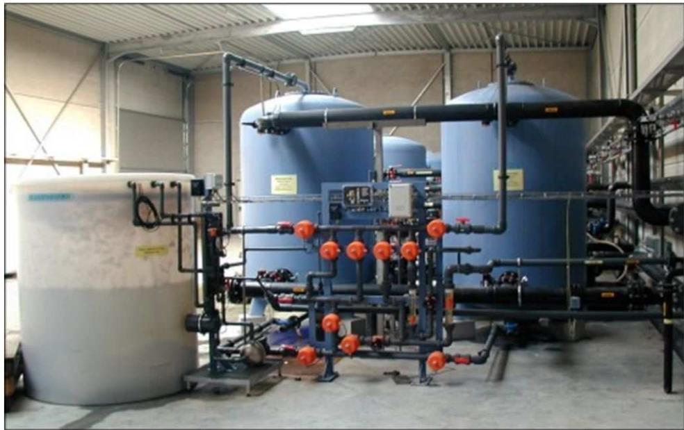
Figur 61. Stort ionebyttesanlegg av fabrikat Silhorko installert på belgisk matfabrikk
