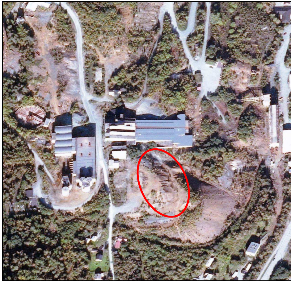
Figur 17: Veltene på Løkken-siden. Ringen omslutter markerte erosjonsskader på tippen.
