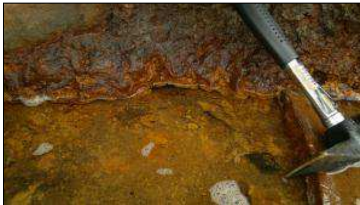
Horisontalt sprekk langs bekkekanten.
