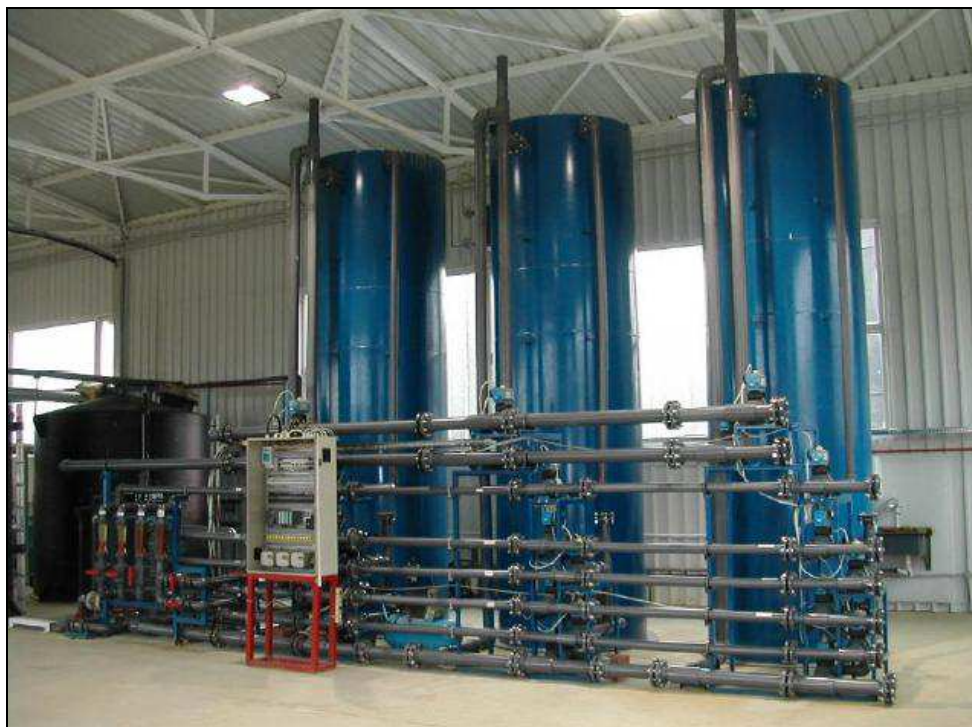
Figur 53: Tre parallelle ionebyttekolonner og en kjemikalietank til svovelsyre på anlegget i Serbia.
