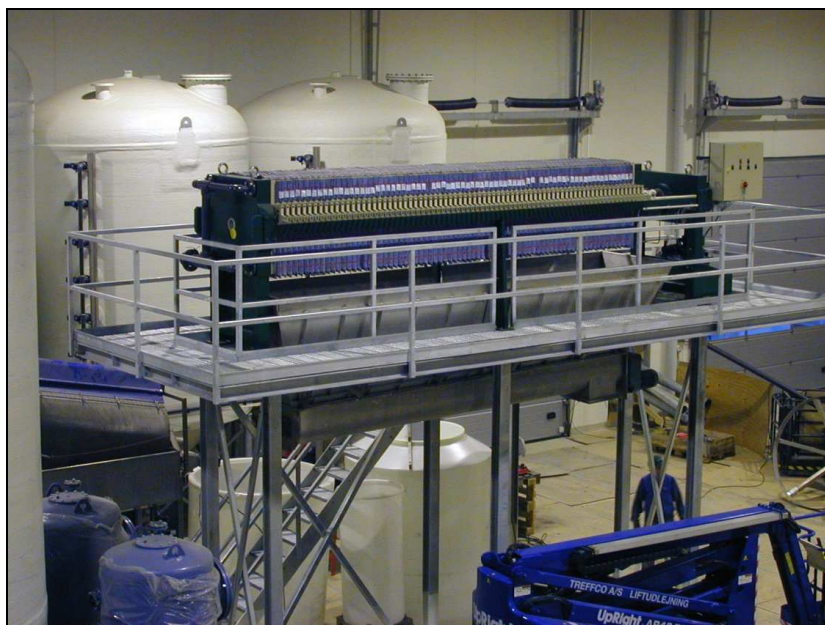
Figur 60. Kammerfilterpresse under installasjon på et dansk garveri. 75 plater, 800 x 800 mm og 1000 liter kammervolum. Pressen er hevet over gulvnivå, så filterkaker kan falle direkte ned i en container under pressen.
