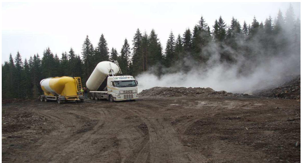
Figur 14 Utlegging av olivin 11 fra tankbil på deponi for tungmetallholdige steinmasser. (Regionfelt Østlandet).
