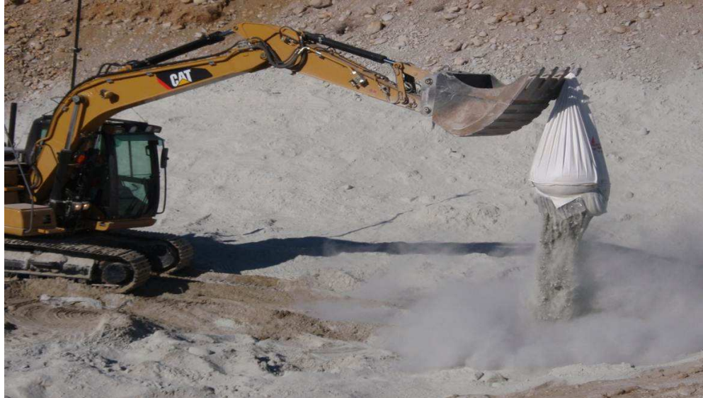
Figur 13: Utlegging av olivin 11 fra punktert storekk. (Fra Hjerkinnskytefelt). Utblåsning fra tankbil
