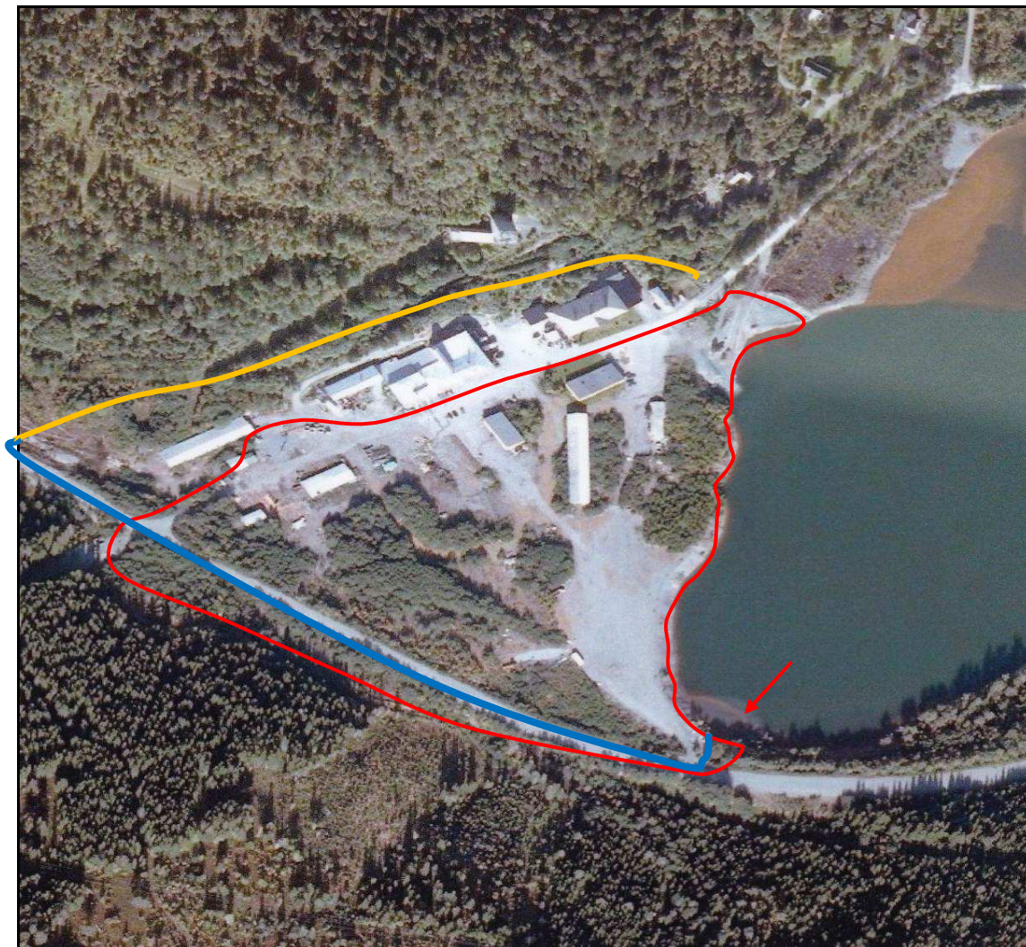
Figur 20: Område B innenfor den røde linjen er i hovedsak fylt opp med gråberg, men også annet gruveavfall er deponert i området. Innholdet av kobber og sink i massene kan utgjøre over 1000 tonn. Den gule linjen er den foreslåtte avskjærende grøften for rent vann, mens den blå linjen er et bekkesig. Vannet er forurenset ved utløpet av bekkesiget.
