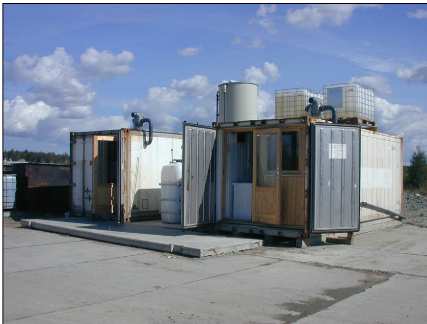
Figur 75. Pilot plant containeranlegg til perkolatrensing i Russland (COWI, 2005)
