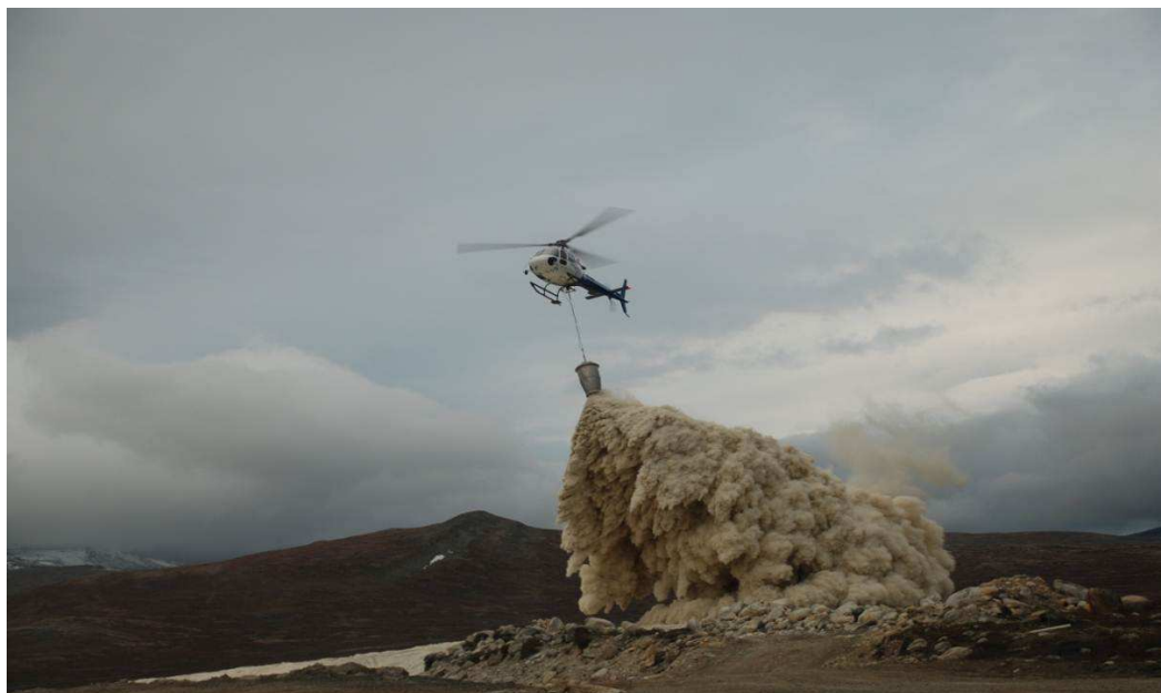
Figur 15: Utlegging av bentonitt med helikopter på deponi for tungmetallholdig avfall i Hjerkinnskytefelt.
