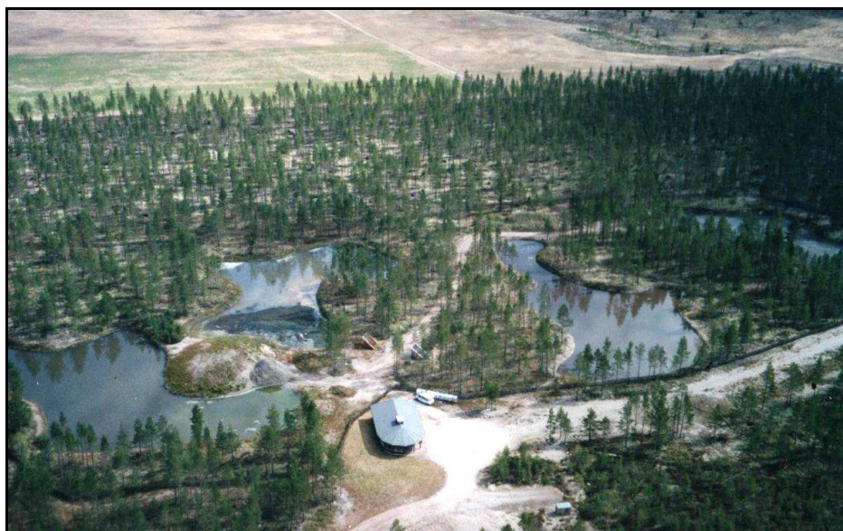
Figur 27: Eksempel på terrengtilpasset, parkmessig behandlet damanlegg for rensing av avløpsvann. Bildet er fra Rena Rensepark i Hedmark.
