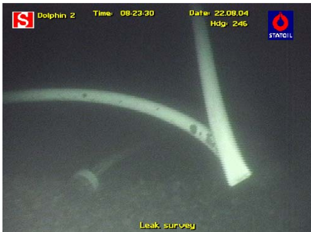
Figur 4 Foto på havbunnen etter bruddet på 6" rørledning.
