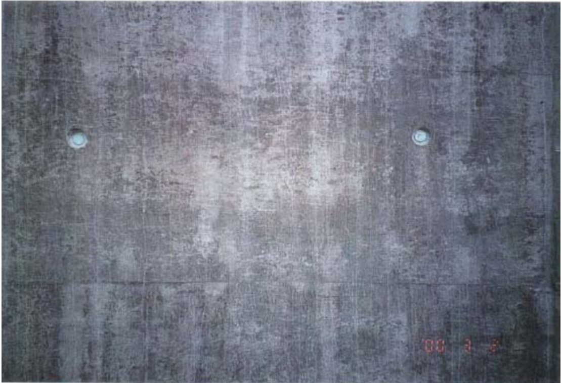
Fig. 15 Bakside mot finerlemmer. Også her så godt som fritt for porer
