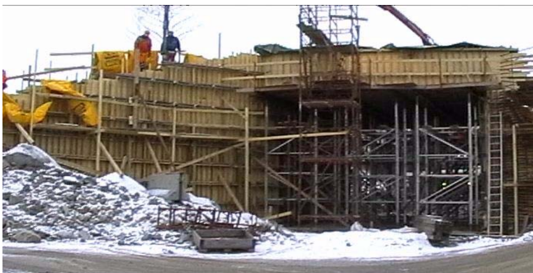
Fig. 2 Foto av Søndre Bjørnstad bru under byggingen
