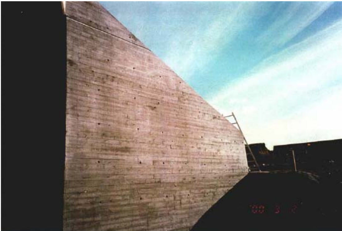
Fig. 14 Søndre vingemur. Framside forskalt med 4" bord
