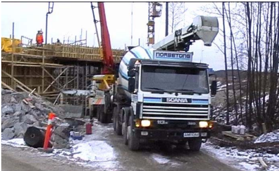
Fig. 6 Tilrigging for utstøping
