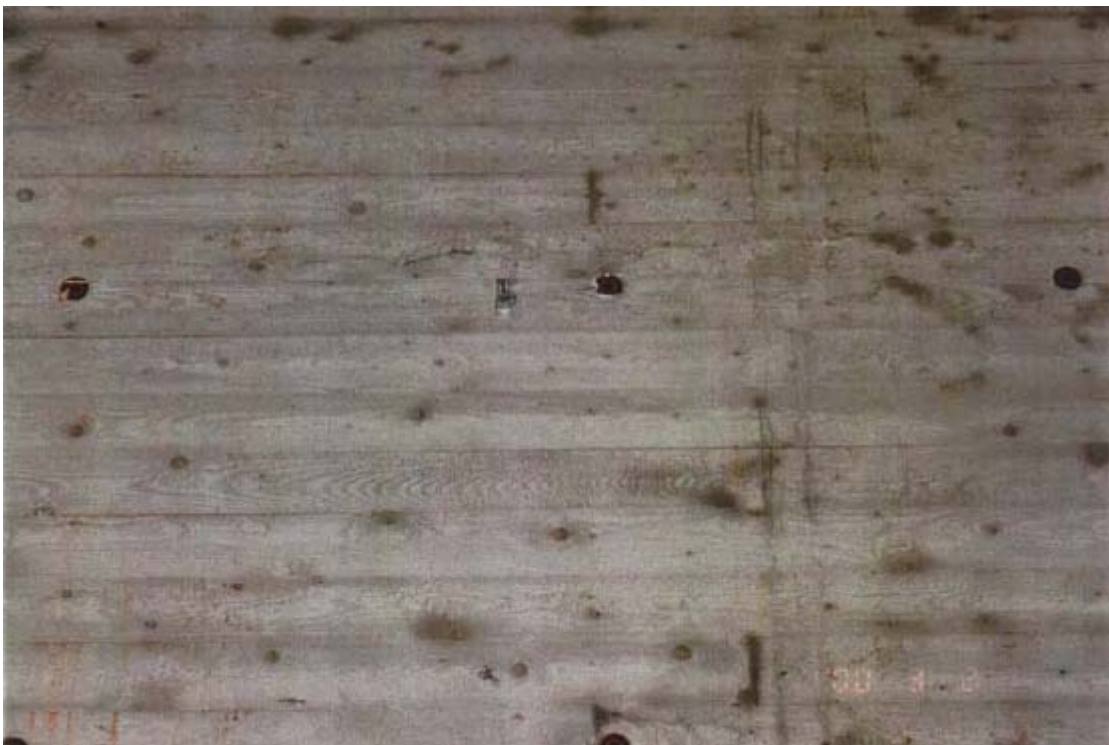
Fig. 18 Det nærmeste en kom til en synlig florand (like over stagrekken)
