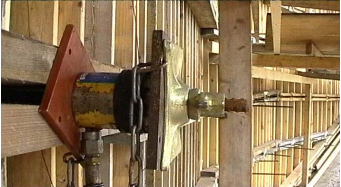
Fig. 9 Lastcelle montert under "klokka" på AZ-staget for måling av forskalingstrykk
