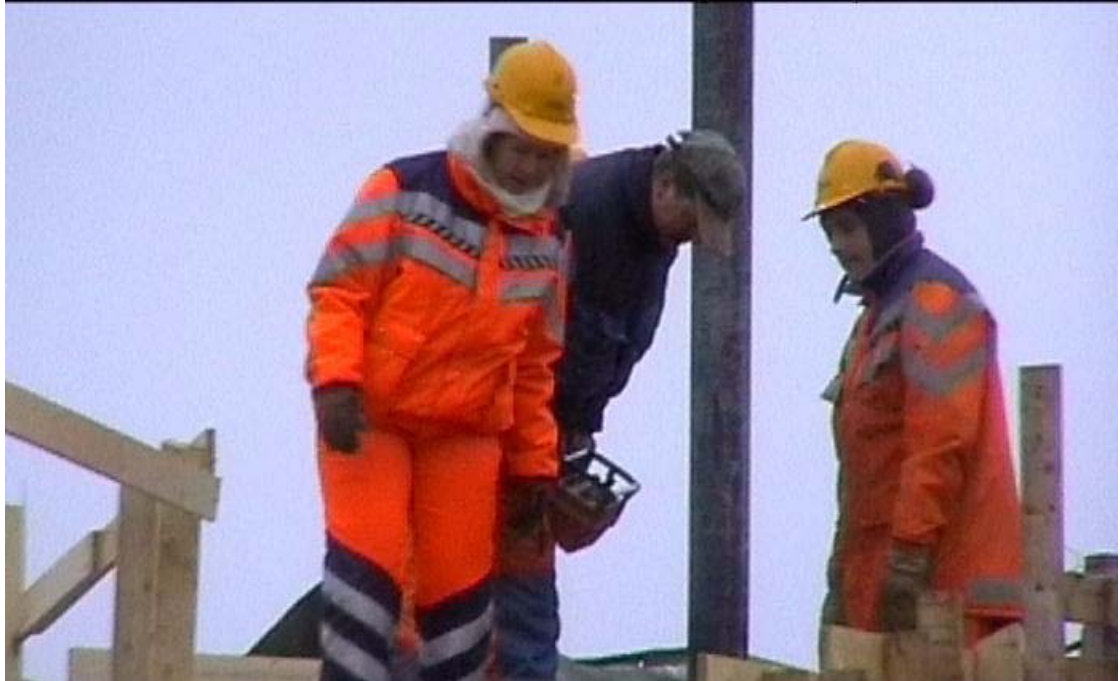
Fig. 7 Utstøping av vibreringsfri betong
