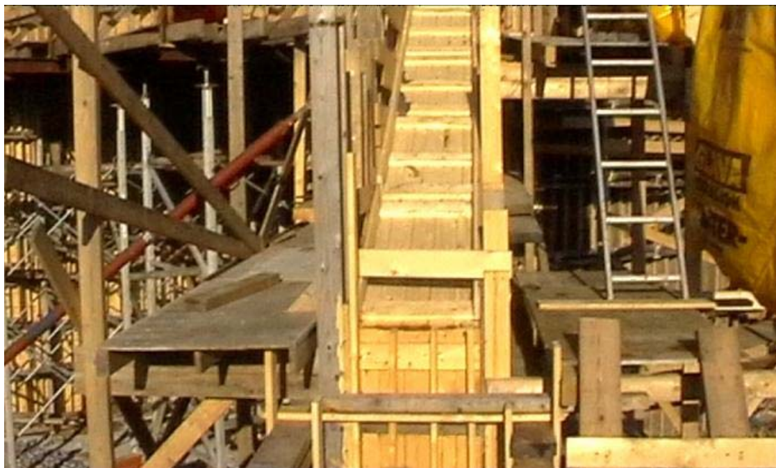
Fig. 11 Overforskaling på vingemur
