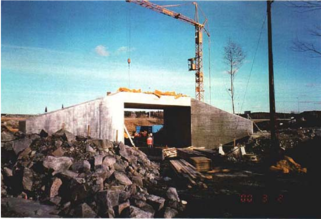
Fig. 13 Søndre Bjørnstad bru ferdig støpt, sett fra vest
