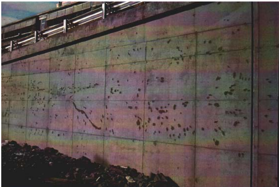
Fig. 33. Alle porer over 15 mm sparklet, uten at det er blitt særlig vakrere.
