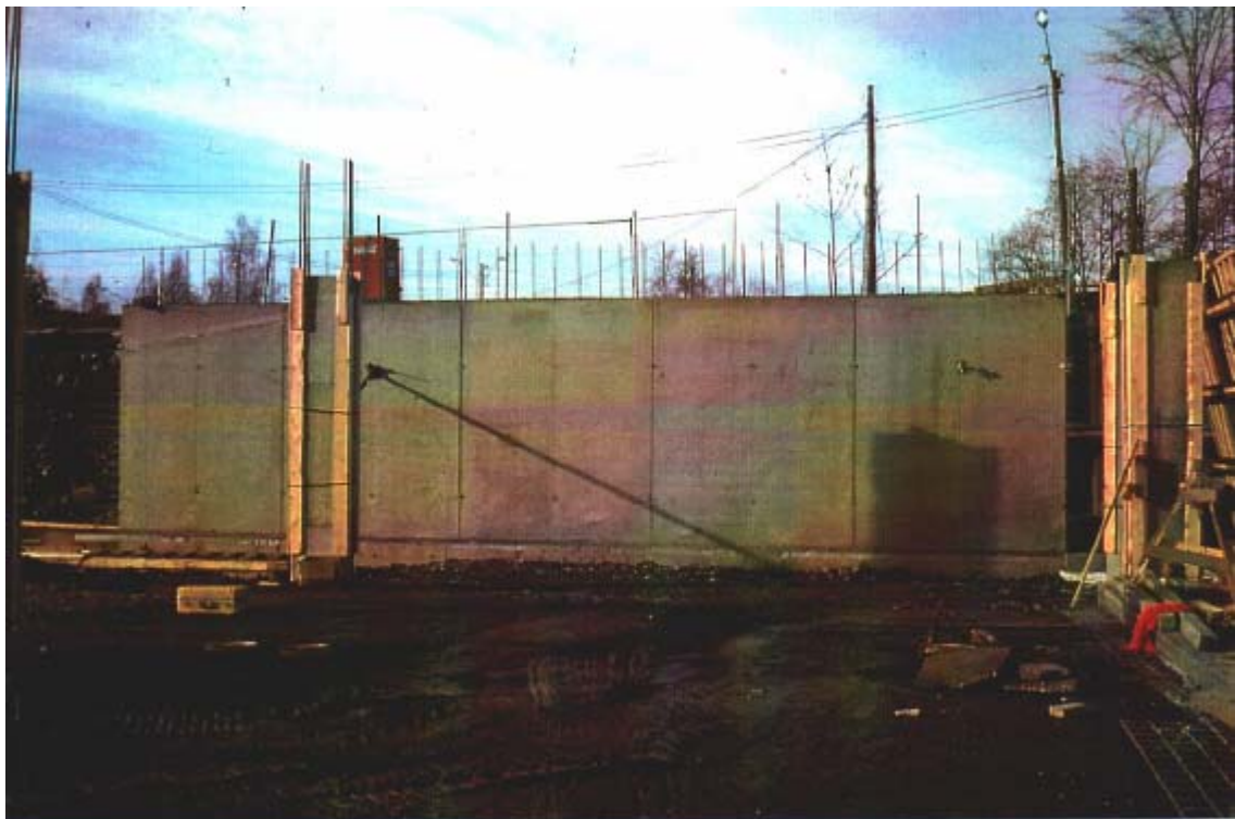
Fig. 32. Hjørnebeskyttelse med bord montert på ferdige søyler i byggetida.
