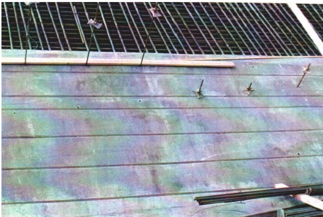
Fig. 6. Overflate av 45° skrå vegg støpt mot forskalingsduk Formtex.
