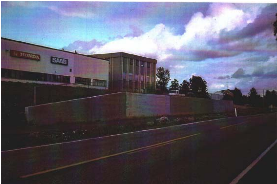
Fig. 30. Da forskalingen for støpeavsnitt 1 og 3 fra venstre ble revet var det tørrvær, for avsnitt 2 og 4 regnvær.
