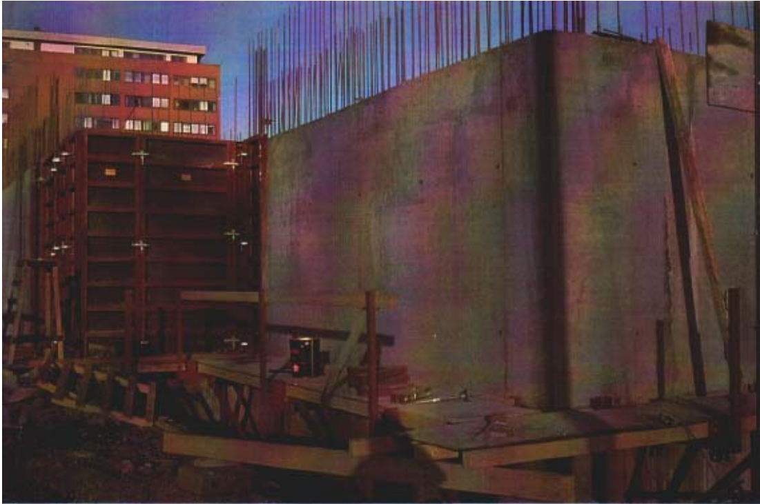
Fig. 19. Normal, velproporsjonert betong kan gi pene overflater, dersom øvrige vilkår er oppfylt.
