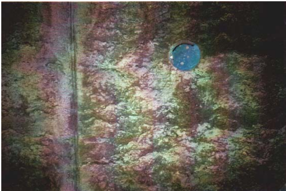
Fig. 18. Resultat av dårlig blandet, fillerfattig C25 med ekstrem vannutskillelse.
