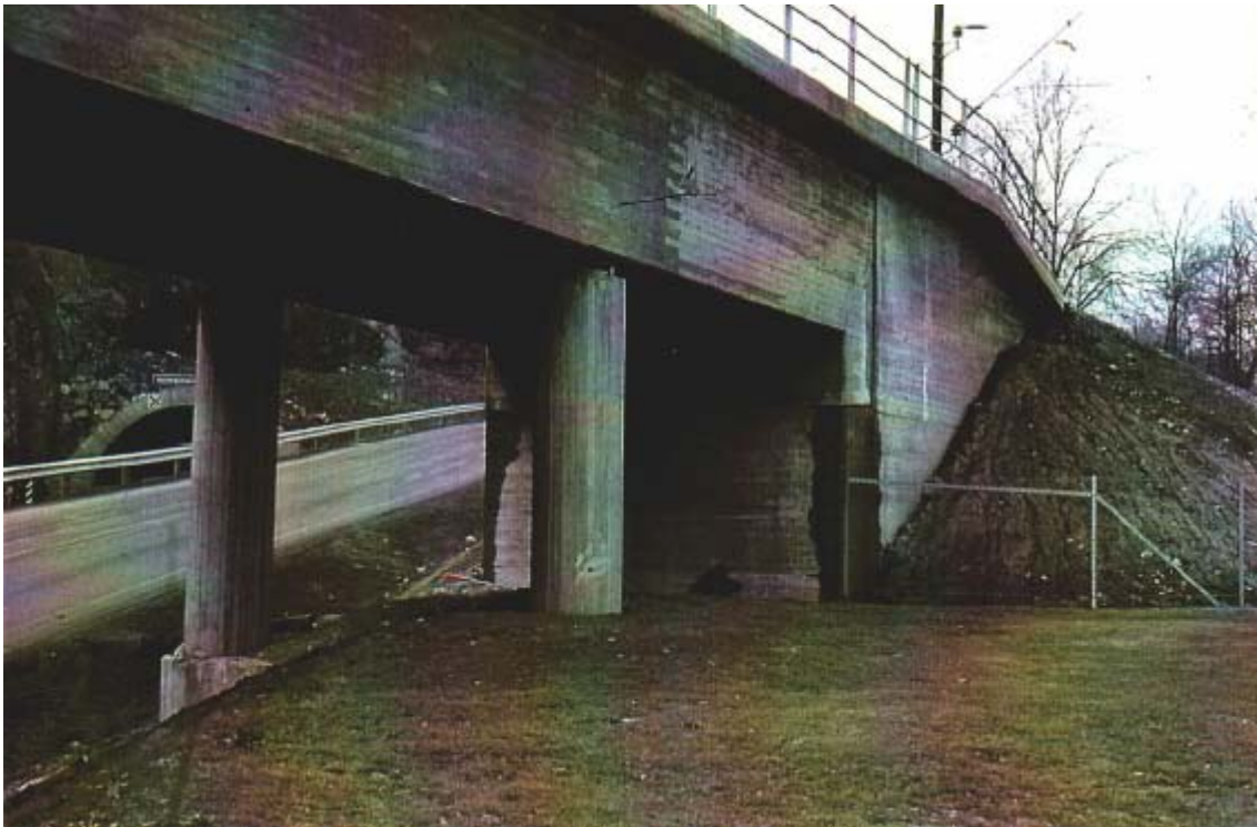
Fig. 4. Bord som har ligget "i solsteiken" gir annen farge enn bord som har vært skjernet mot sol.
