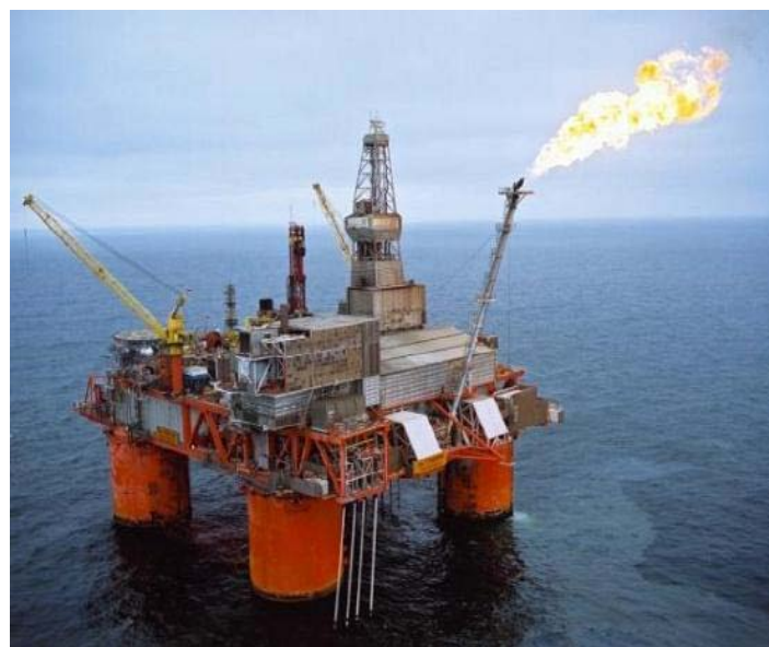
Figur 3.3 Snorre A-plattformen (Kilde: Statoil).
