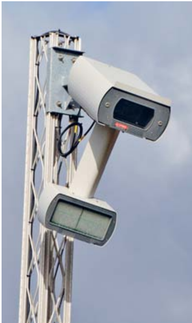
Kjelde: Knut Opeide, Statens vegvesen
