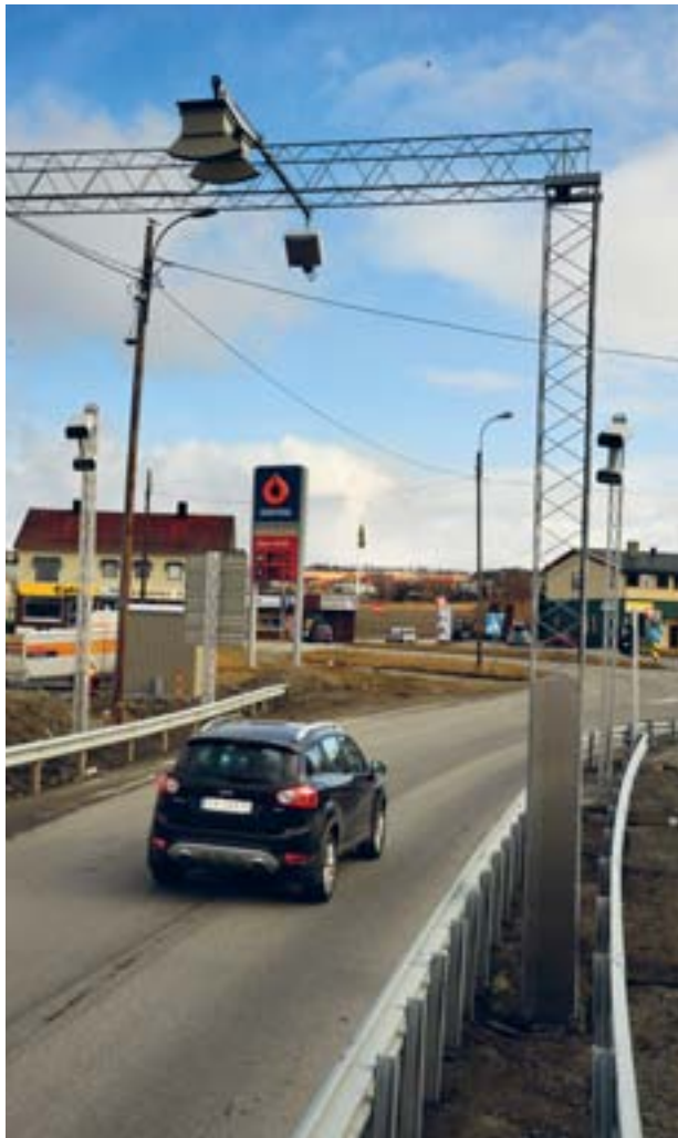
Kjelde: Knut Opeide, Statens vegvesen
