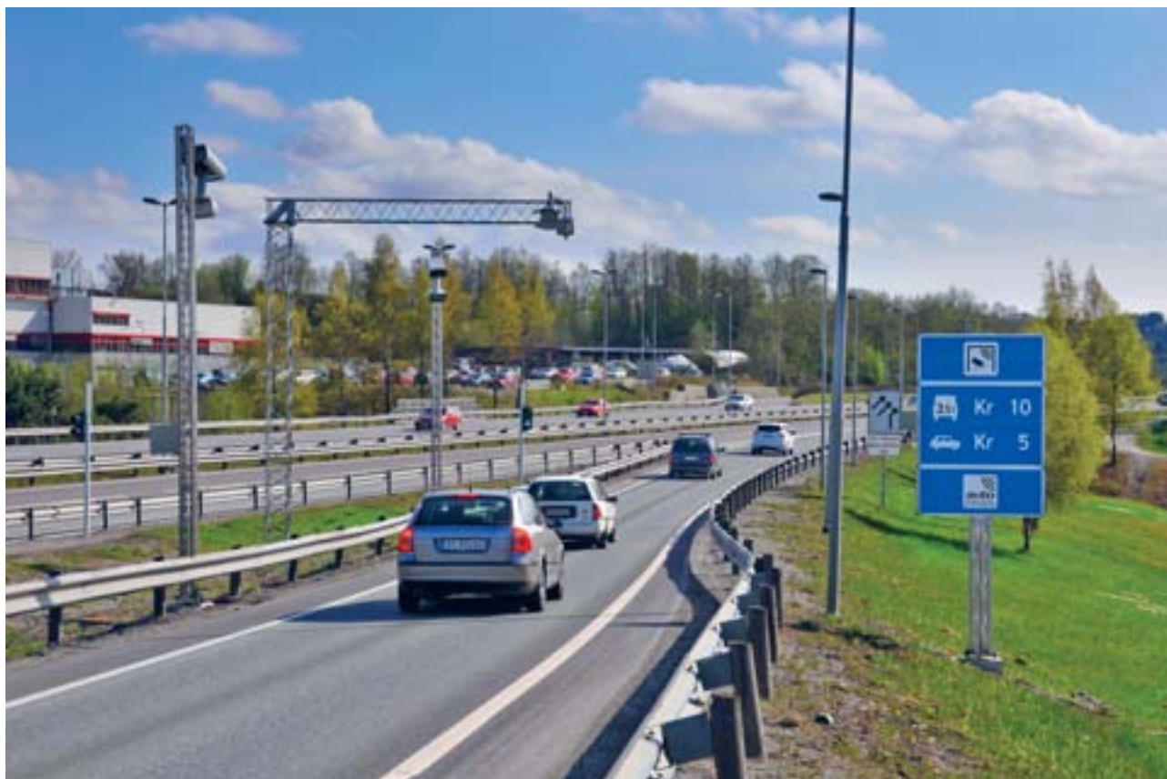
Kjelde: Knut Opeide, Statens vegvesen
