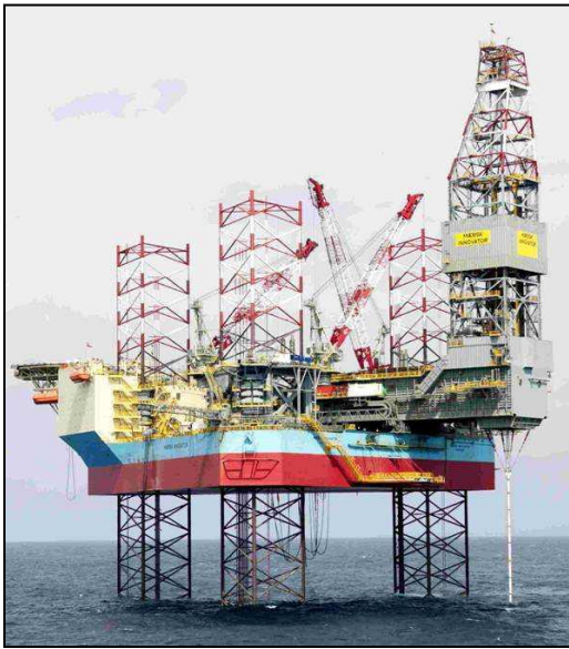
Figur 33. Oppjekkbar borerigg som kan benyttes til boring av brønnene.(ConocoPhillips, 2011)
