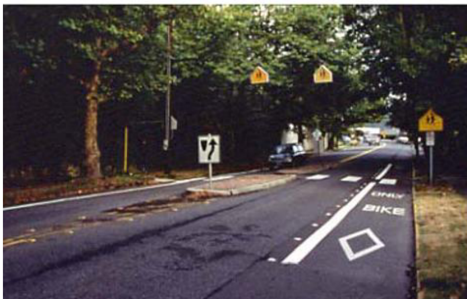
Figur 2.18: Sideforskyvning ved midtøy med kantstein i Minneapolis, Minnesota, USA. Kilde. Fitzpatrick (2003).
