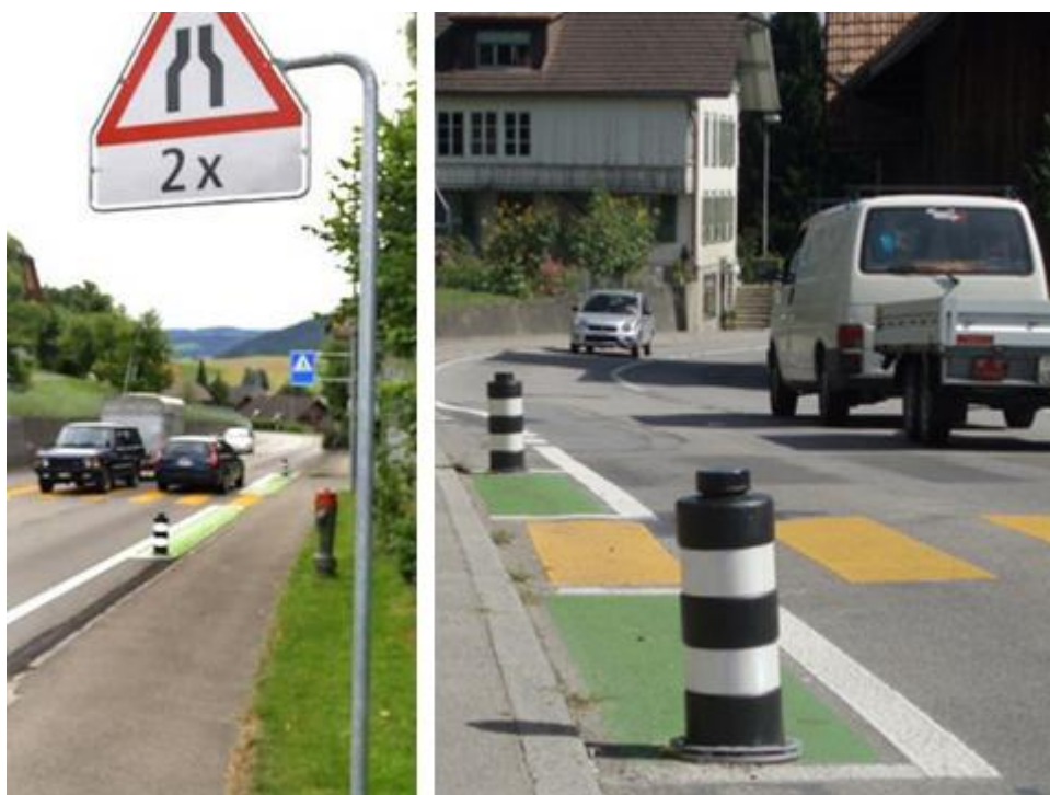
Figur 2.8: Innsvnevring av kjørefelt ved fotgjengerovergang i Zäziwil, Sveits. Kilde venstre bilde: http://www.bernerzeitung.ch/region/kanton-bern/Autofahrer-sabotieren-Versuch-fuer-sichere-Fussgaengerstreifen/story/19678018 . Kilde høyre bilde: http://www.bern-ost.ch/index.php?p=50&q=14735
