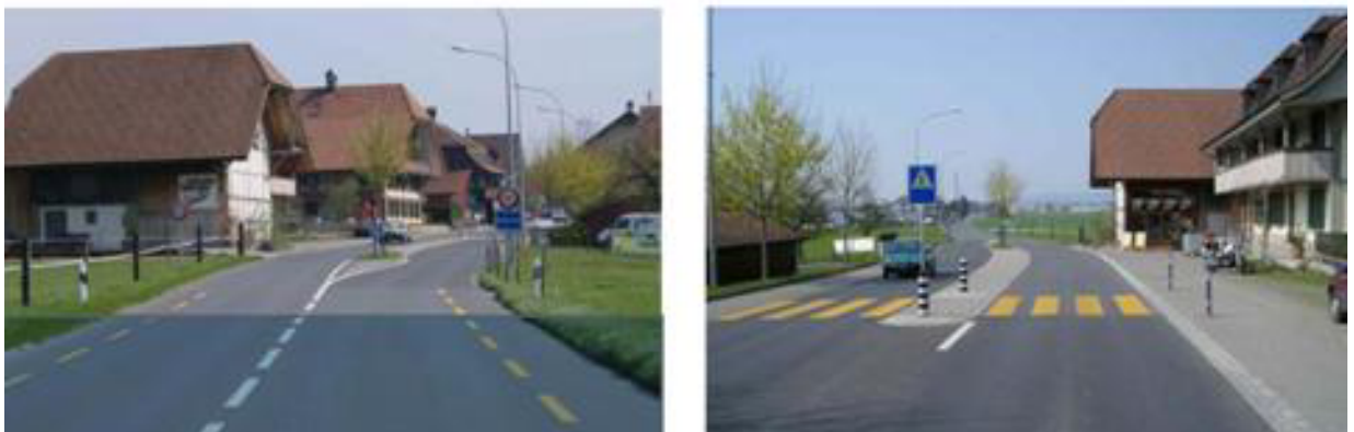
Figur 2.12: Sideforskyvning, i Untere Hauptstrasse, Niederwitrach; på veg inn i tettstedet (t.v.) og ut av tettstedet (t.h.). Kilde: Beyeler & Roduner (2004).
