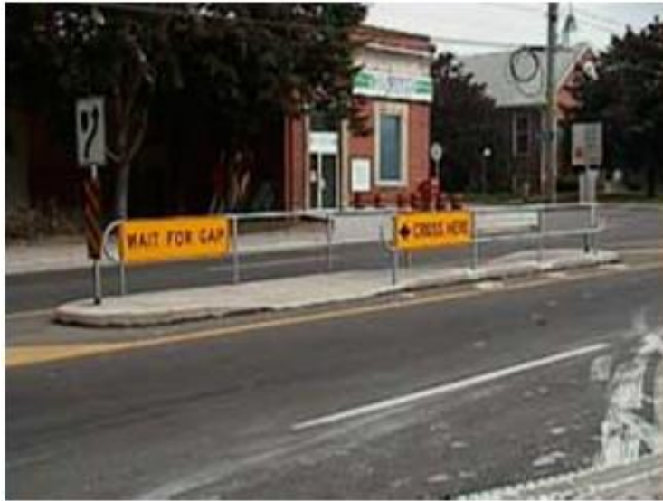
Figur 2.29: Sakset gangfelt i USA med advarsel for fotgjengere. Kilde: Bacquie et al. (2001).
