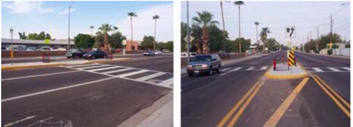
Figur 2.27: Sakset gangfelt i California, USA. Kilde: Fitzpatrick et al. (2003).
