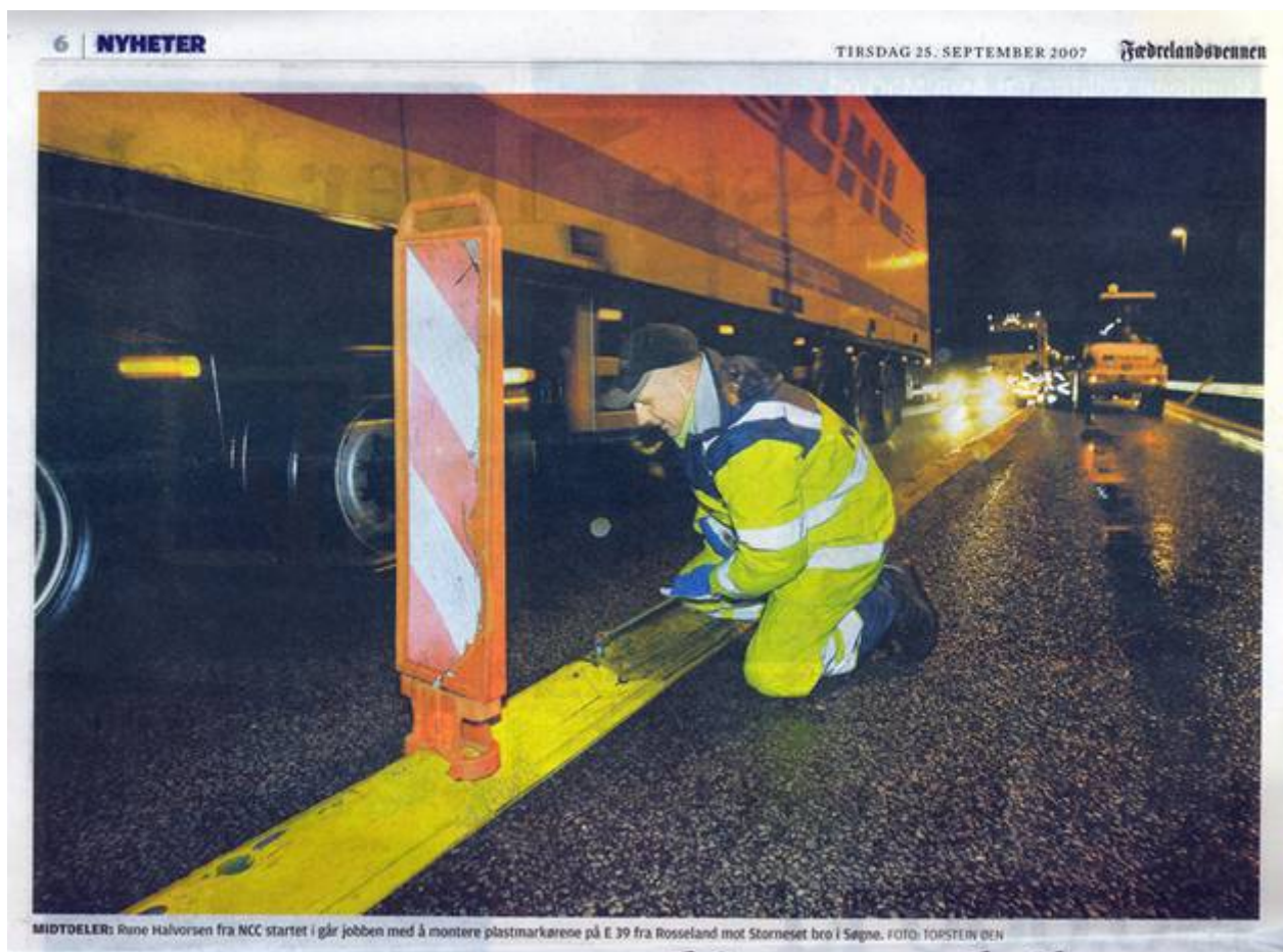
Figur 1: Montering av midtmarkeringen (Fædrelandsvennen, 25.09.07.)
