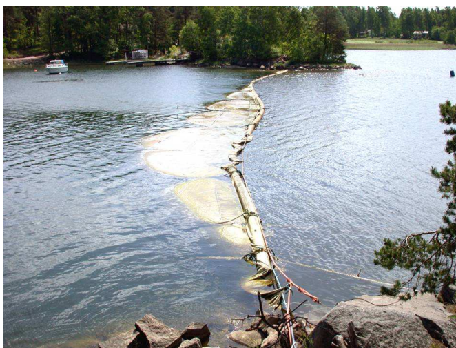
Figur 16. Siltgardin påvirket av strøm (Geir Arne Røstum, Rambøll)
