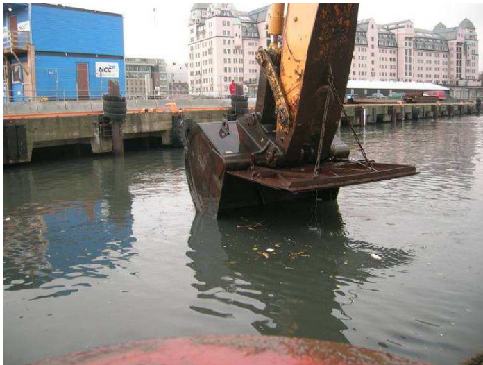
Figur 1. Bakgraver brukt i Oslo havn, skuffen visis hydraulisk til den er i kontakt med lokket (Secora)
