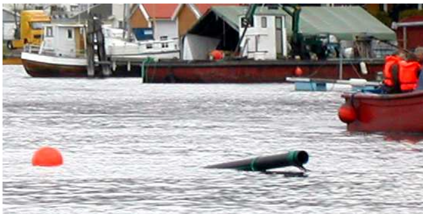
Figur 23. Påfyllingsrør til geotekstilpose som ligger på sjøbunnen i Sandefjord (Geir Arne Røstum, Rambøll)
