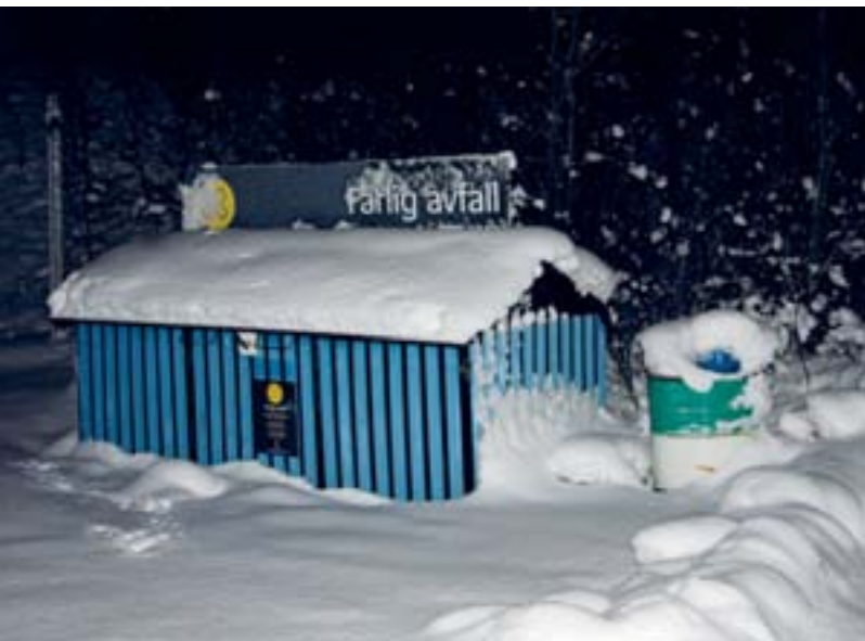
Vanskelig tilgjengelig ubetjent kommunalt mottak.
