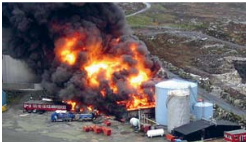
Eksplosjonen på Vest Tank-anlegget.
