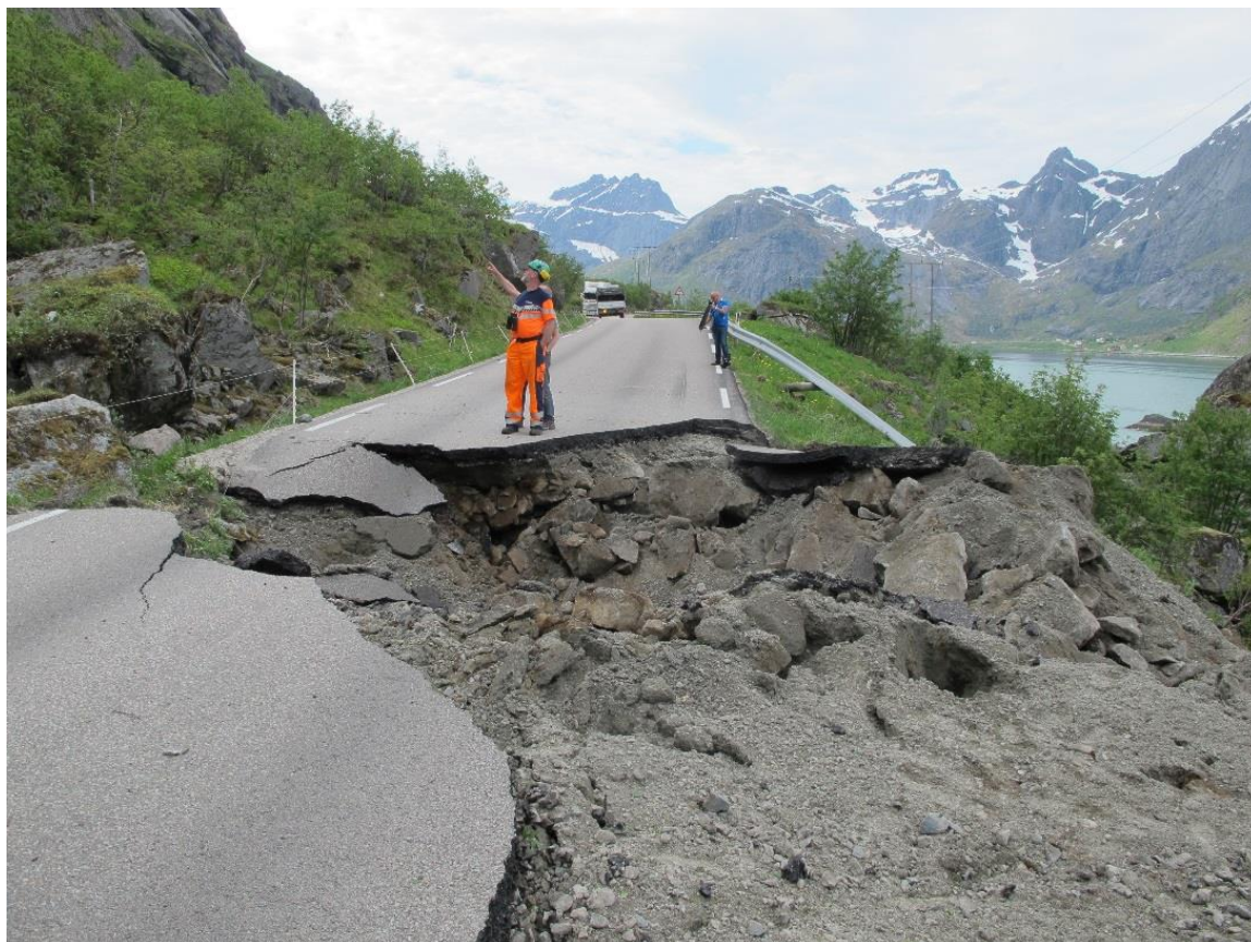
Steinskred ved Flakstadpollen juni 2014.
