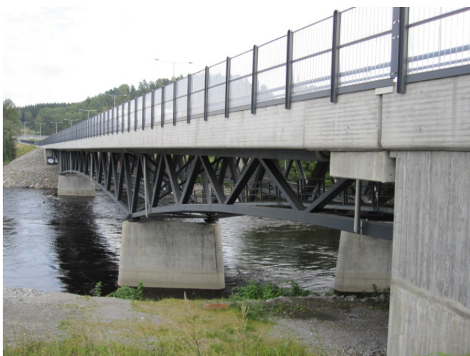
Figur 4 Eksempel på bru med fugefri løsning i en ende (foto: Gaute Nordbotten)
