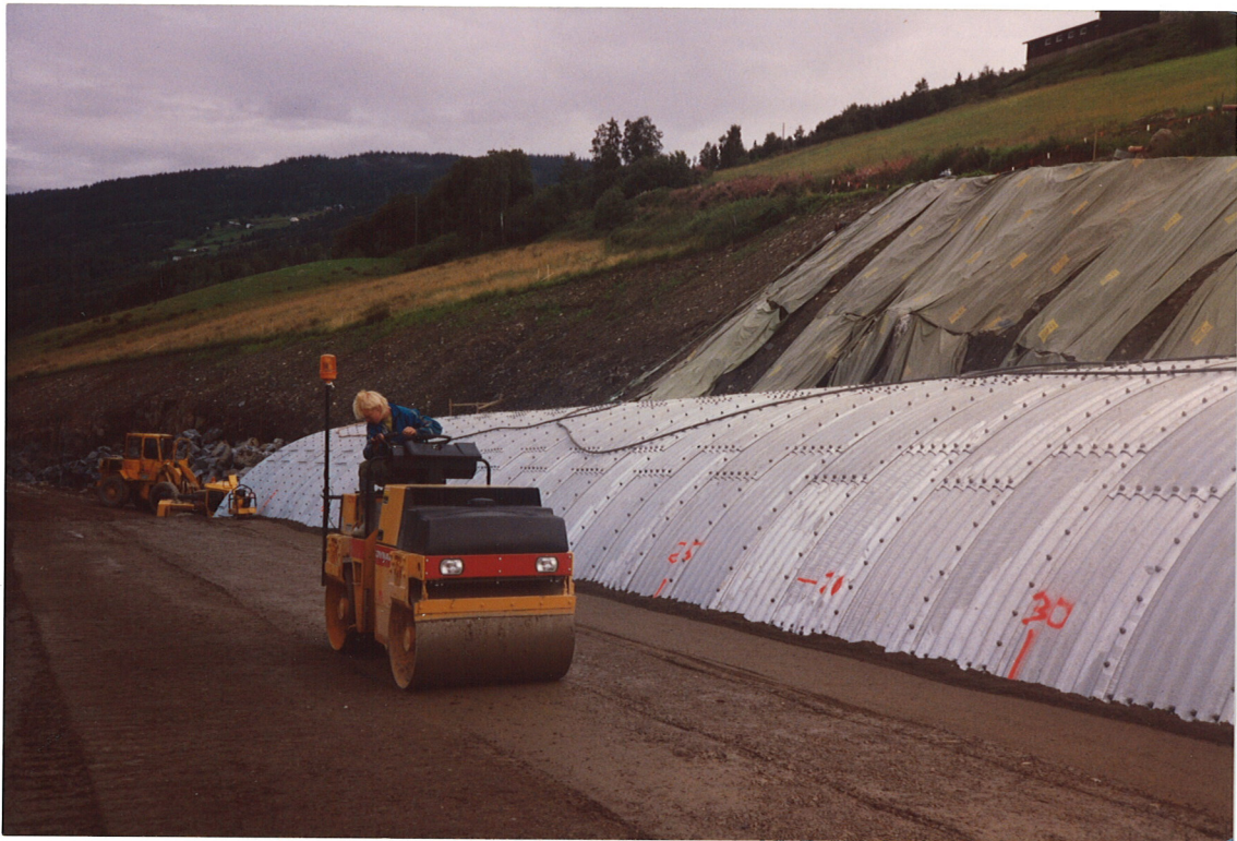
Bilde 19 Stålrør Hafjell. Komprimering pågår.
