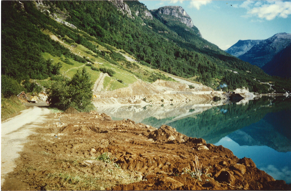
Bilde 11 Rasoverbygg Olden. Skredbanen for snøras på oversiden av rasoverbygget.
