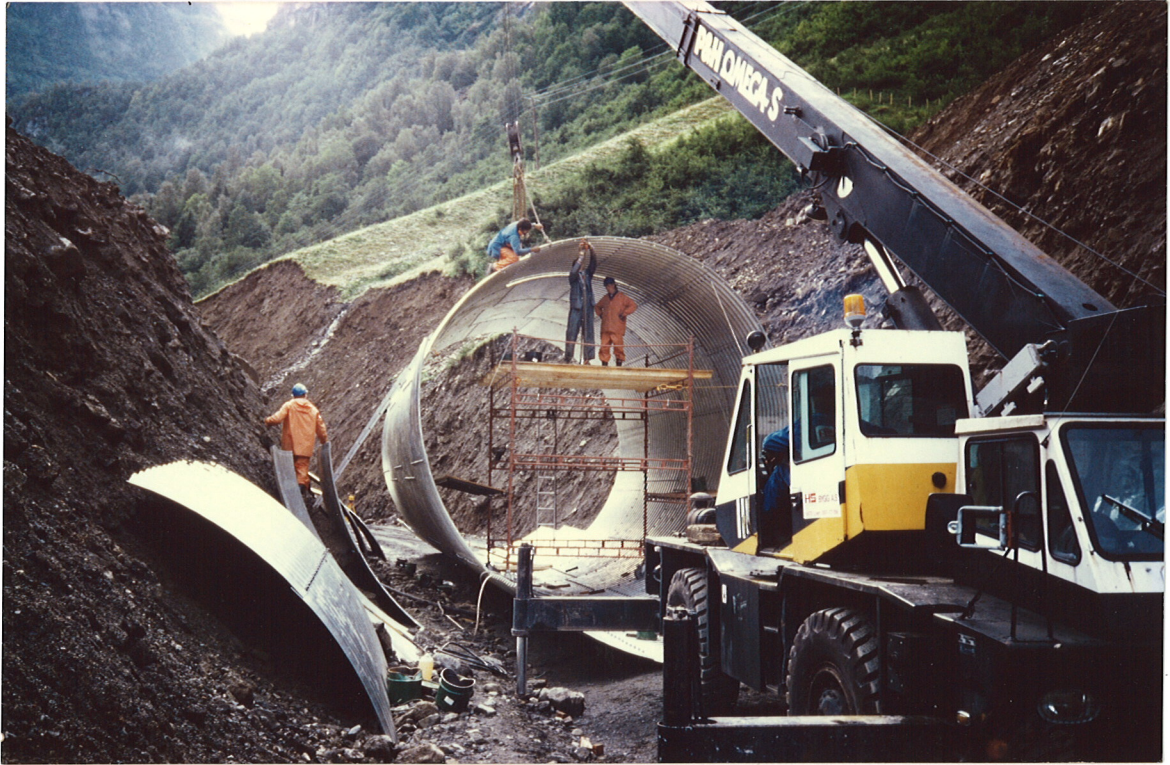
Bilde 7 Rasoverbygg Olden i Sogn og Fjordane under montering. Byggeår 1988.
