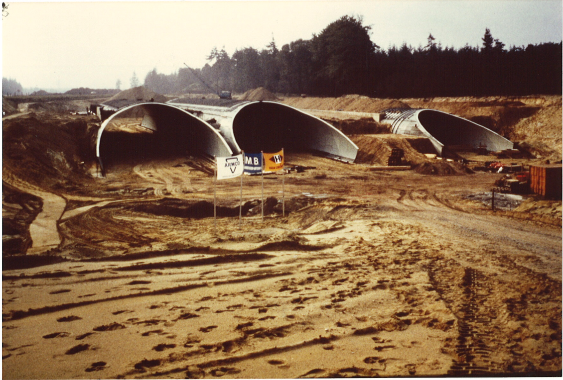
Bilde 21 Europas største stålrør under bygging i Holland i 1985. To stålbuer med bredde 16,1 m og en med bredde 12,0 m fundamentert på betongfundamenter.
