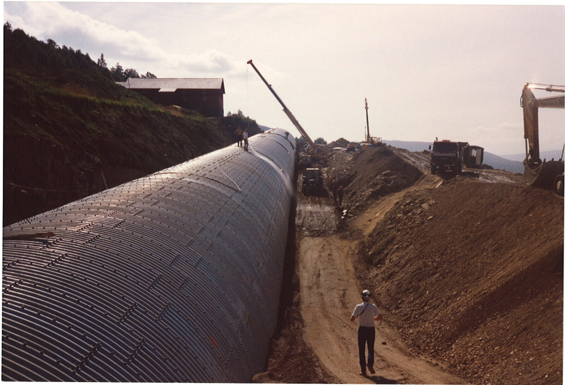
Bilde 17 Stålrør på Hafjell. Tilbakefylling pågår.
