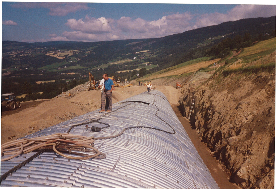
Bilde 18 Stålrør på Hafjell. Røret ble montert på 6 uker. Totalt er det 400 tonn med stål.
