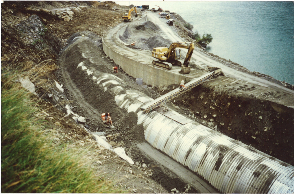
Bilde 9 Rasoverbygg Olden under tilbakefylling. Gammelt betongoverbygg ved siden av.
