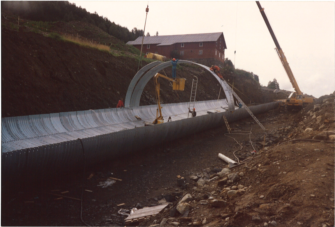
Bilde 15 Stålrør på Hafjell. Gjennomføring for fylkesveg under slalåmløypa. Byggeår 1988.
