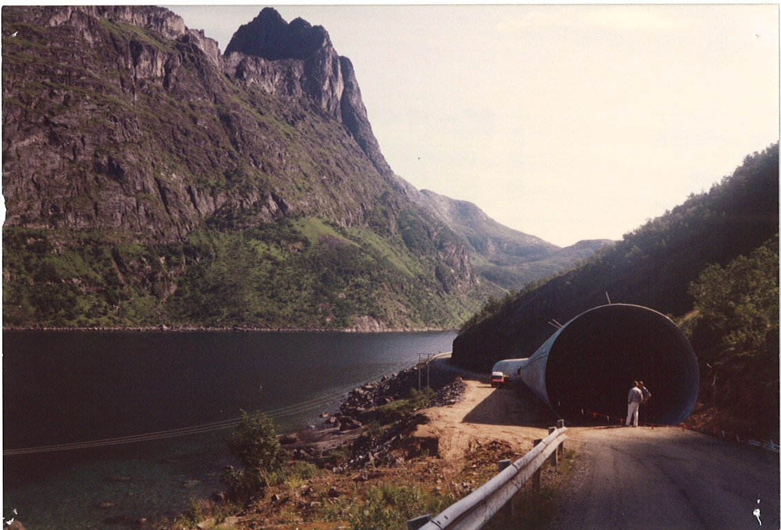
Bilde 12 Rasoverbygg Senja (Fjordgård) i Troms. Byggeår 1988. Rasoverbygget er ferdig montert før overfylling.
