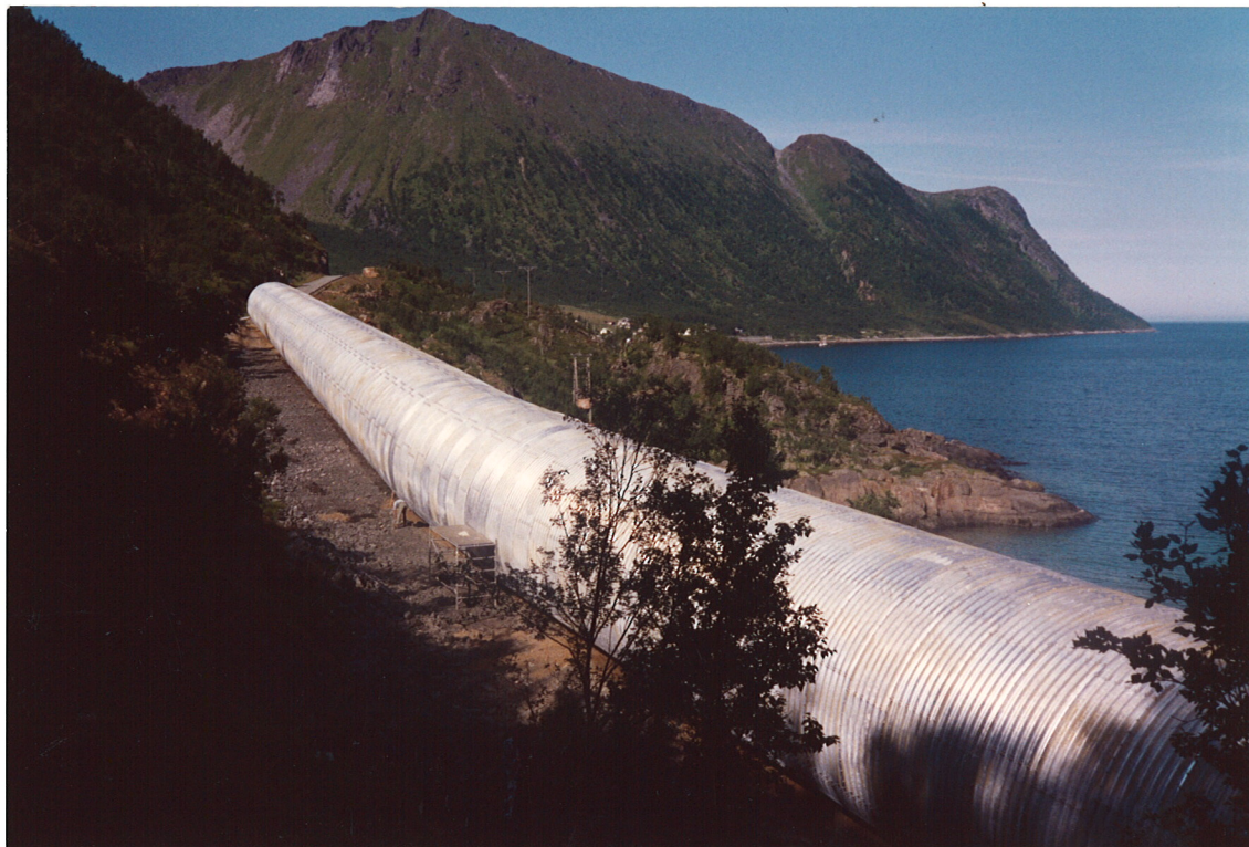
Bilde 13 Rasoverbygg Senja. 170 m stålør ble montert på 18 dager.
