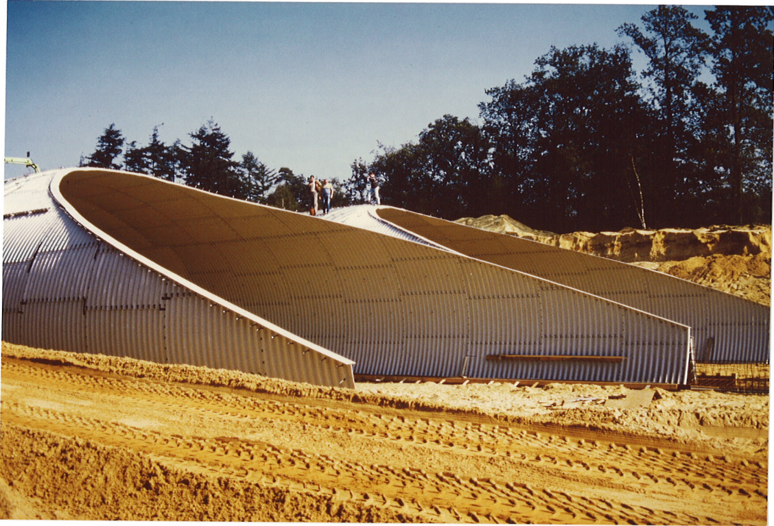
Bilde 23 Endeavslutning med helning 1:3.
