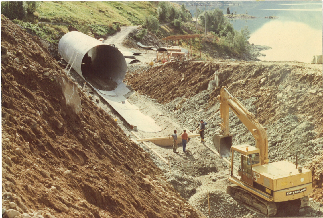
Bilde 1 Rasoverbygg Veitastrond under bygging. Byggeår 1983.
