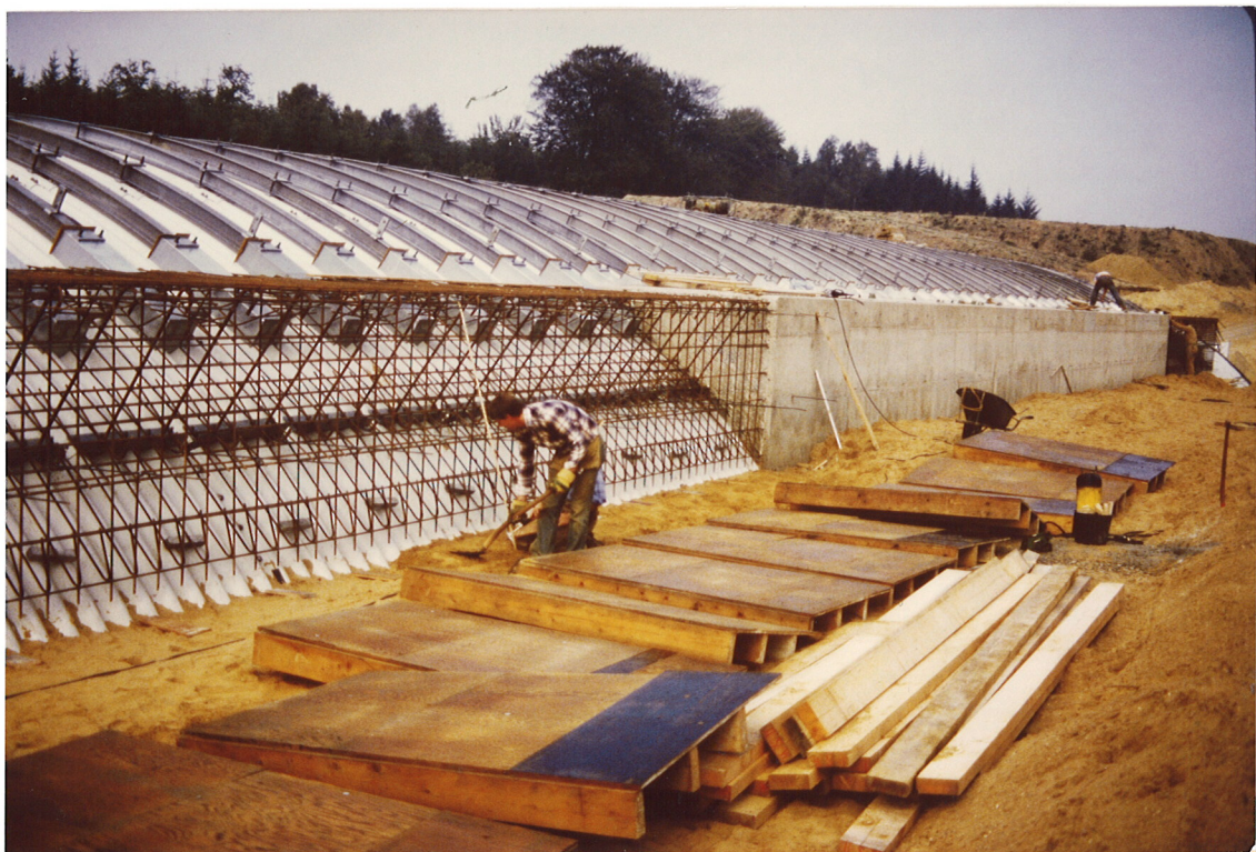
Bilde 24 Både langsgående trykkbjelker av betong og tverrgående stålbjelker ble brukt på grunn av stort tverrsnitt.
