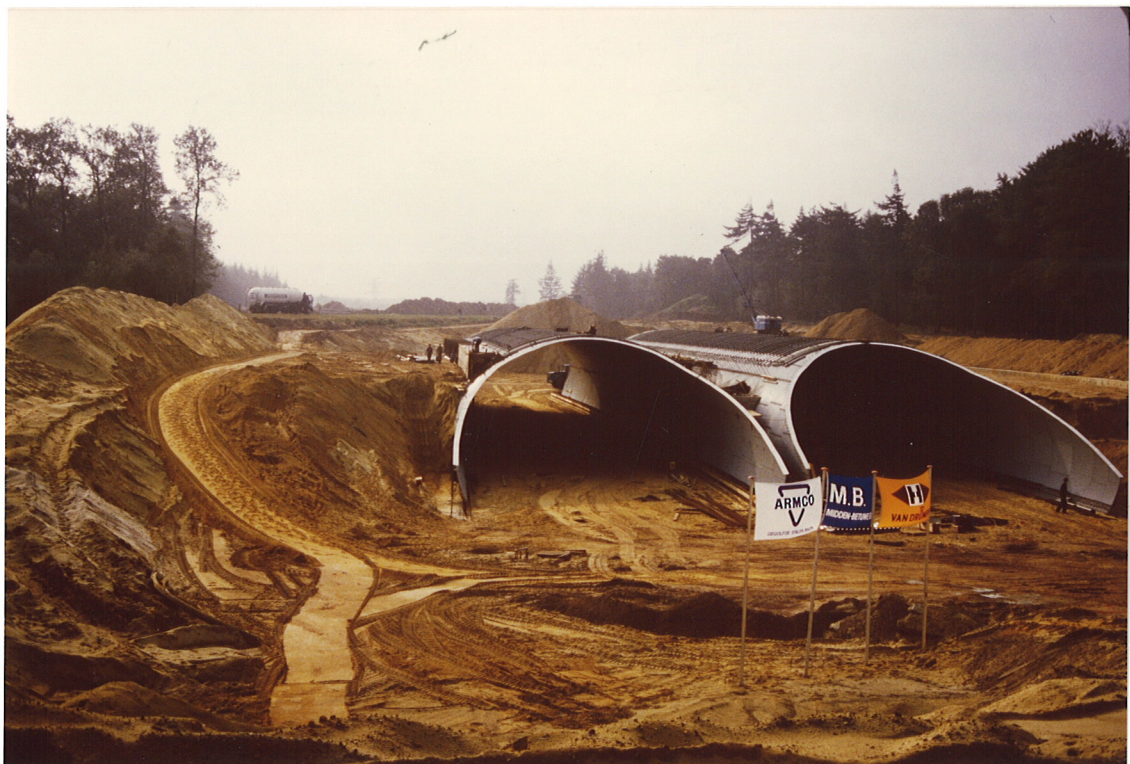
Bilde 22 Tilbakefylling med stedlige masser bestående av sand.
