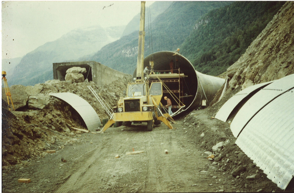
Bilde 8 Rasoverbygg Olden under montering. Merk gammelt betongoverbygg ved siden av.
