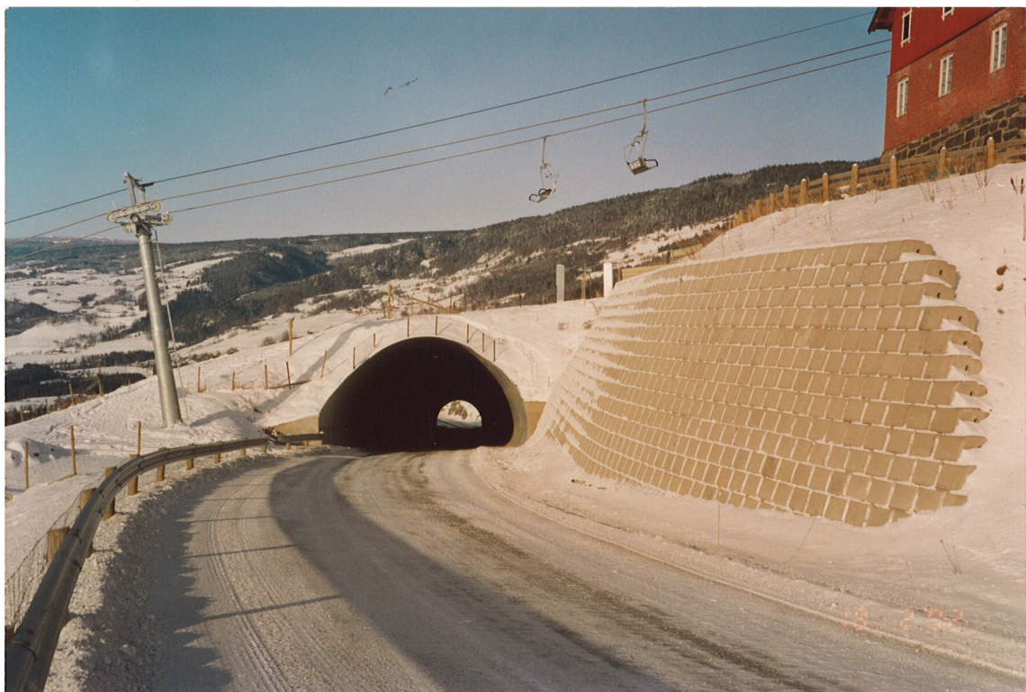
Bilde 20 Stålrør Hafjell. Ferdig bygd vegtunnel. Trønderblokkmur med høyde 8,5 m og armert med Televeg 150 jordarming.
