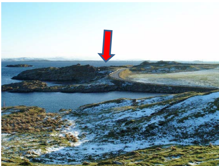
Figur 22: Ved Kvitsøy blir ventilasjonssjaktene plasserte ved teknisk bygg like ved tunnelinnslaget på Kråkøy
