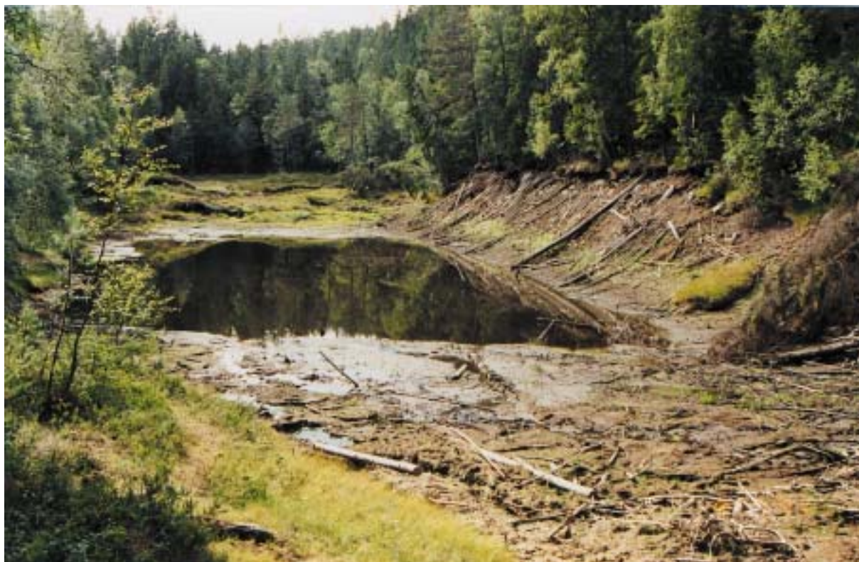
Figur 3.1: Puttjern i Østmarka i Oslo etter at lekkasjeskader oppstod og før avbøtende tiltak ble satt i verk. (Foto: Lars Erikstad)
