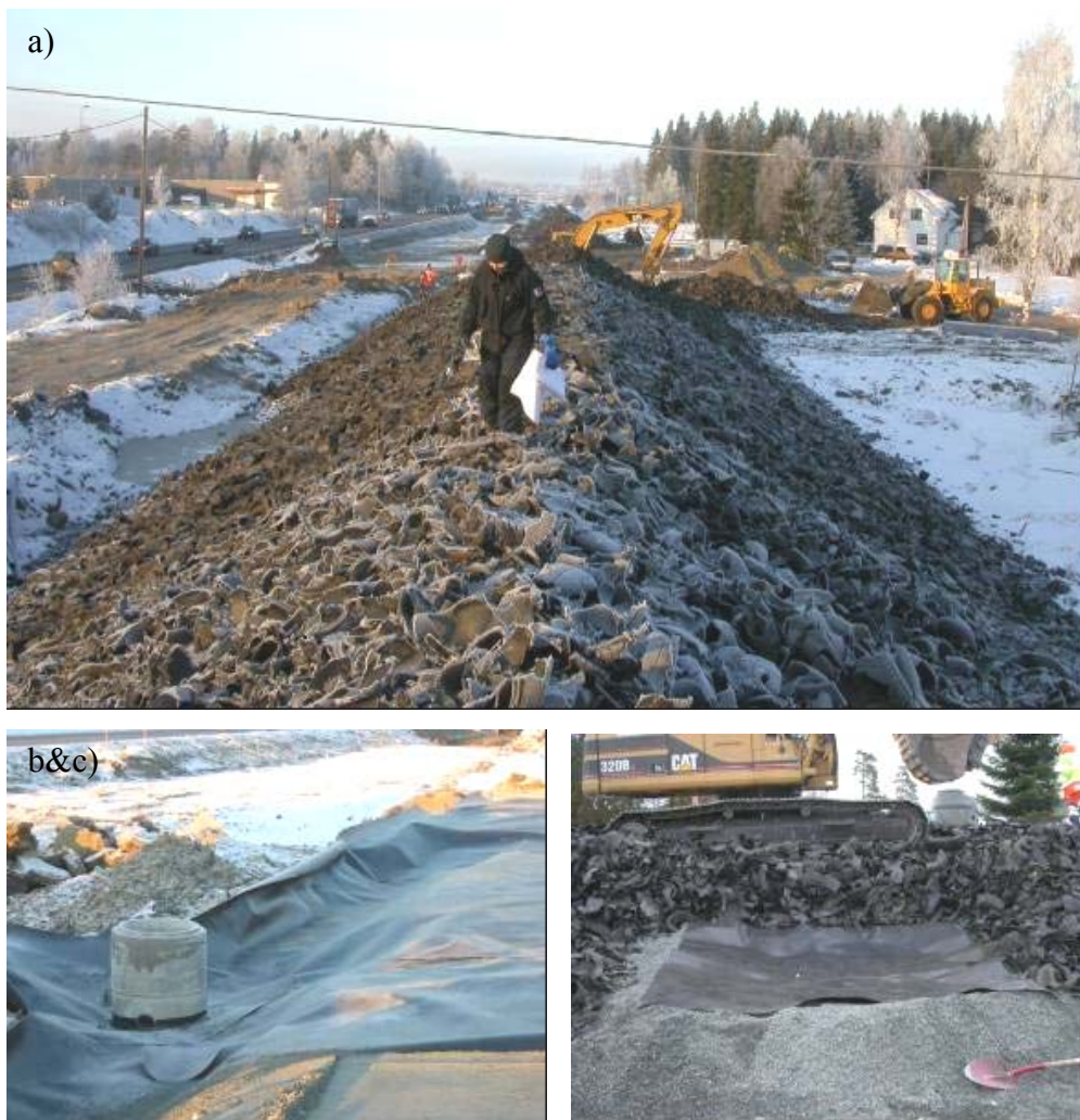
Figur 4. a) Første seksjon med oppkuttete bildekk er lagt. Materialet skal dekket med bentonittmembran og jord. b&c). Oppsamling av vann under og i seksjon 3
