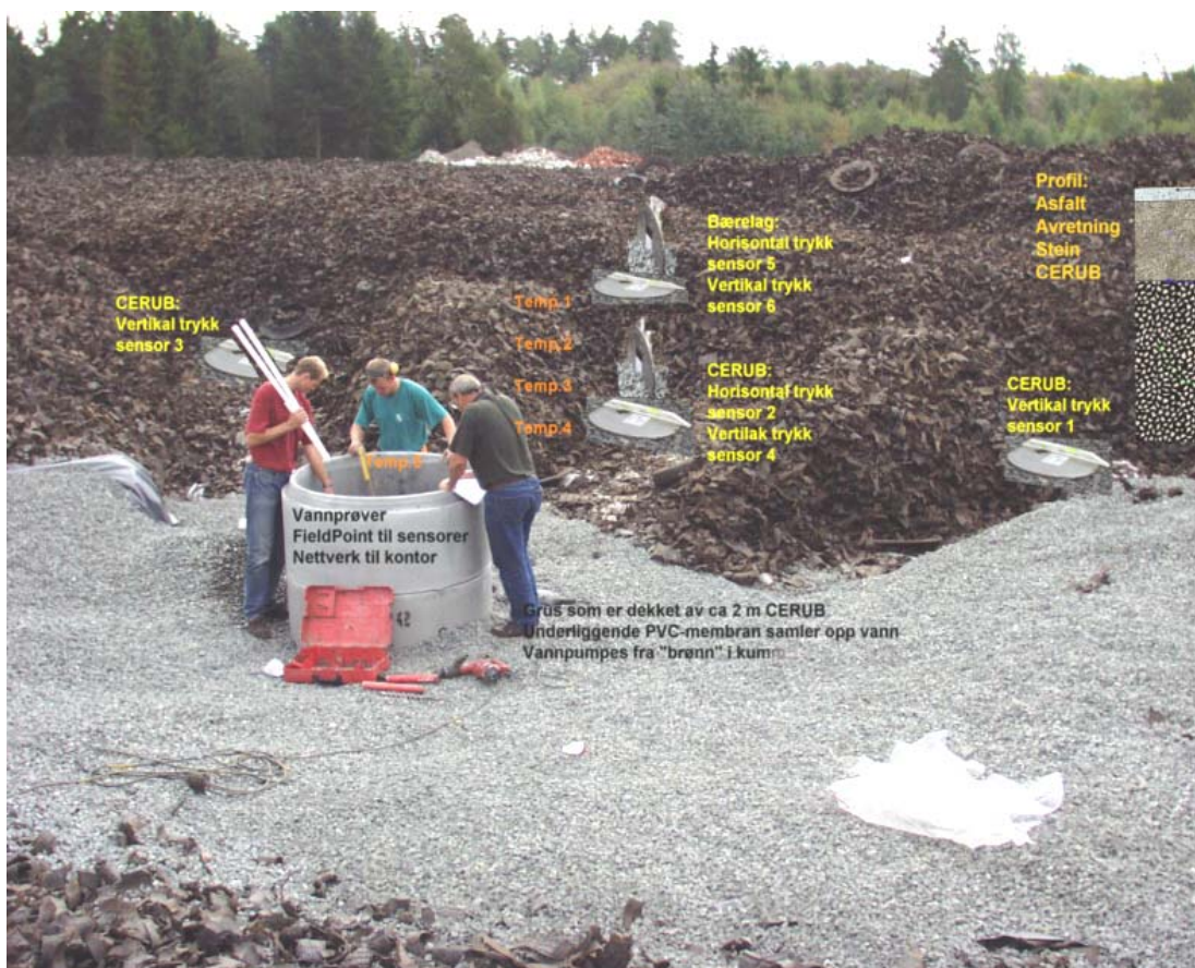
Figur 8. RagnSells område ved Solgård avfallsplass ved Moss. Lysimeter og trykksensorer anlegges og tilknyttes kum.
