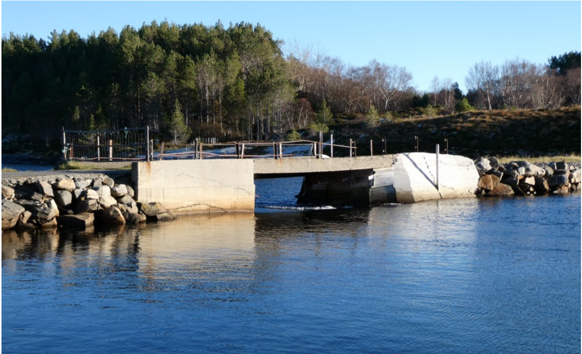
Figur 16. Den indre landbruksbrua ved utløpet av Sandblåstvågen. Løpet er smalt og påvirker vannutskiftningen i våtmarkssystemet vesentlig. Foto: Arnstein Gjeldnes.
