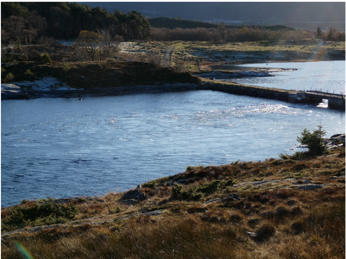
Figur 17. Den indre landbruksvegen og brua sett litt på avstand. Den kraftige strømmen som oppstår ved brua under overganger mellom flo og fjære dokumenterer effekten av brua på vannutskiftningen. Foto: Arnstein Gjeldnes
