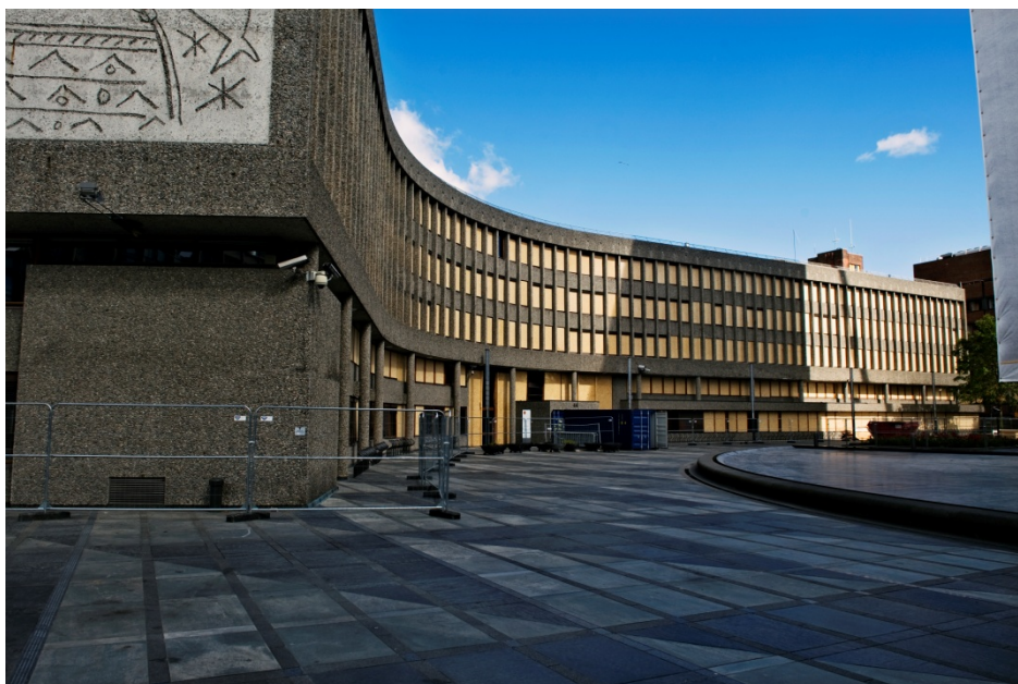
Fasaden på Y-blokken inn mot Høyblokken
