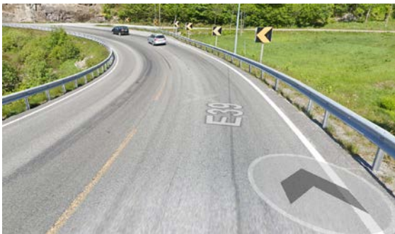
Horisontalkurve radius: 52 meter Kjørefeltbredde: 3,0-3,1 meter
