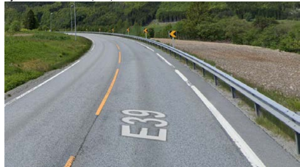
Horisontalkurve radius: 205 meter Kjørefeltbredde: 3,3 meter
