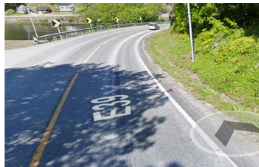
Horisontalkurve radius: 115 meter Kjørefeltbredde: 3,0-3,1 meter
