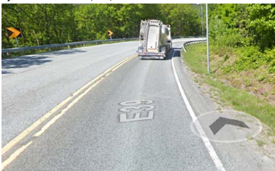
Horisontalkurve radius: 153 meter Kjørefeltbredde: 3,6-3,7 meter
