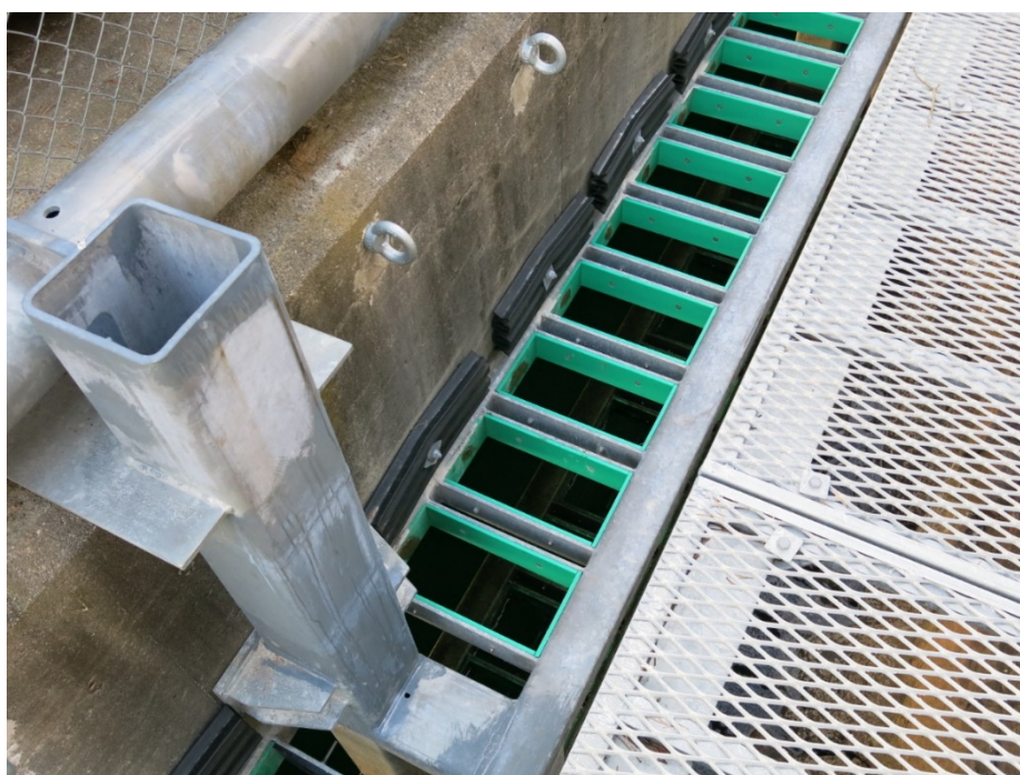
Figur 8 Opphengersramme. Innsiden av hvert spor/kontaktpunkt er kledd med polyetylen-plater (grønne) som trykkfordelende og dempende materiale.
