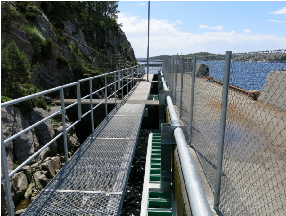
Figur 10 Ferdig installert opphengsramme, gangbane og gjerde med porter.
