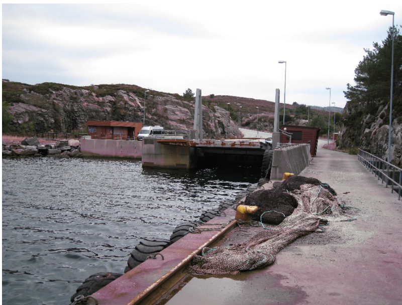
Figur 3 Austefjorden fergekai, bilde før etablering av feltstasjon.
