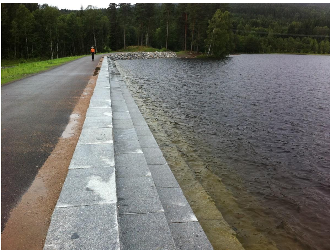
Figur 7-2. Dam Sognsvann etter rehabilitering.
