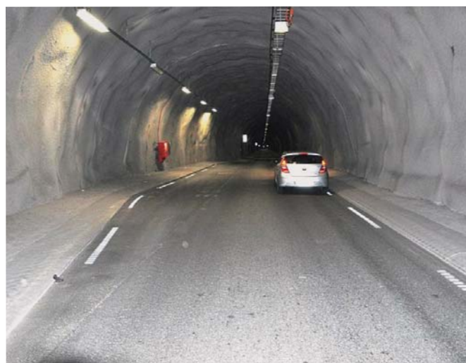
Bilde fra Talgjetunnelen (åpnet 2009) som har samme tverrsnitt som planlagt tunnel. Her avbildet ved en møteplass.
